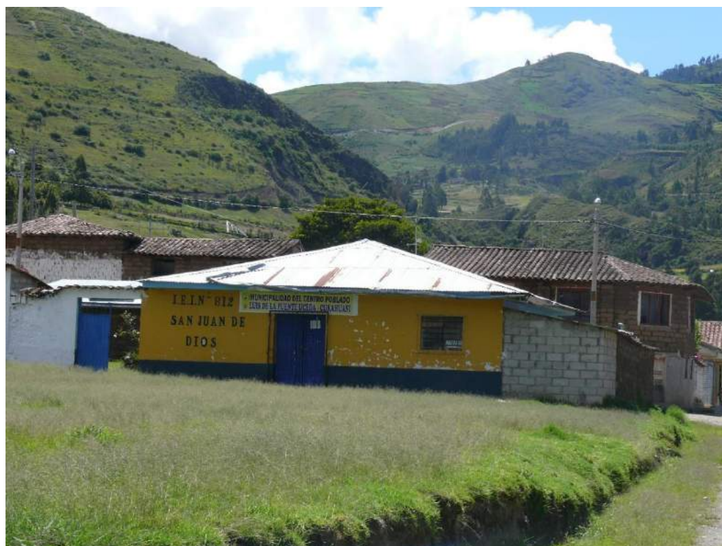
IE. San Juan de Dios, CC Luis de la Puente Uceda, sector San Juan de Dios. (Municipalidad del Centro Poblado Luis de la Puente Uceda). Sector San Juan de Dios.
