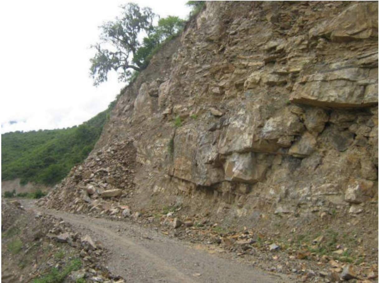
Figura 4 – Afloramiento de areniscas cuarzosas de la Fm. Hualhuani en el tramo de la Carretera Curahuasi-Puente Cunyacc, en el distrito de Curahuasi, provincia de Abancay
