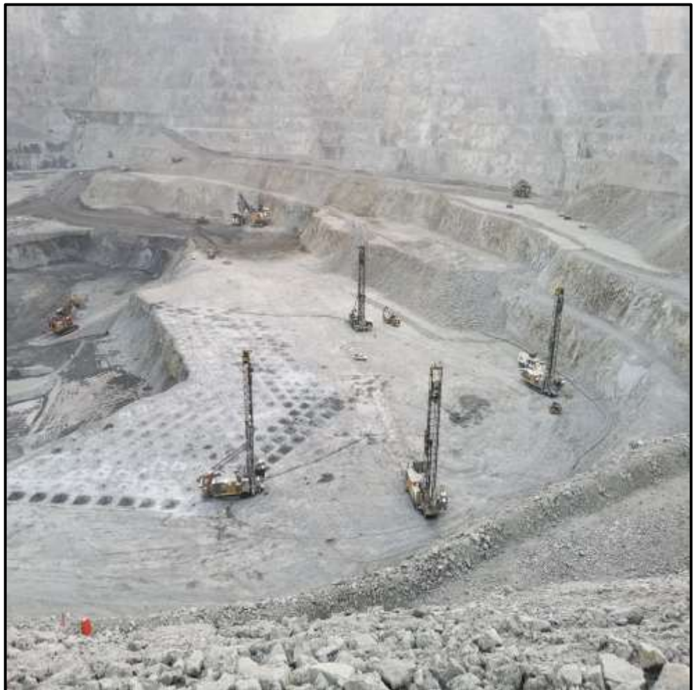
Figura 10 — Proceso de Perforación en el Tajo Ferrobamba
