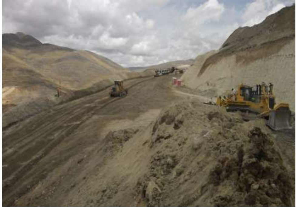
Figura 58 — Rebatido de la carpeta de rodadura para mantener una superficie adecuada de la vía
