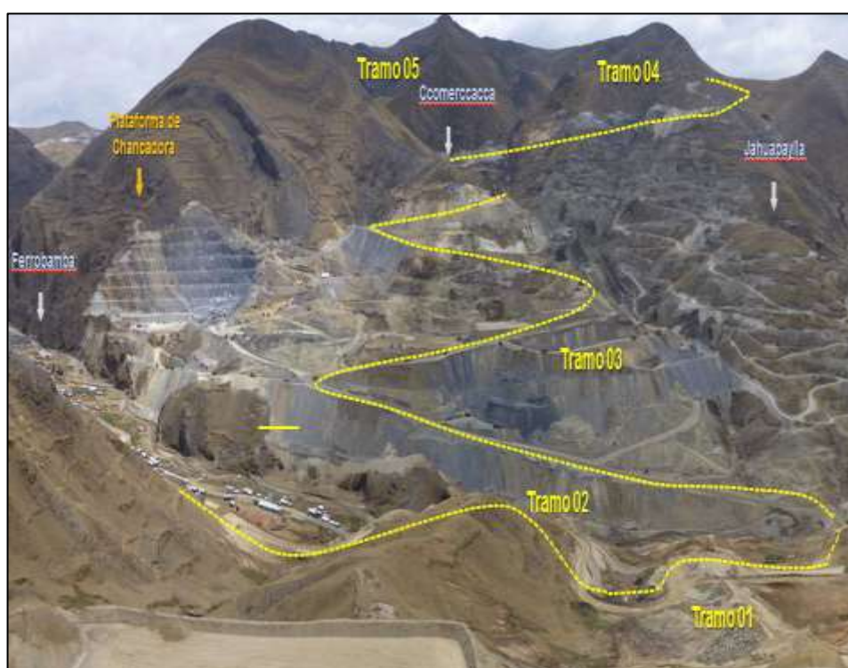
Figura 6 — Proceso de desbroce y construcción del tajío Ferrobamba
