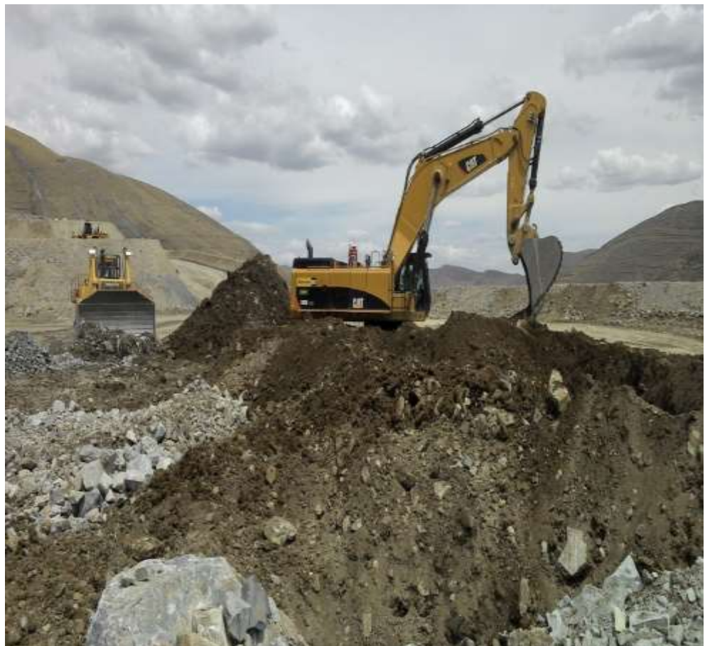
Figura 55 — Excavación y reemplazo del material inadecuado por material competente en la vía
