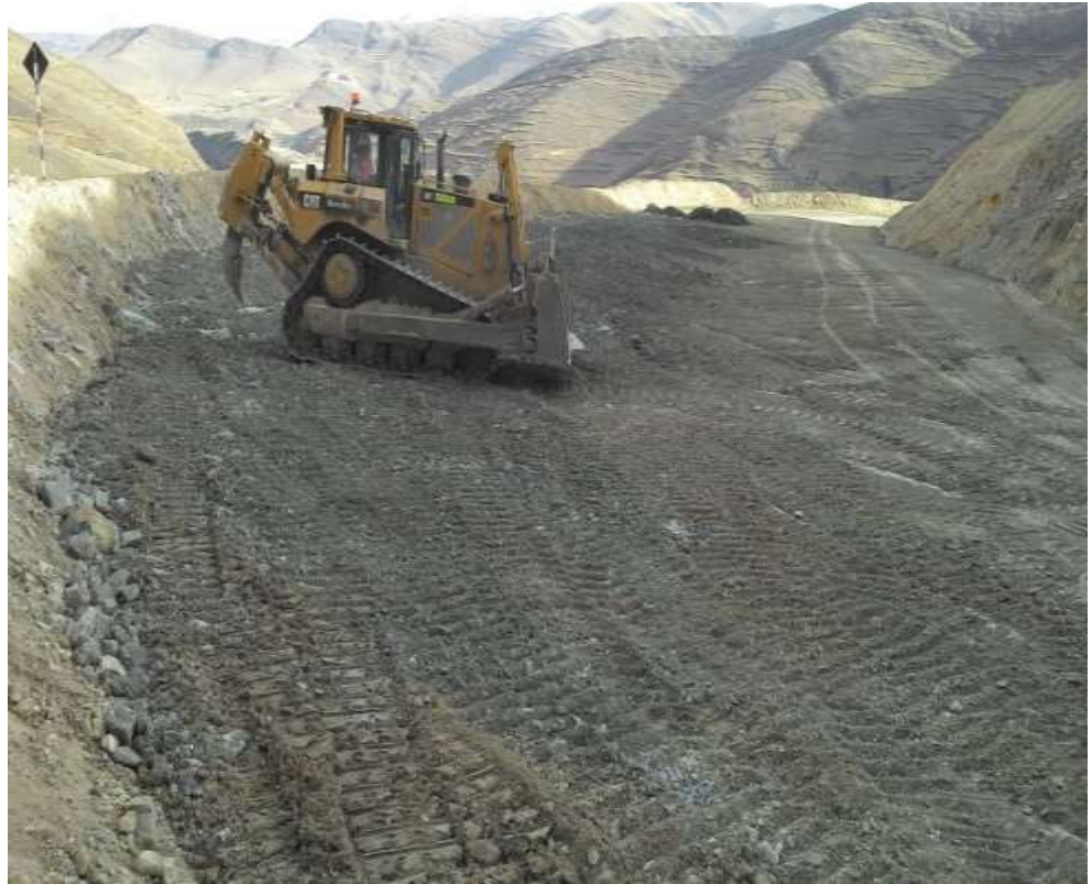
Figura 56 — Conformación de carpeta de rodadura, peralte y drenaje para evacuación de aguas fluviales
