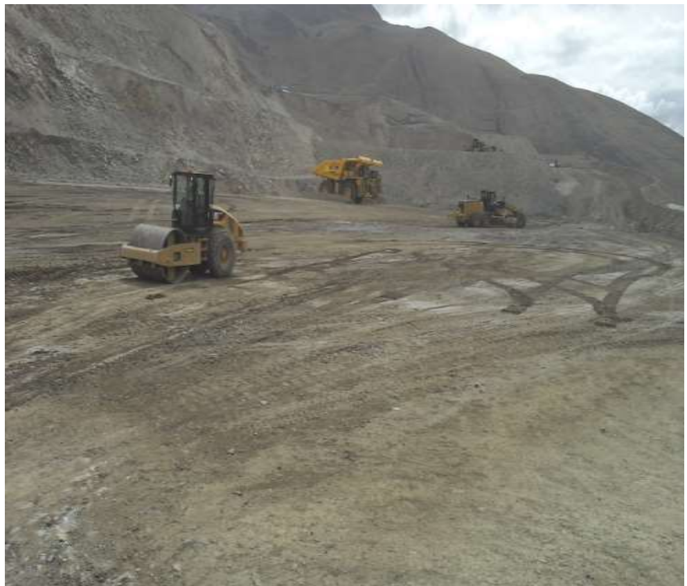
Figura 57 — Compactación de la carpeta de rodadura
