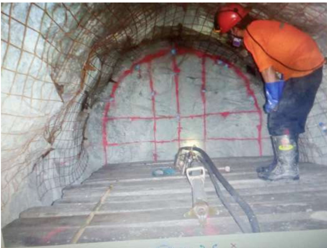
Figura 65 — Pintado de malla de perforación
