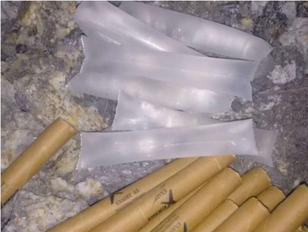
Figura 70 — Uso de cojines de agua como espaciador en taladros de corona
