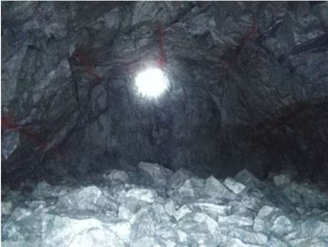
Figura 72 — Resultados de la voladura y control de la bóveda
