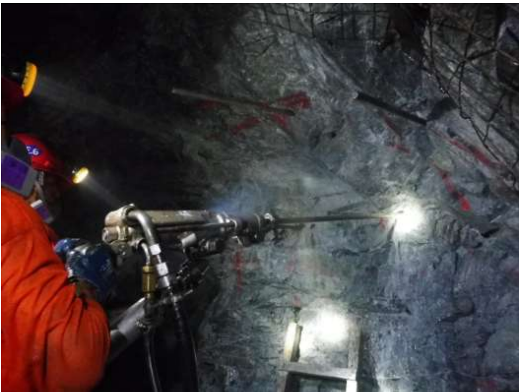
Figura 67 — Perforación del frente de avance
