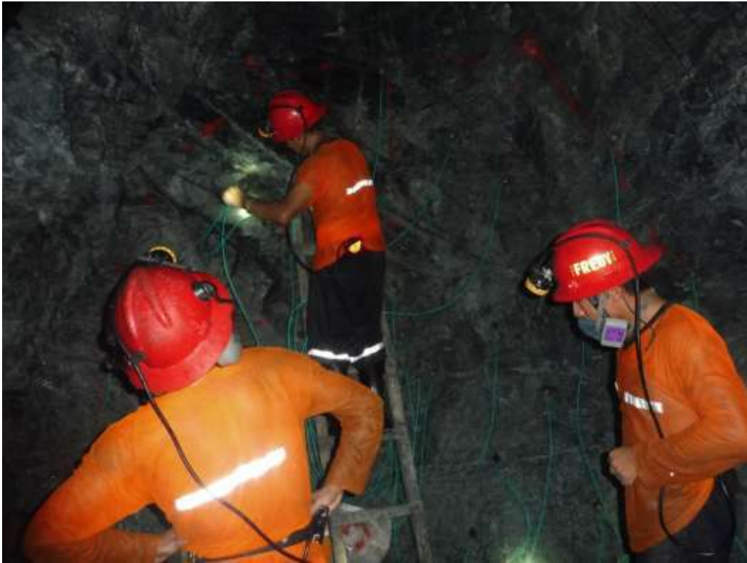
Figura 68 — Proceso de carguío de taladros
