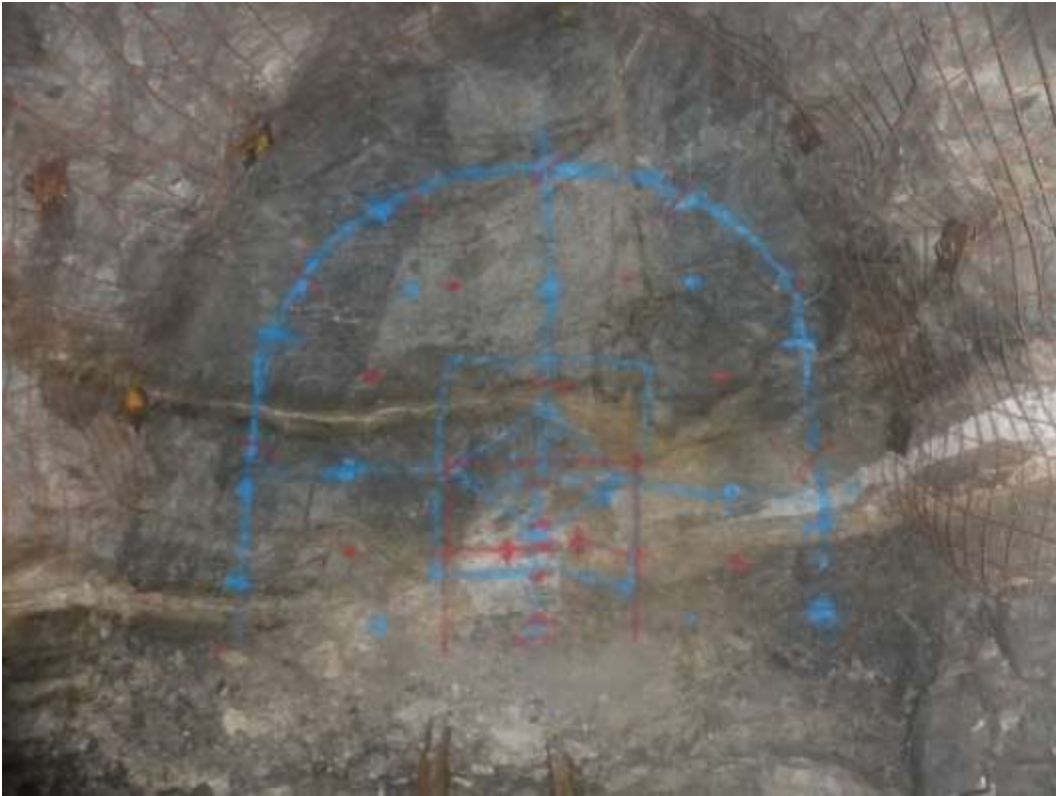
Figura 66 — Cambios en el diseño de malla de perforación
