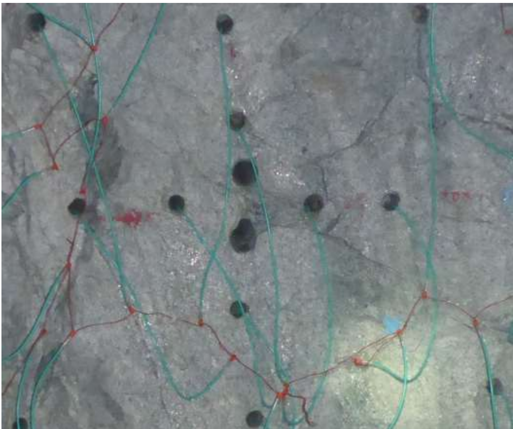
Figura 69 — Distribución geométrica de taladros luego de la perforación
