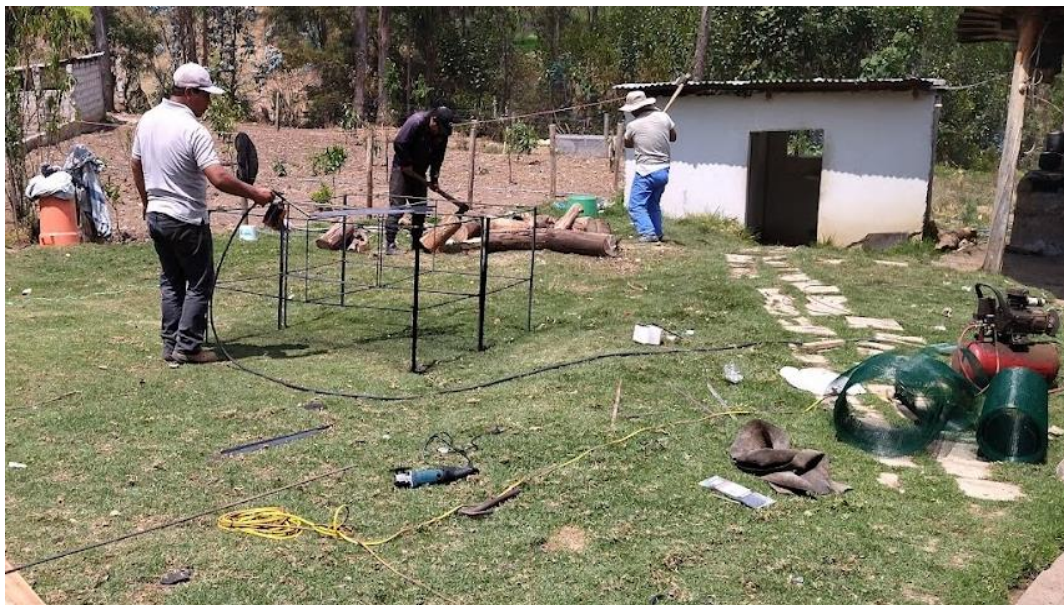
Figura 6. Construcción de jaulas
