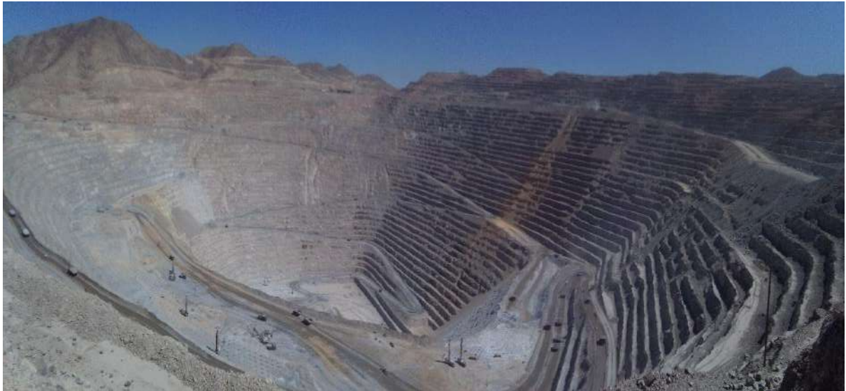
Figura 37 — Tajo de la mina Toquepala donde se muestra la fase 03, fase 04 y fase 05
