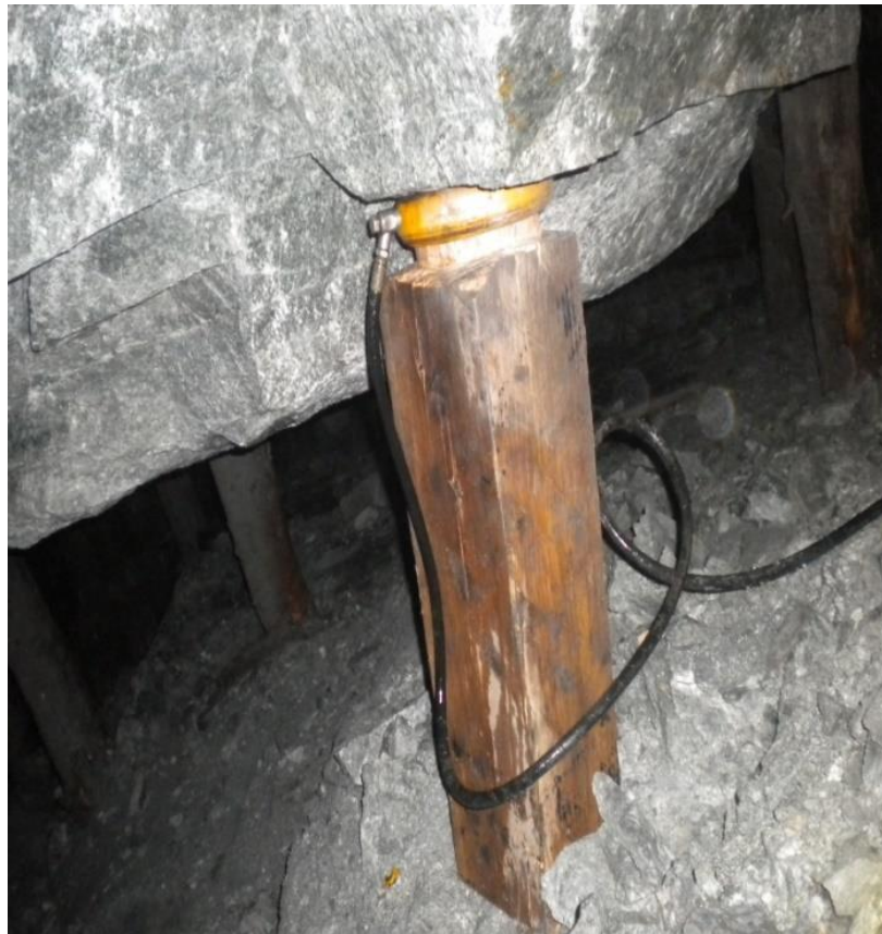
Figura 8 — Sostenimiento con “Jackpot” y puntal de madera
