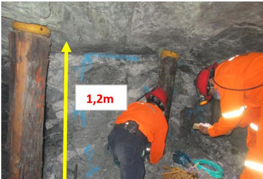
Figura 13 — Instalación de Jack Pot en pilar de 1.2 m de altura
