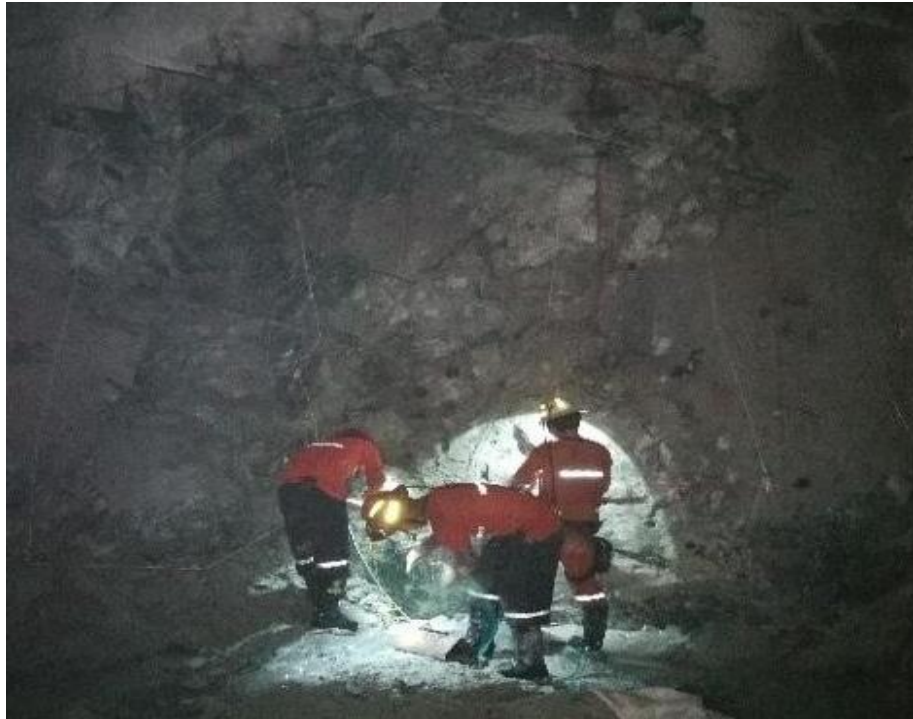
Figura 7 — Amarre de la malla de voladura en la profundización de la Rampa Patrick IV
