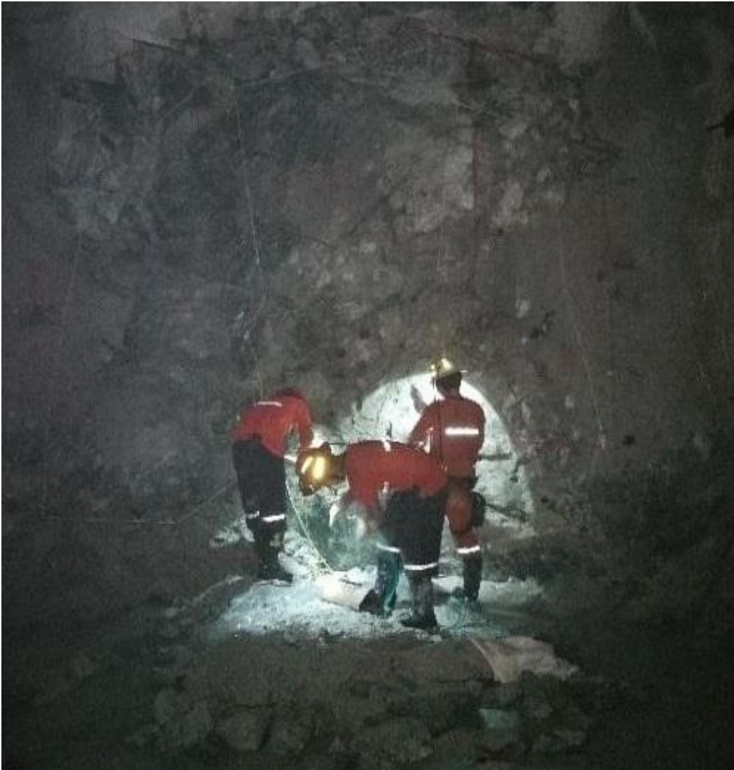
Figura 36 — Amarre para la voladura, en la profundización de la Rampa Patrick IV
