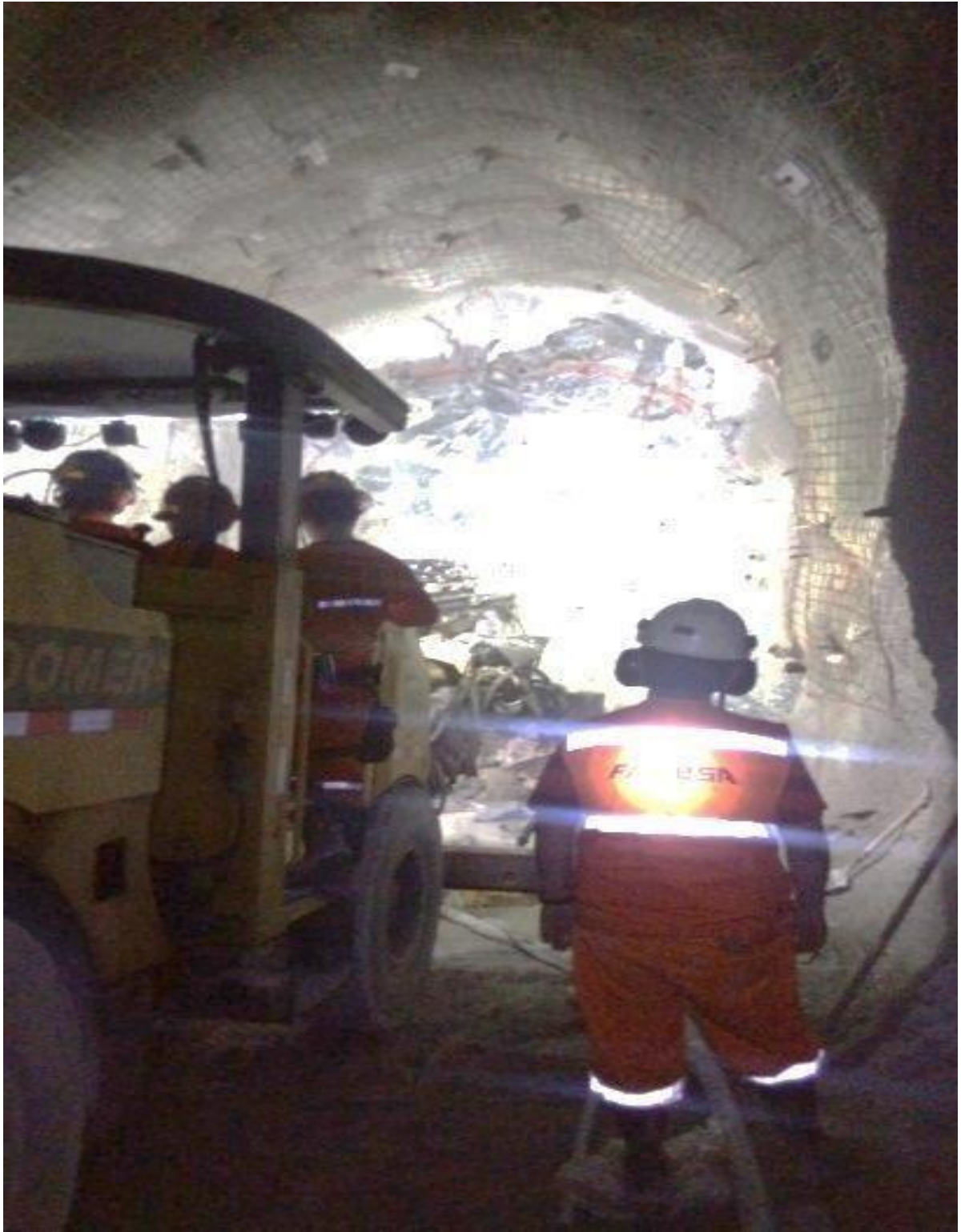
Figura 40 — Perforación con Jumbo de dos brazos en la profundización de la Rampa Patrick IV
