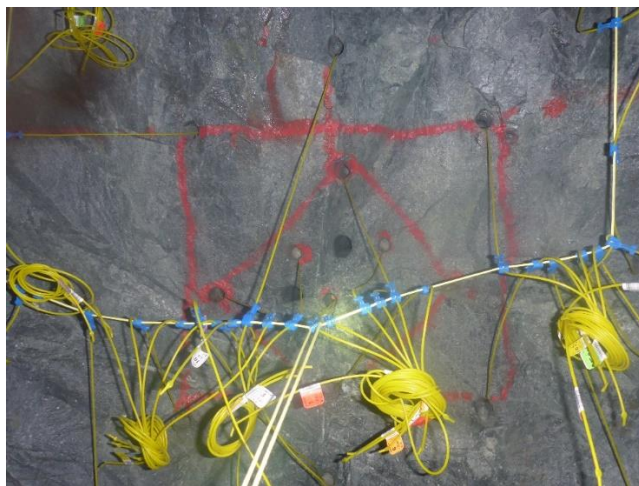
Figura 30 — Carguío y amarre- sistema fanel (XC 10654-NW, NV.2570)
