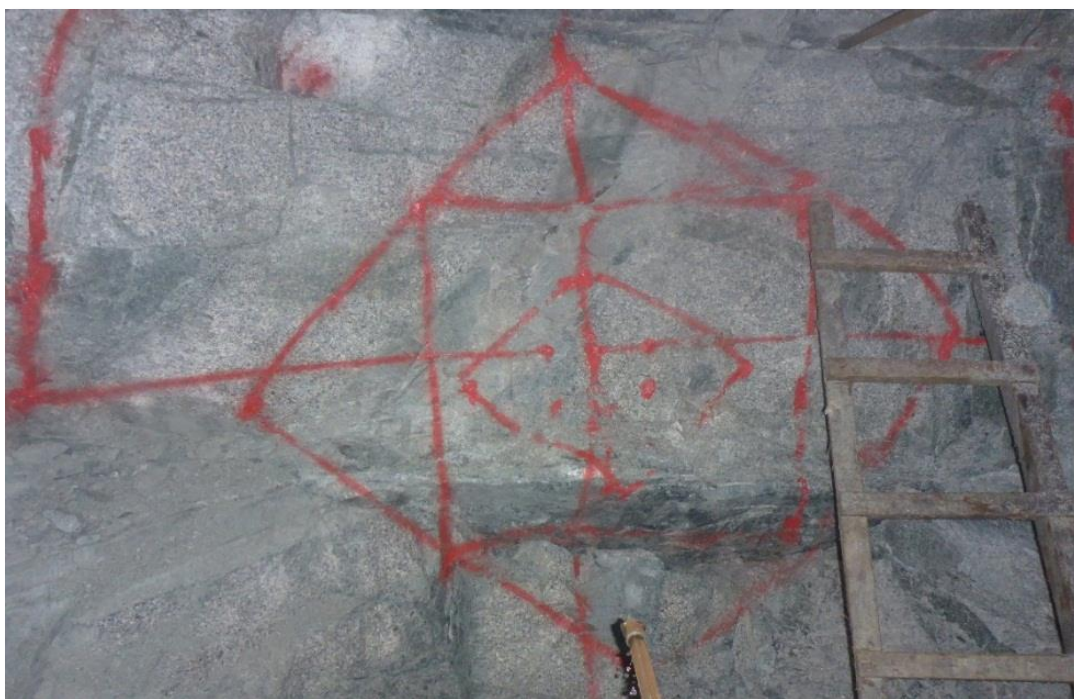
Figura 29 — Pintado de malla de perforación (XC 10654-NW, NV. 2570)
