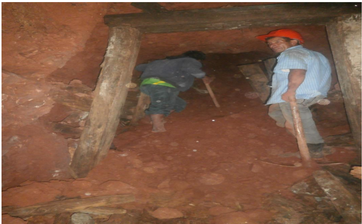
Figura 28 — Mantenimiento de cuadros de madera
