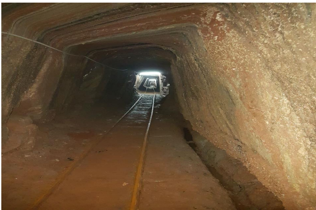
Figura 30 — Galería principal a estándar actual y acceso a las cámaras y pilares
