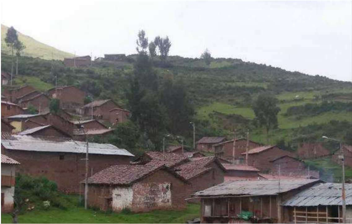
Figura 48 — Edificaciones del Centro poblado Tiaparo
