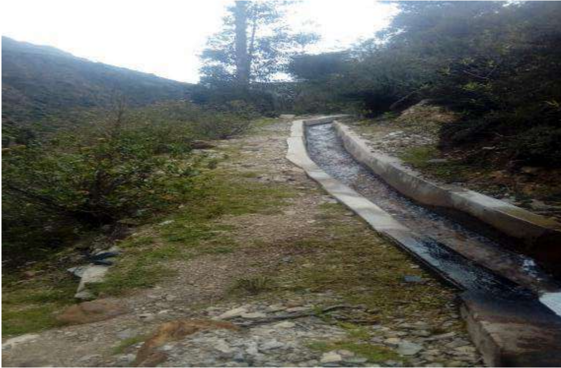
Figura 40 — Canal de riego proveniente de Jintilmachay, centro poblado de Tiaparo.
