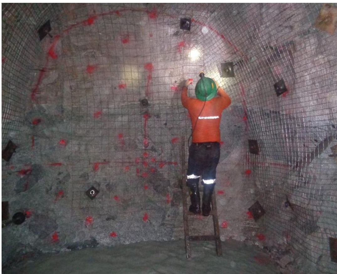
Figura 35 — Encargado de operación verificando el sostenimiento de la rampa 7040 y colocado de escudo en el NV 1467
