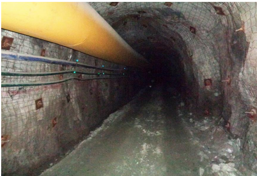
Figura 36 — Avance de la Rampa 7040 en el nivel 1467 según el estándar establecido después del relajamiento de rocas
