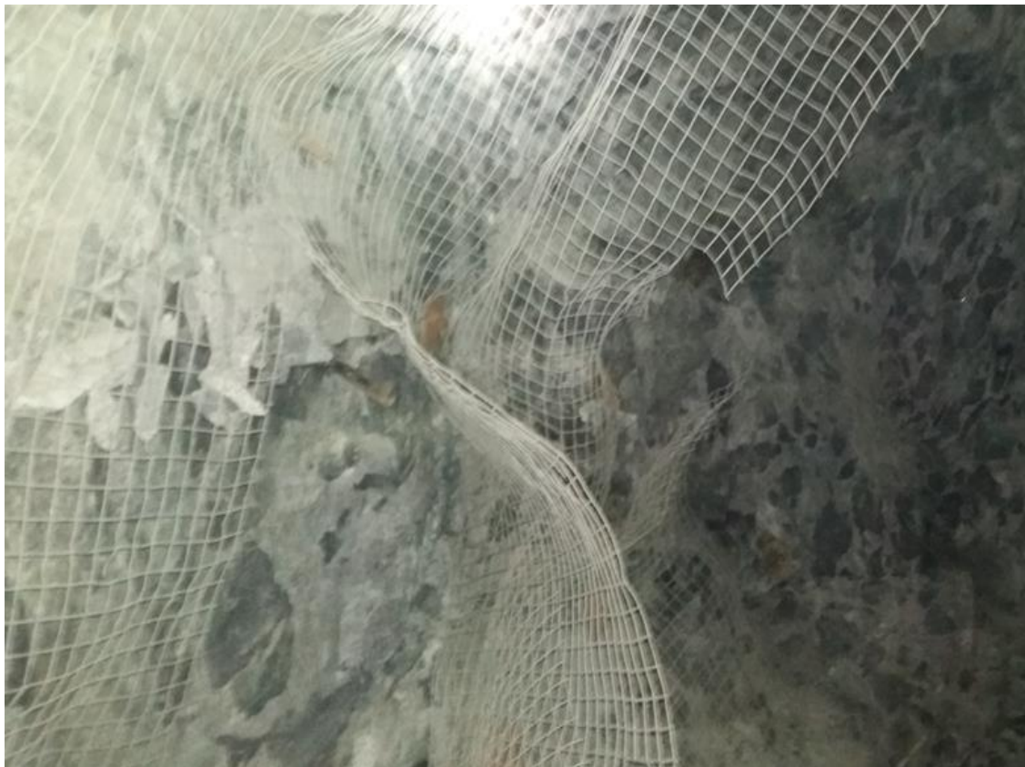
Figura 48 — después del evento de relajamiento de rocas por el hastial RP 7040
