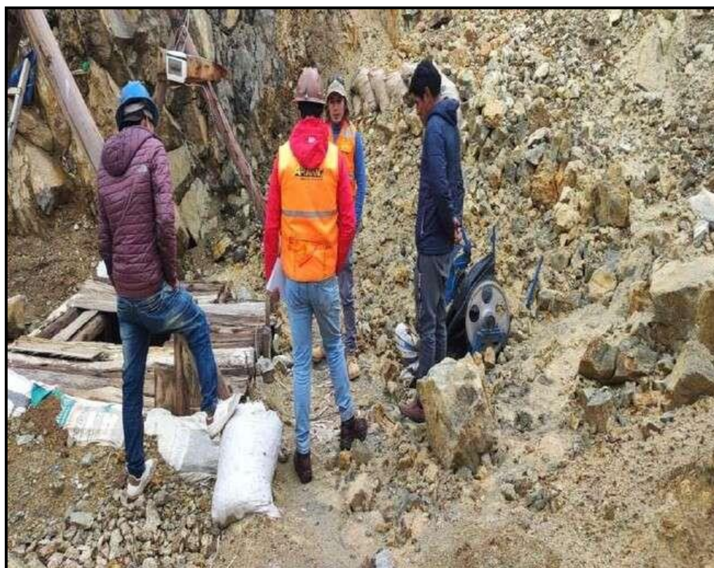
Figura 4 — Los trabajadores y el investigador identifican colapsamientos de material
