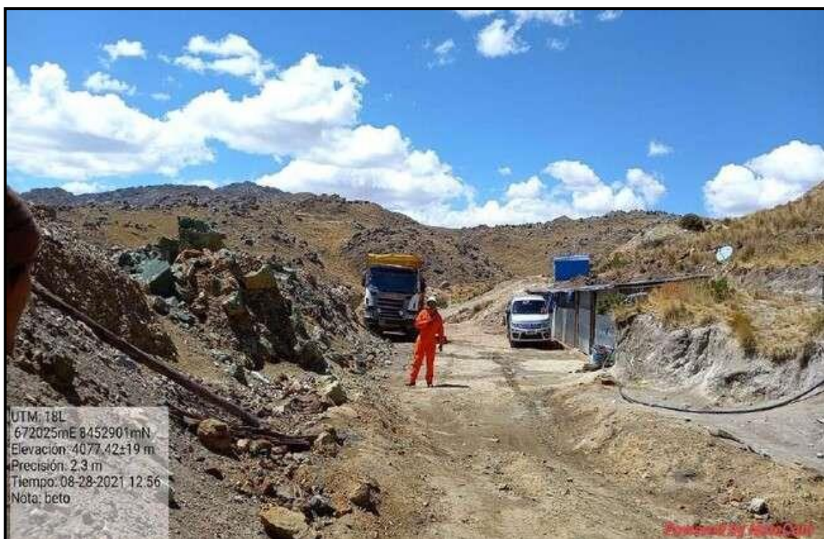
Figura 17 — El trabajador evidencia la implementación del sistema de gestión de seguridad
