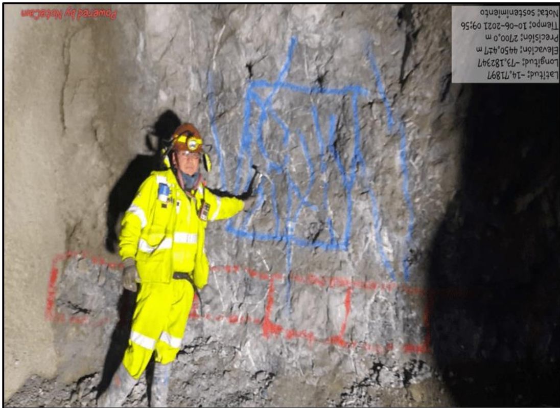
Figura 22 — Reconocimiento de roca para realizar el ensayo correspondiente en una labor subterránea
