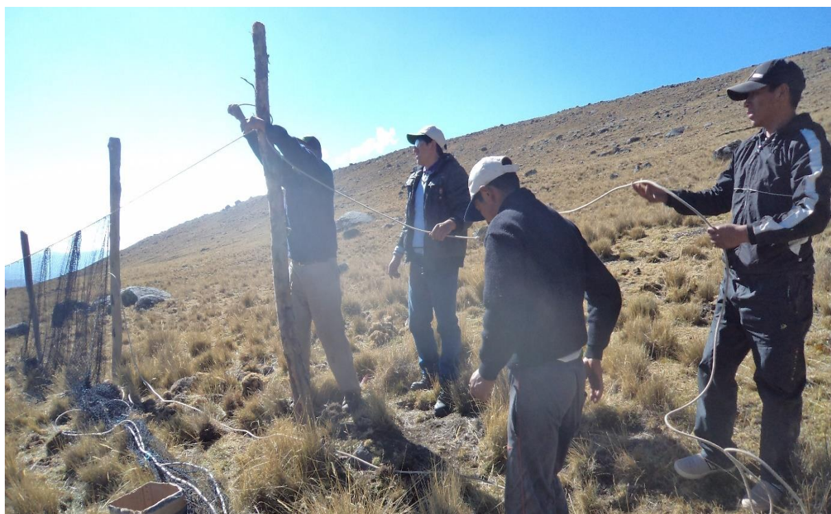
Figura 3. Construcción de la manga y corral de captura en la comunidad de Capaya
