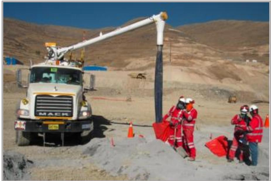
**Figura 28 — Calibración de mezclador en campo**
