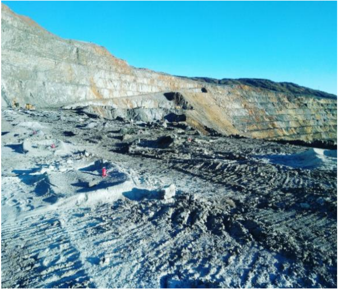
Figura 29 — Terreno preparado antes de la voladura
