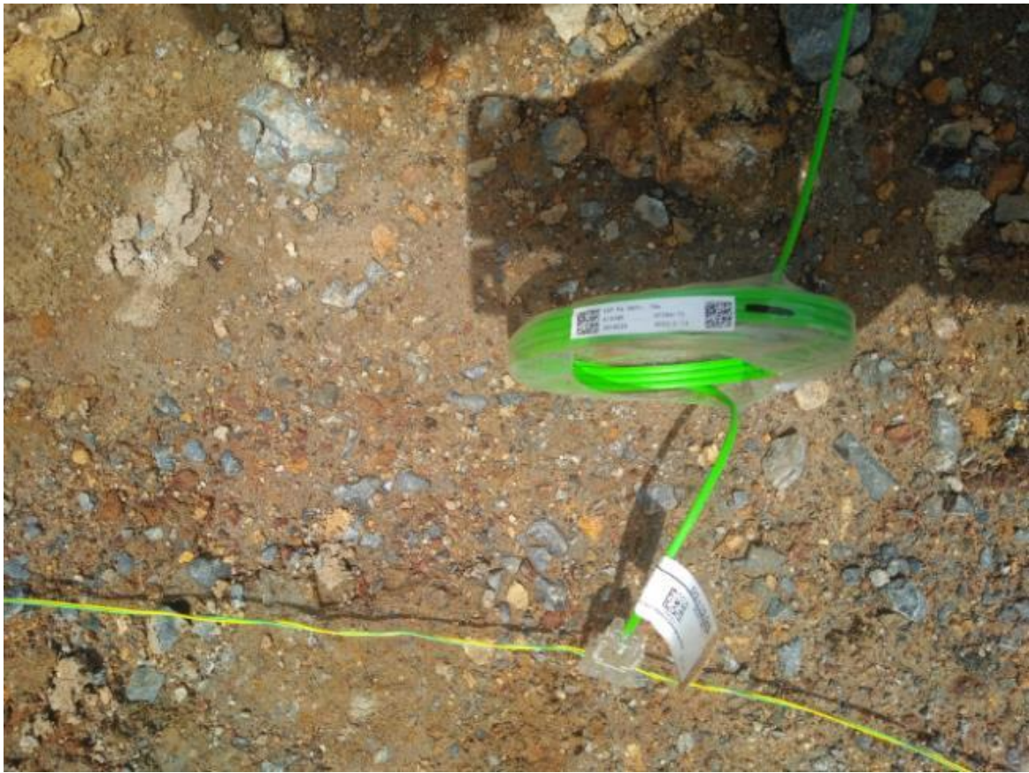
Figura 32 — Detonador siendo etiquetado y conectado
