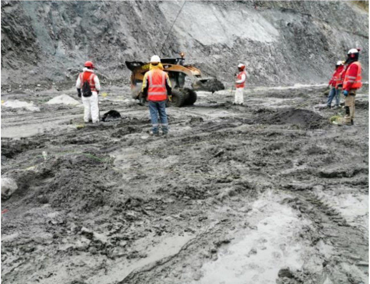
Figura 36 — Control de detonadores Digishot Plus en el tapado de taladros
