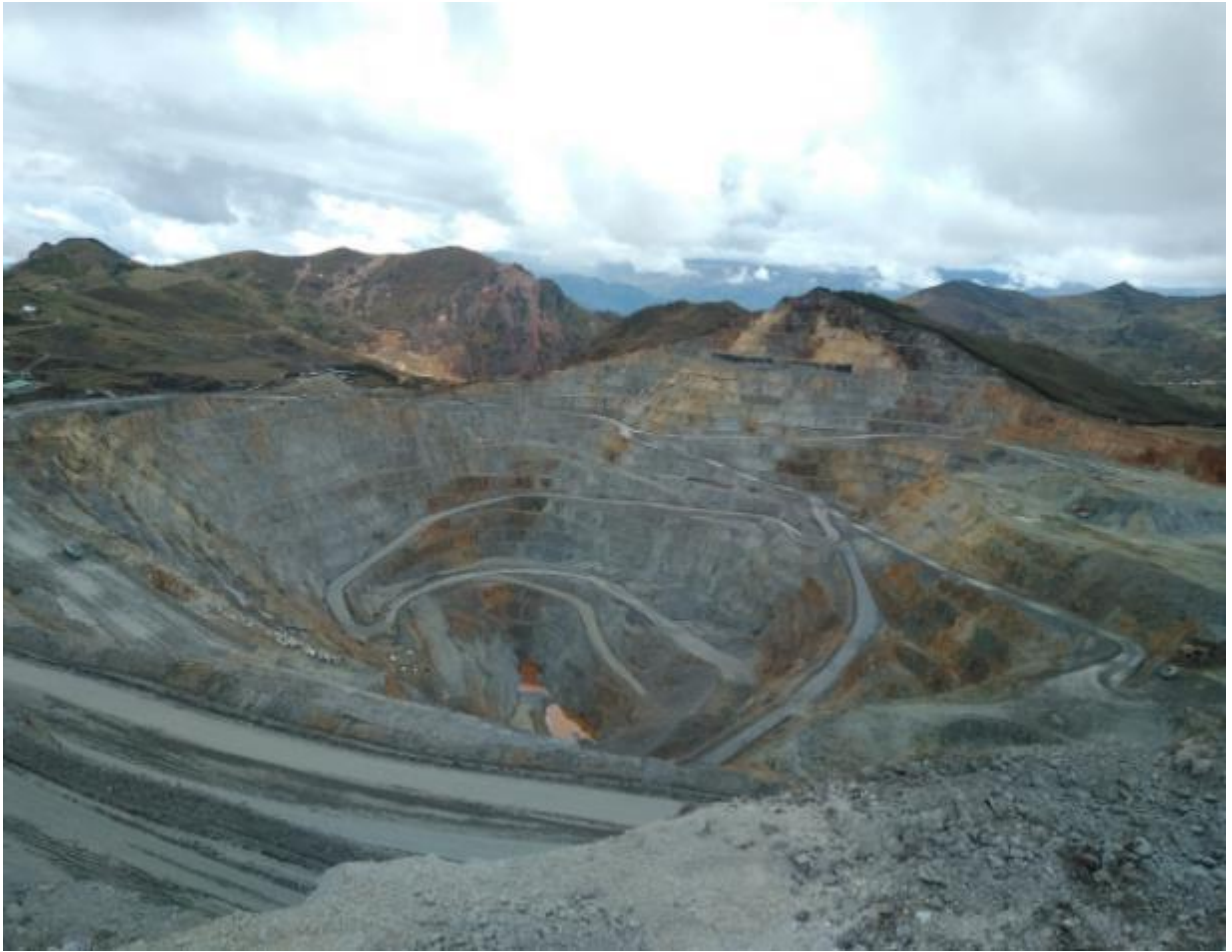
Figura 28 — Tajo despejado de la Unidad Minera Cerro Corona
