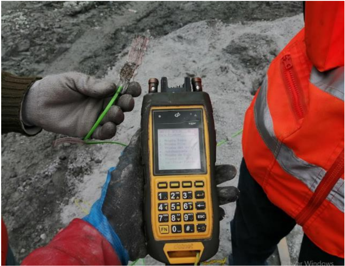
Figura 37 — Operadores verificando y etiquetando los detonadores con el Tagger
