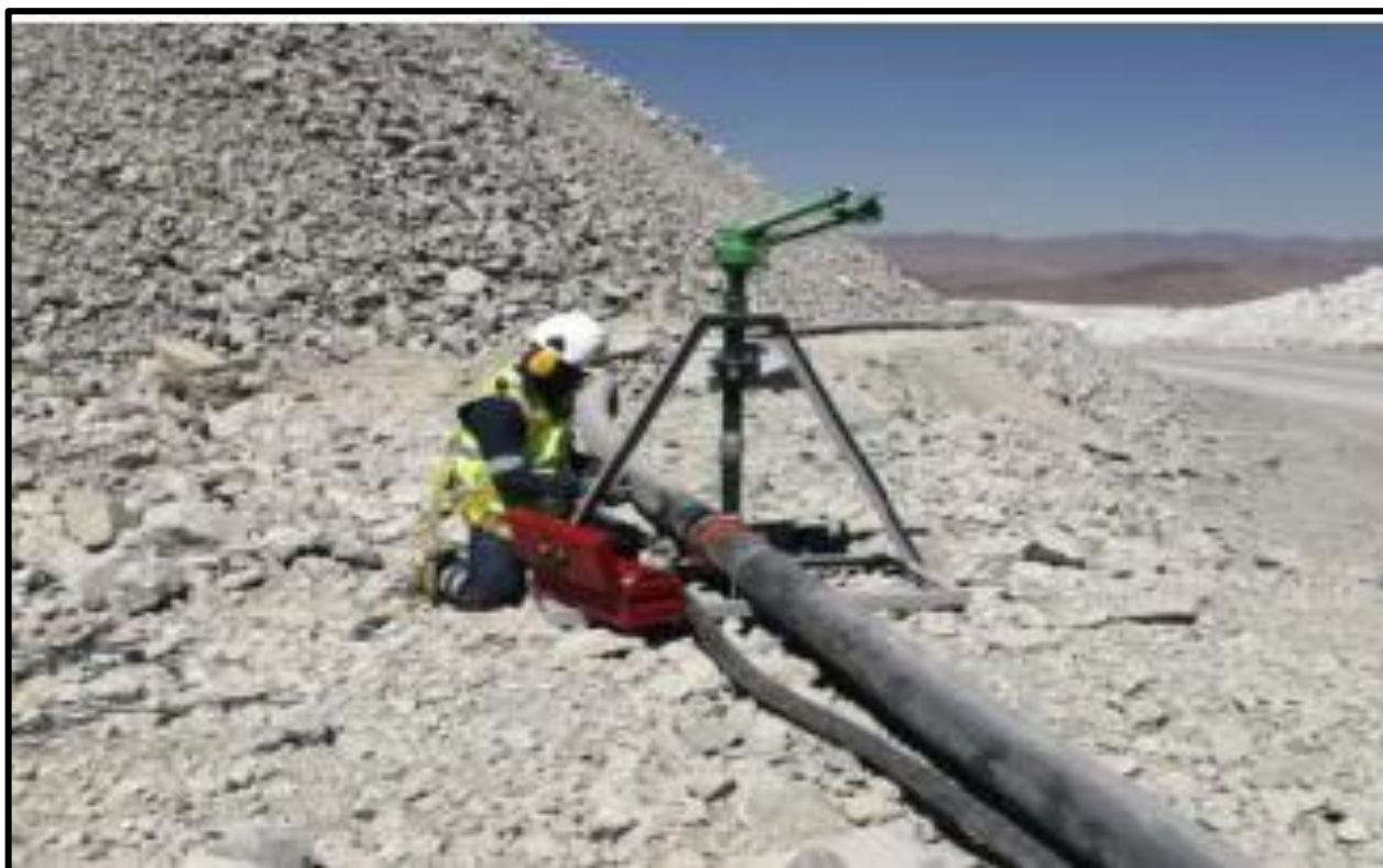
Figura 33— Instalación de aspersores sobre berma en el Tramo 09
