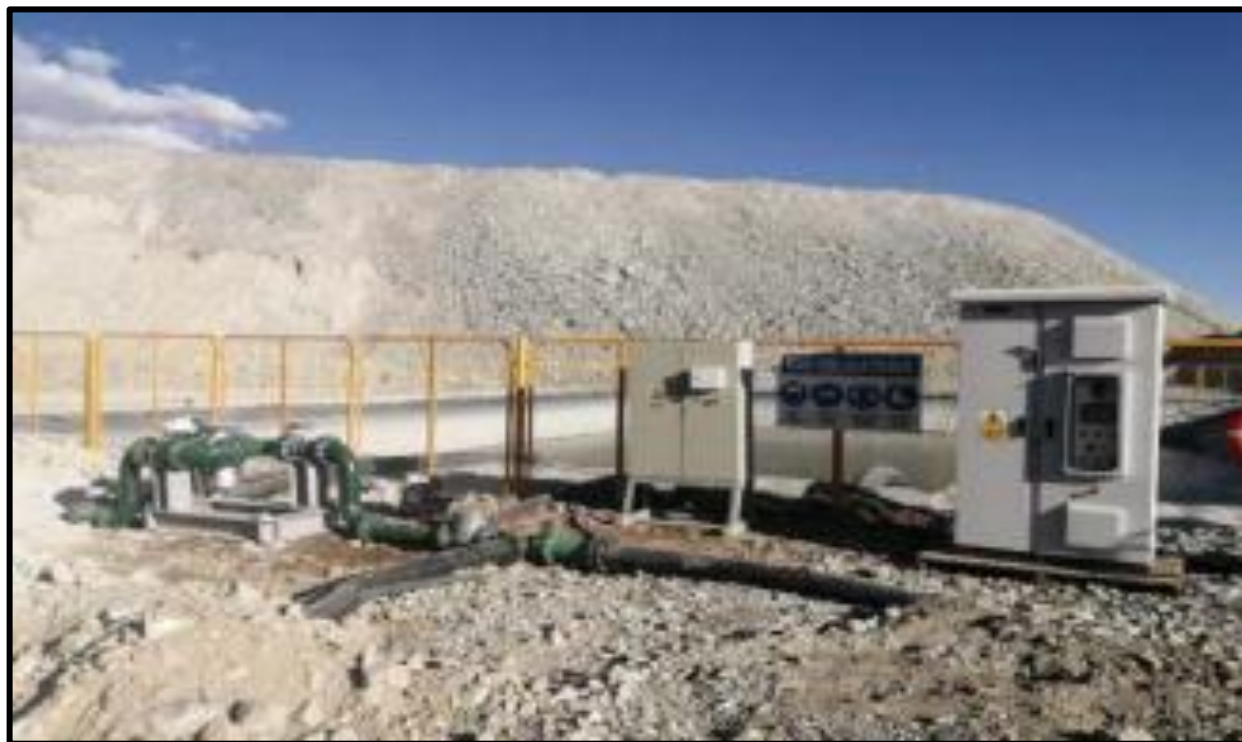
Figura 34— Instalación de sistema de control para abastecimiento de camiones cisterna
