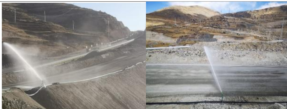
Figura 20— Instalación de aspersores Tajo Ferrobamba
