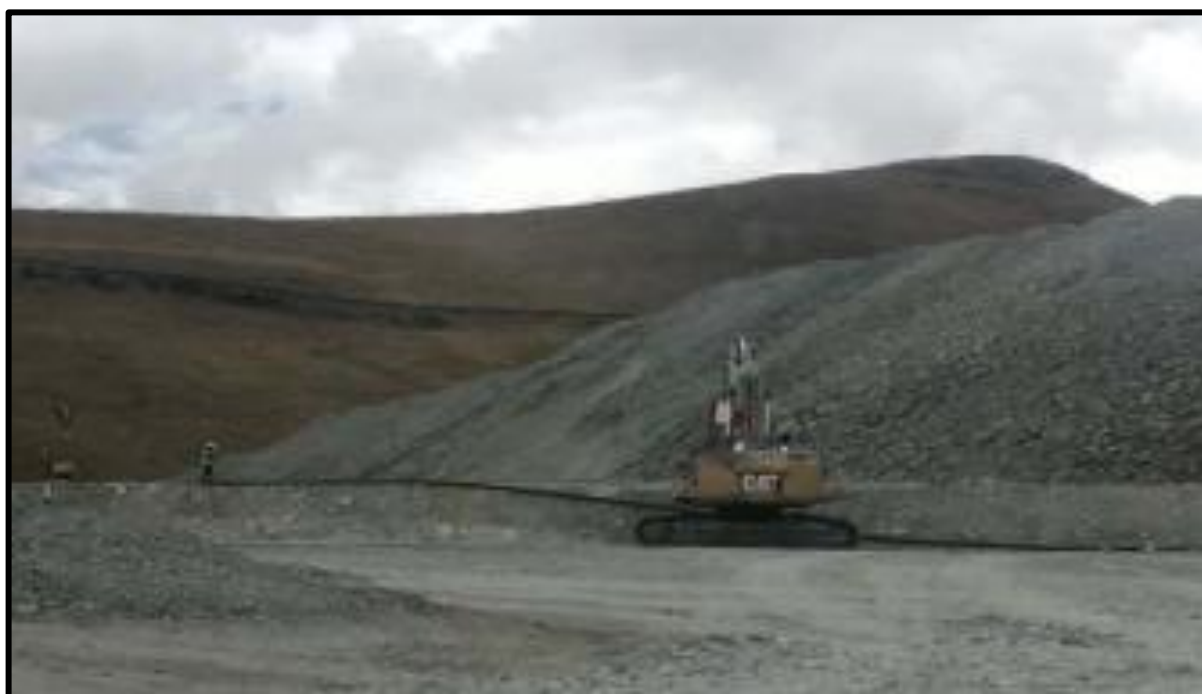
Figura 32— Cableado eléctrico sobre berma para cañones aspersores en el Tramo 09
