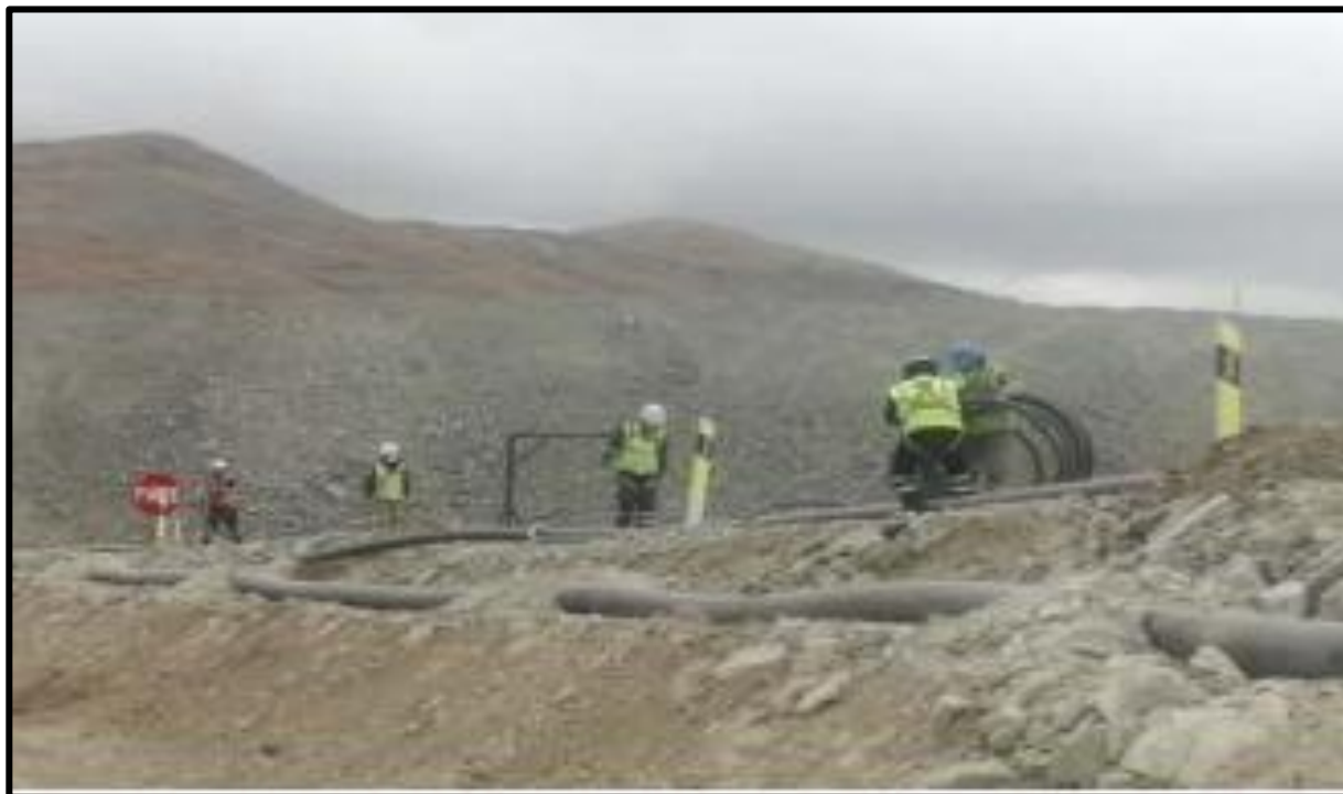
Figura 31— Tendido de tubería HDPE 6” en el Tramo 09
