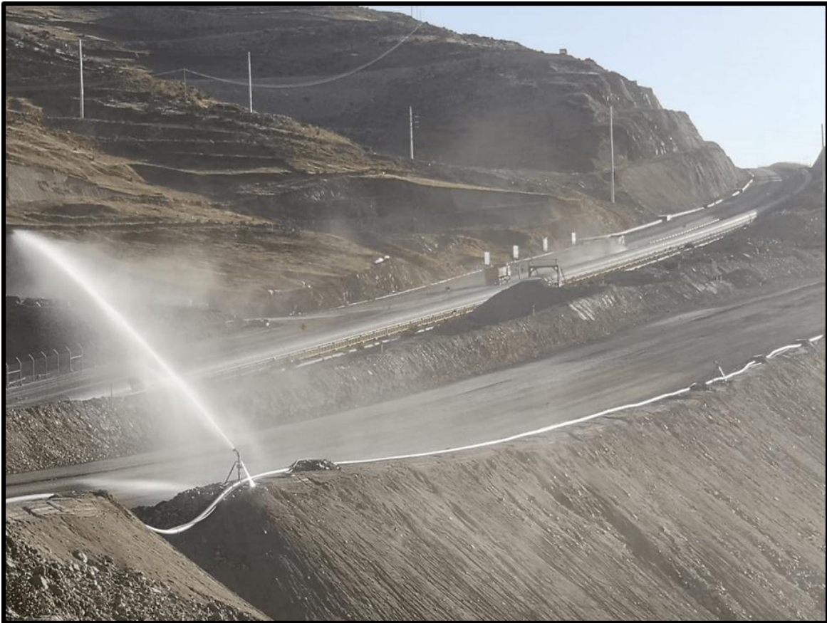
Figura 5— Funcionamiento de los cañones supresores de polvo
