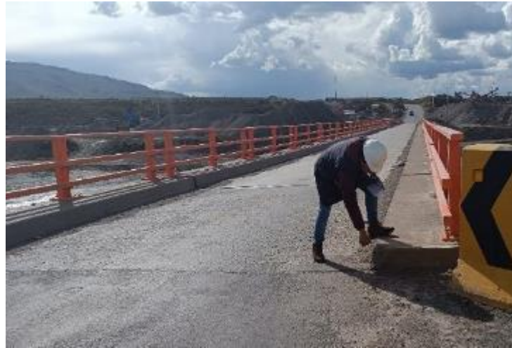
Figura 50 — Medición de vista transversal del tablero del puente Coporaque
