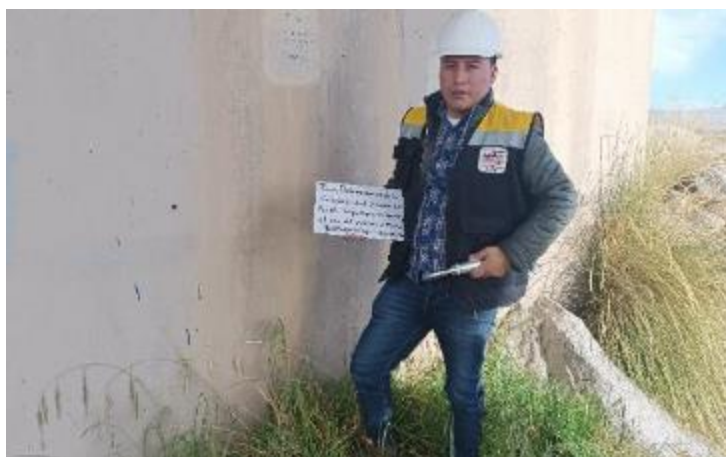
Figura 54 — Ensayo de esclerómetro en puente
