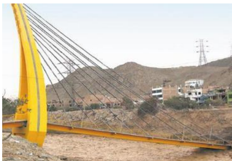
Figura 8 — Colapso de puente Solidaridad de Lima
