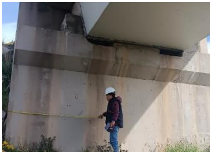
Figura 52 — Medición de la dimensión de estribos
