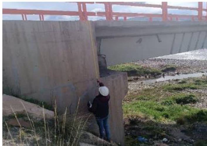
Figura 51 — Medición de las dimensiones de viga cajón
