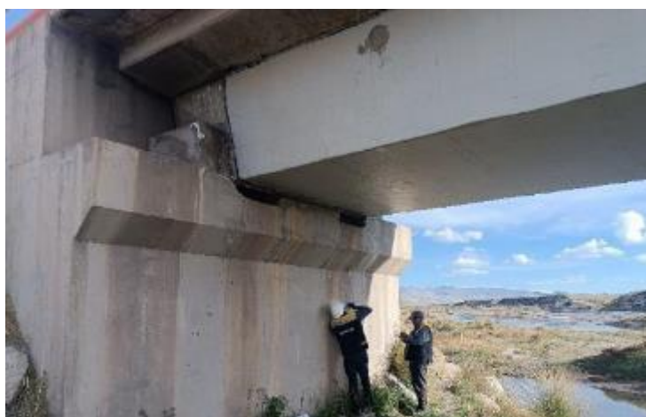
Figura 56 — Ensayo de esclerometría en el punto 1 estribo izquierdo
