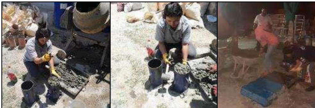
**Figura 8 — Mezclado y colocación del concreto poroso en los moldes**
