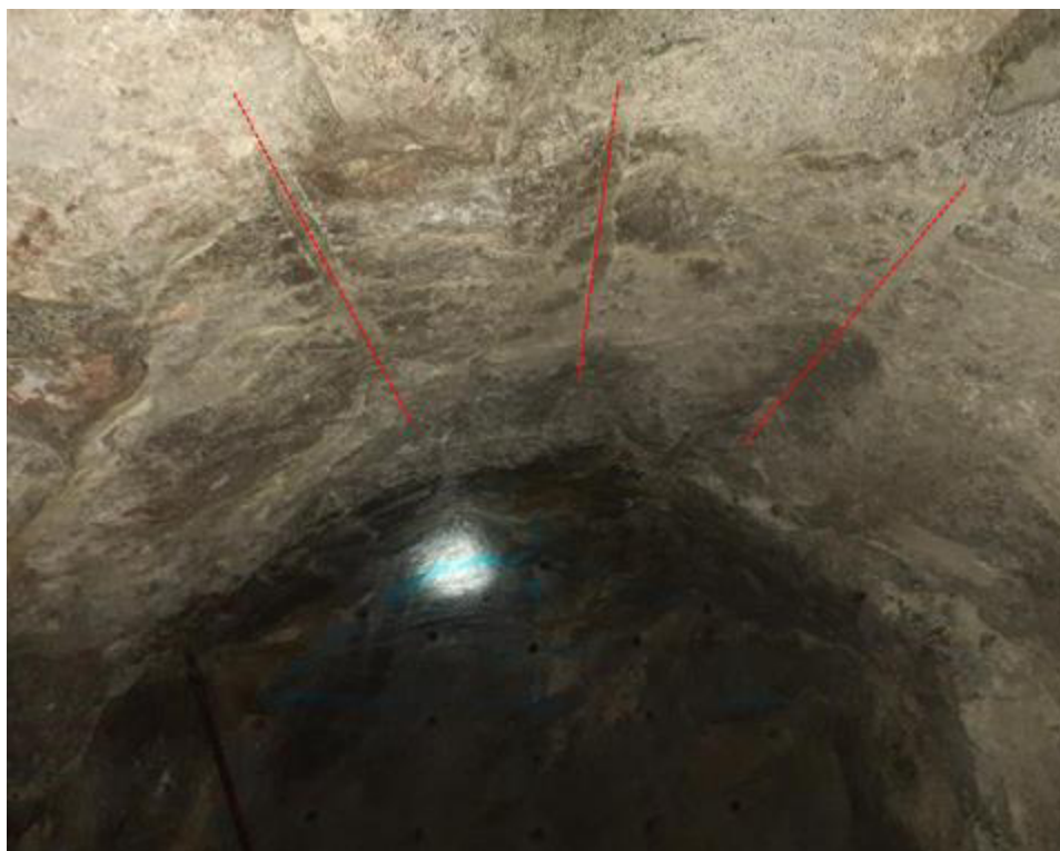
Figura 37 — Frente perforado en galería 555
