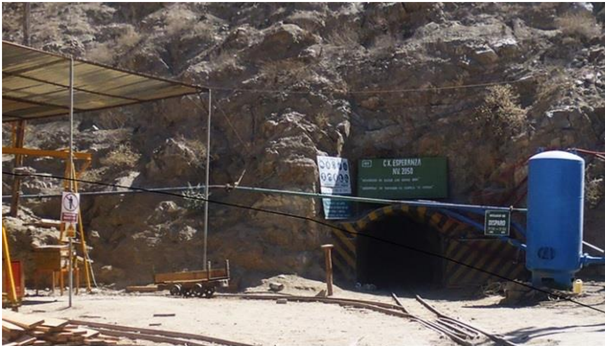
Figura 35 — Bocamina esperanza (unidad minera yanaquihua)
