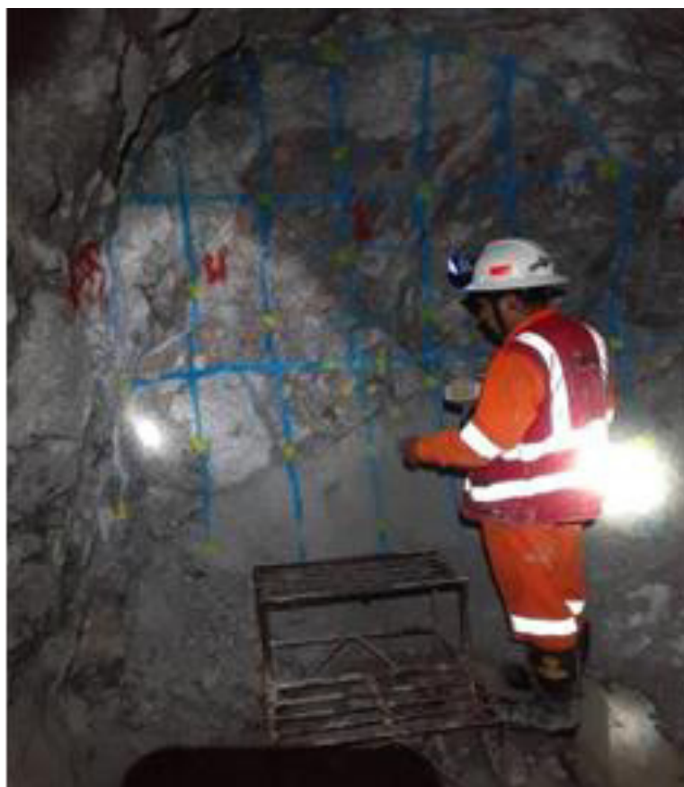
Figura 36 — Pintado de malla de perforación
