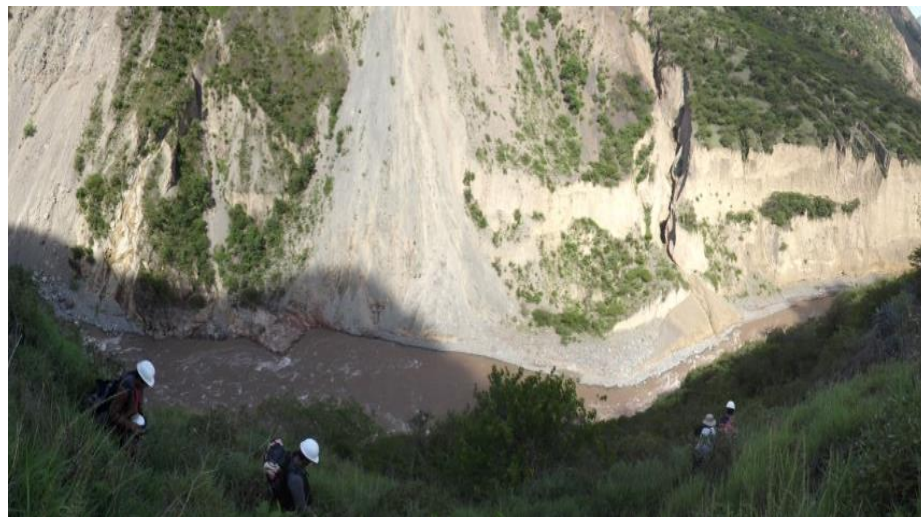
Figura 19 — Derrumbes a lo largo del río Apurímac
