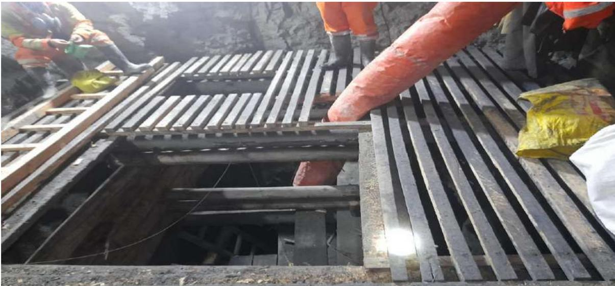
**Figura 35** — Manga de ventilación para la profundización del Pique 8261
