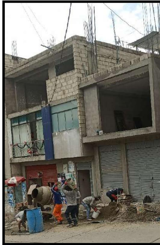
**Figura 67 — Vivienda 07 para el Muestreo de concreto tradicional para columnas**
