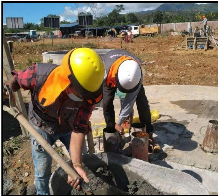
Figura 72 — Muestreo de mezcla de concreto tradicional en estado fresco
