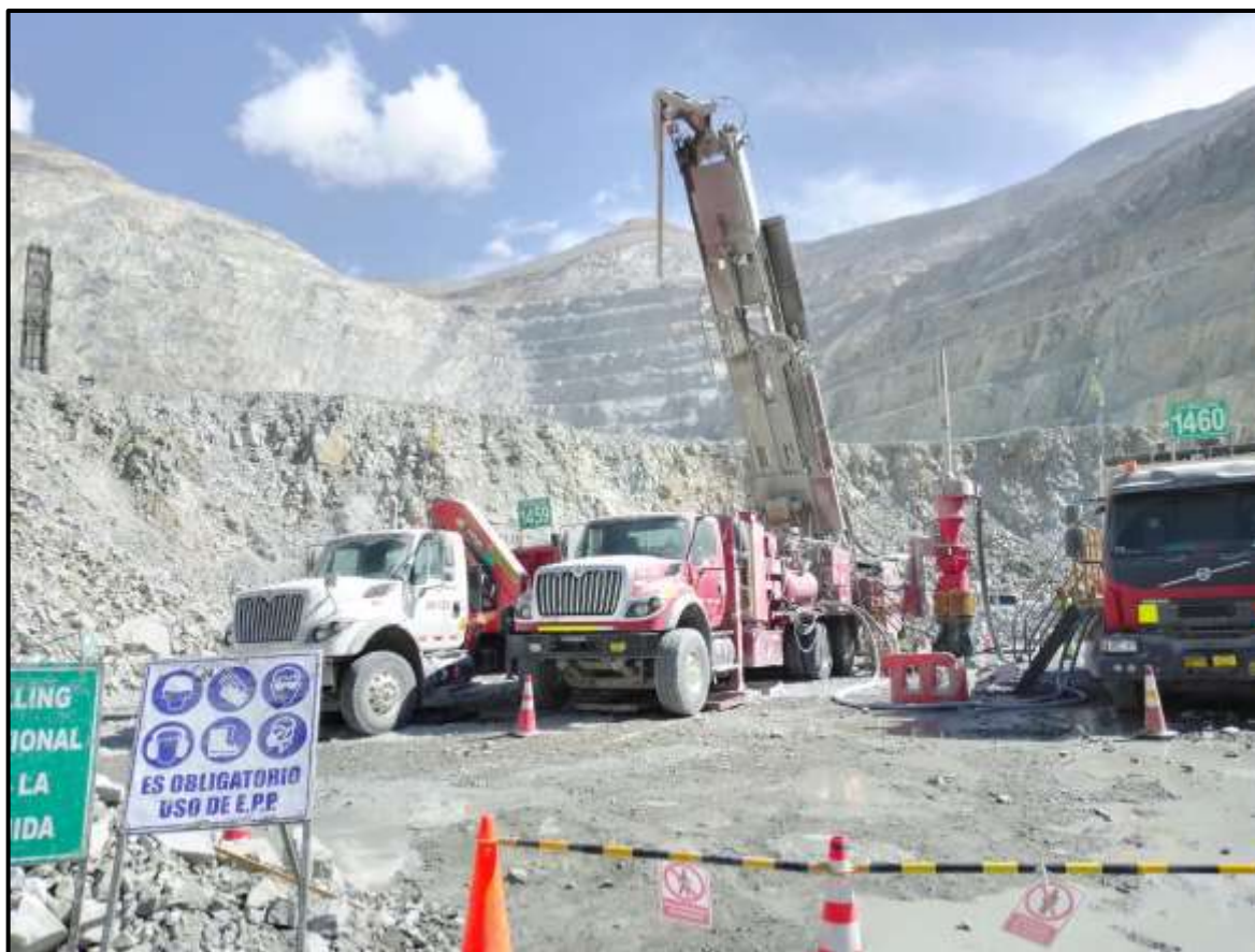
Figura 11 — Equipo de perforacion Schramm TH685WS Fase 3 tajo ferrobamba
