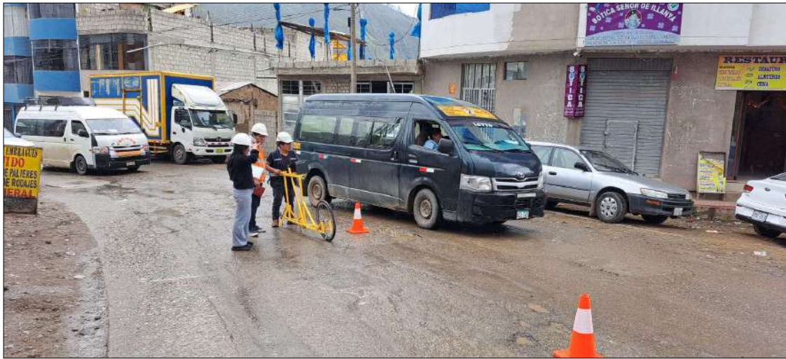
Figura 22 – Vista de carril derecho – tramo 1 en la Avenida las Malvinas.
