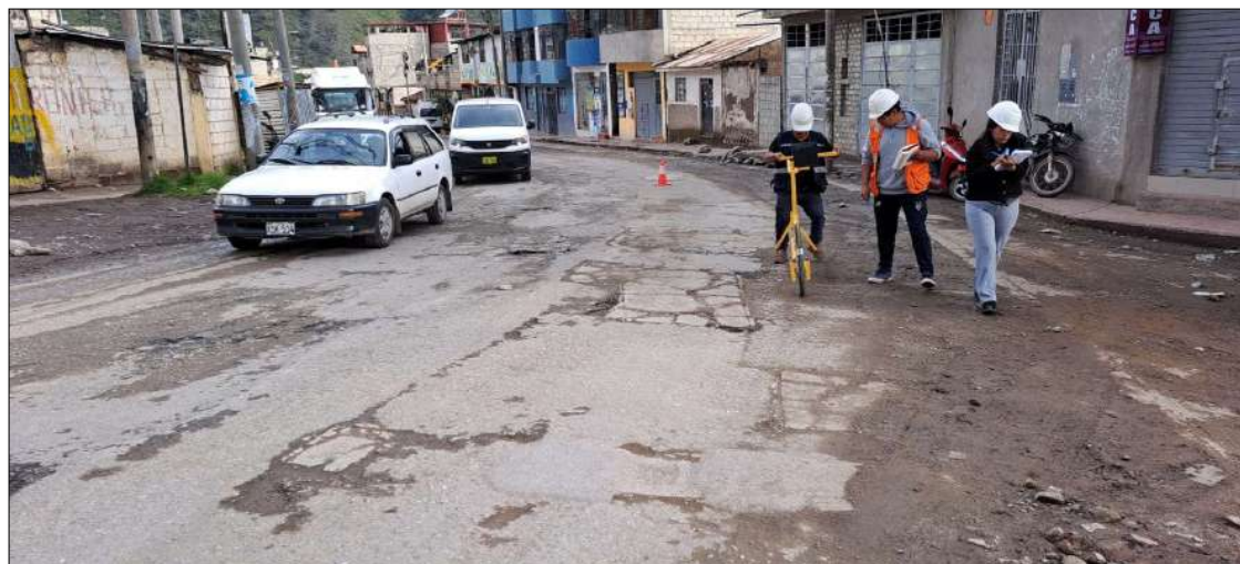
Figura 15 – Vista de carril izquierdo – tramo 1 en la Avenida las Malvinas.
