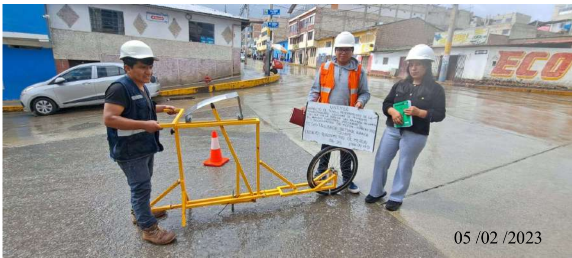
Fotografía 4 – Medición con el Rugosímetro de Merlín de las desviaciones o depresiones en el tramo 2 carril derecho en la progresiva 0+070 a 0+470.
