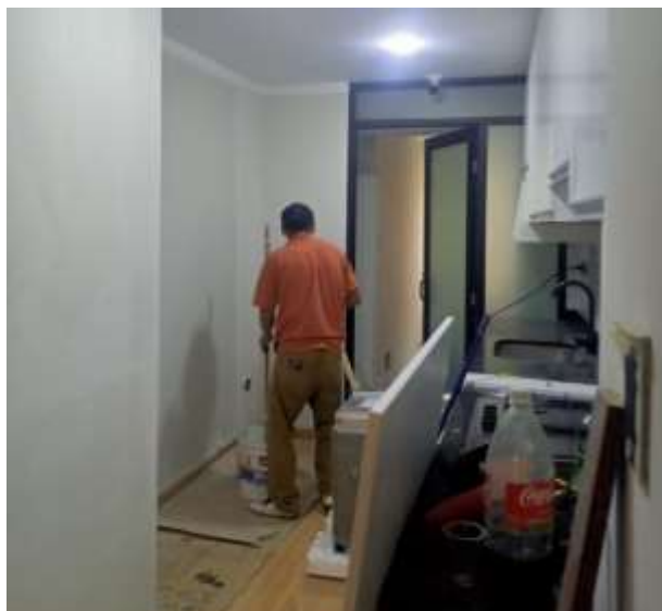
Figura 80 — Instalación de mamparas
