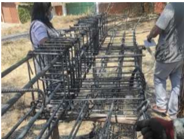
Figura 50 — Acero para placas y columnas
