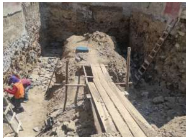
Figura 45 — Zanja para zapatas
