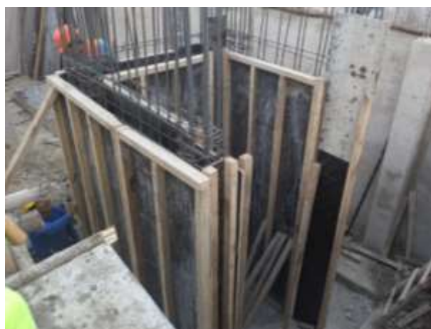
Figura 58 — Encofrado de placas de concreto
