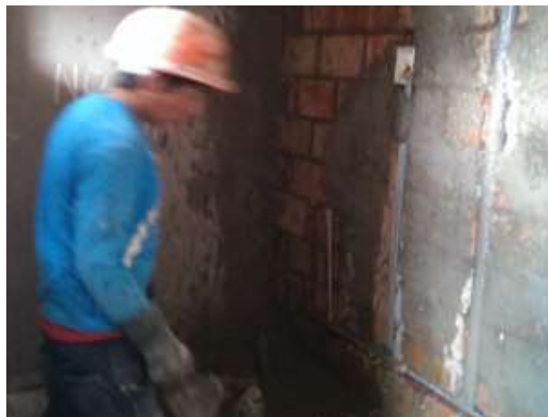
Figura 69 — Tubería de instalación eléctrica
