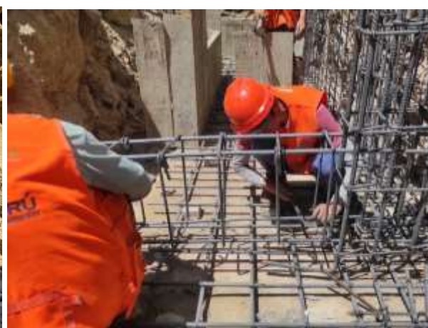
Figura 53 — Acero de vigas de conexión
