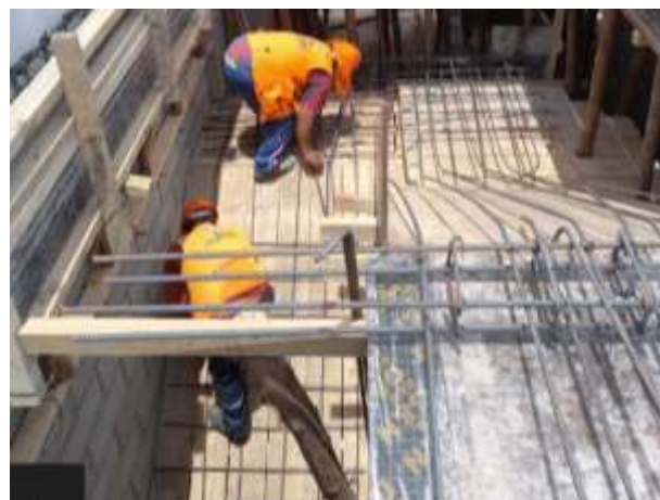
Figura 61 — Encofrado de escalera
