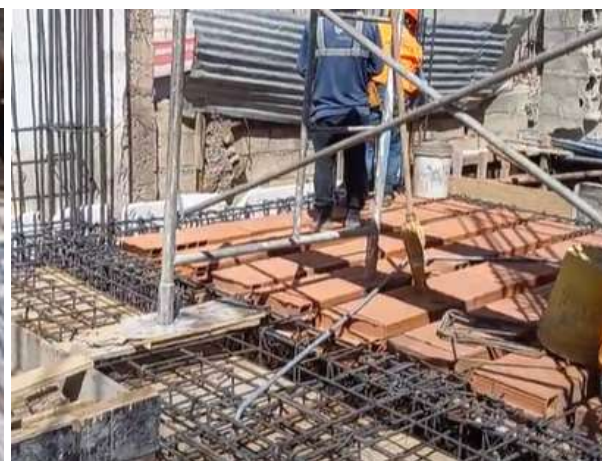
Figura 62 — ladrillo y acero para losa aligerada
