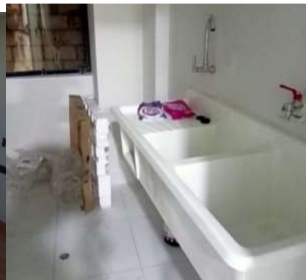
Figura 85 — Instalación de lavatorio
