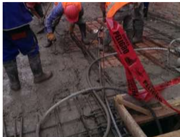
Figura 64 — Vaciado se concretó en losa aligerada
