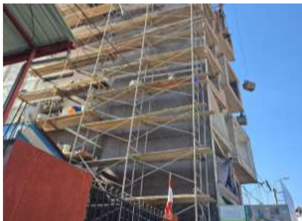
Figura 77 — Tarrajeo en exteriores
