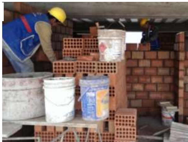
Figura 68 — Colocación de tabiquería
