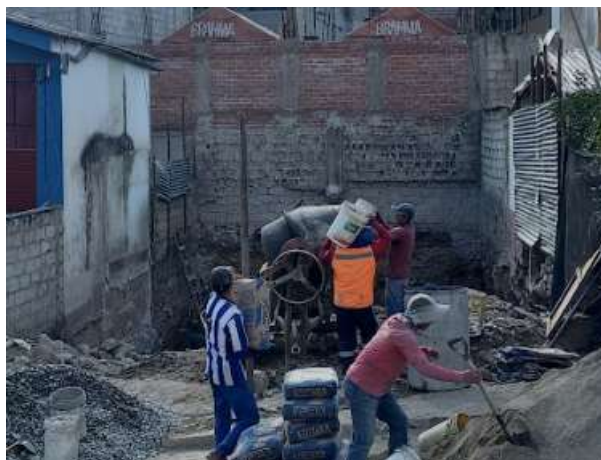
Figura 48 — Vaciado de solado
