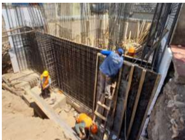
Figura 57 — Encofrado para muro de concreto
