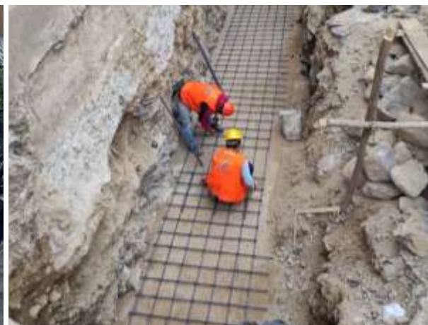
Figura 49 — Acero para zapatas
