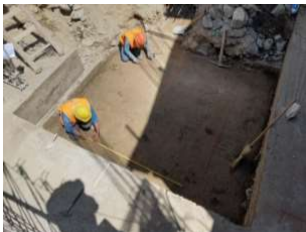
Figura 55 — Base de caja de ascensor
