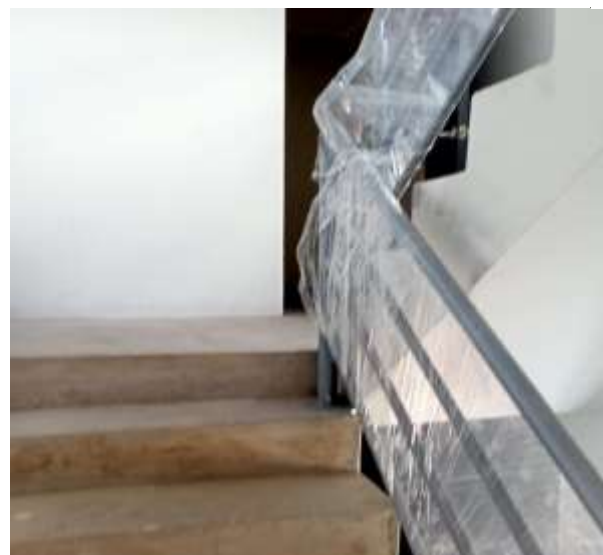
Figura 86 — Instalación de pasamanos
