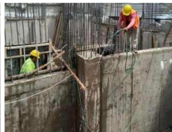
Figura 59 — Curado de concreto
