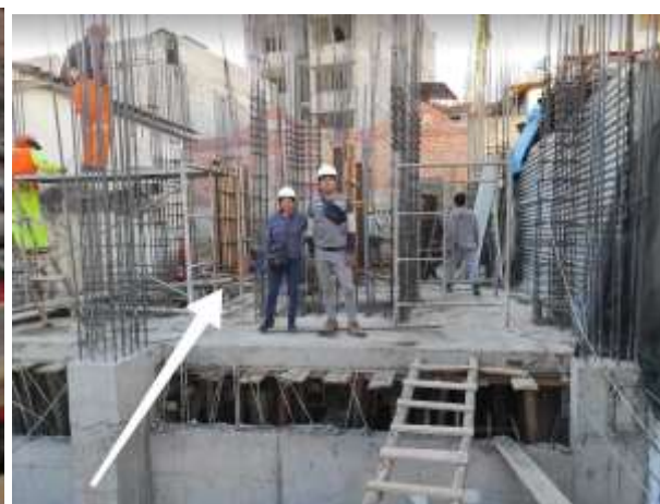
Figura 65 — Semisótano terminado a nivel estructural
