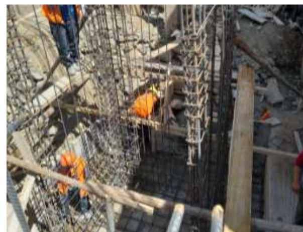
Figura 54 — Encofrado para caja de ascensor
