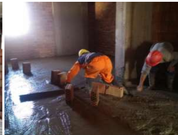
Figura 67 — Vaciado de contrapiso
