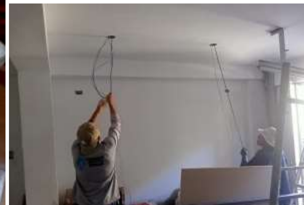
Figura 82 — Instalación de artefactos eléctricos
