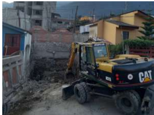
Figura 46 — Excavación para semisótano
