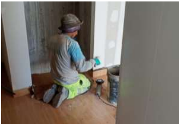
Figura 74 — Piso en interiores
