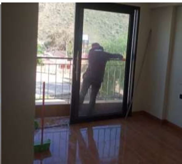
Figura 84 — Instalación de ventanas
