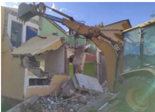
Figura 47 — Demolición de vivienda antigua
