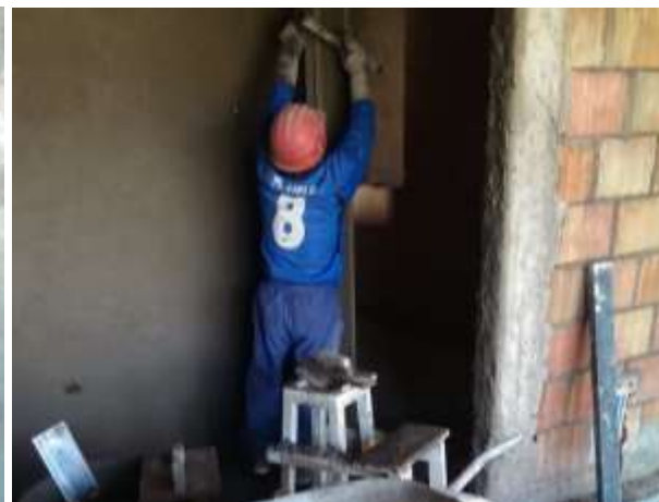
Figura 70 — Tarrajeo de tabiquería
