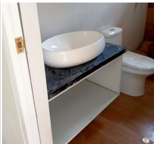
Figura 81 — Instalación de lavamanos
