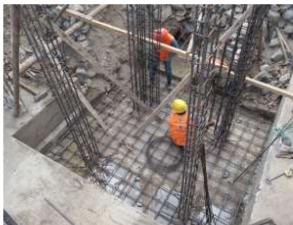
Figura 56 — Acero para caja de ascensor
