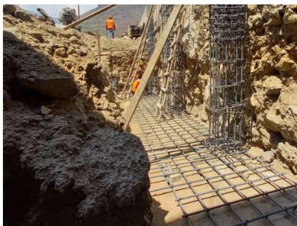
Figura 51 — Acero de zapatas y columnas
