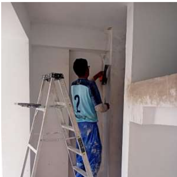
Figura 72 — Masillado en interiores
