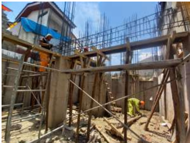
Figura 60 — Encofrado de vigas
