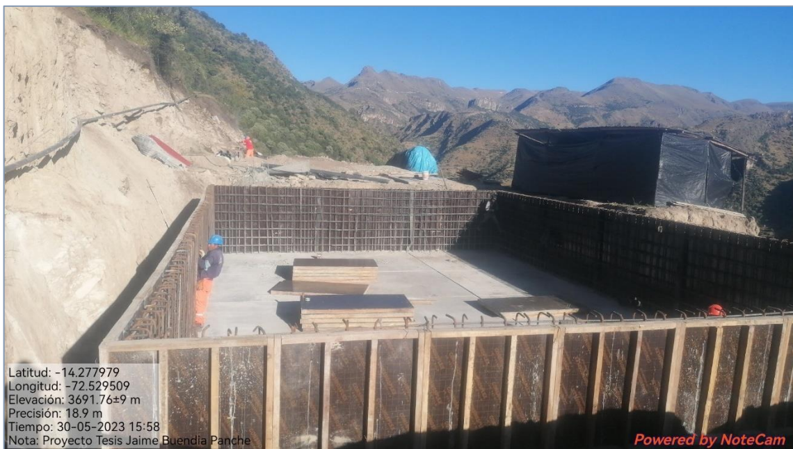
Figura 133 — Trabajos de encofrado reservorio Crusmocco
