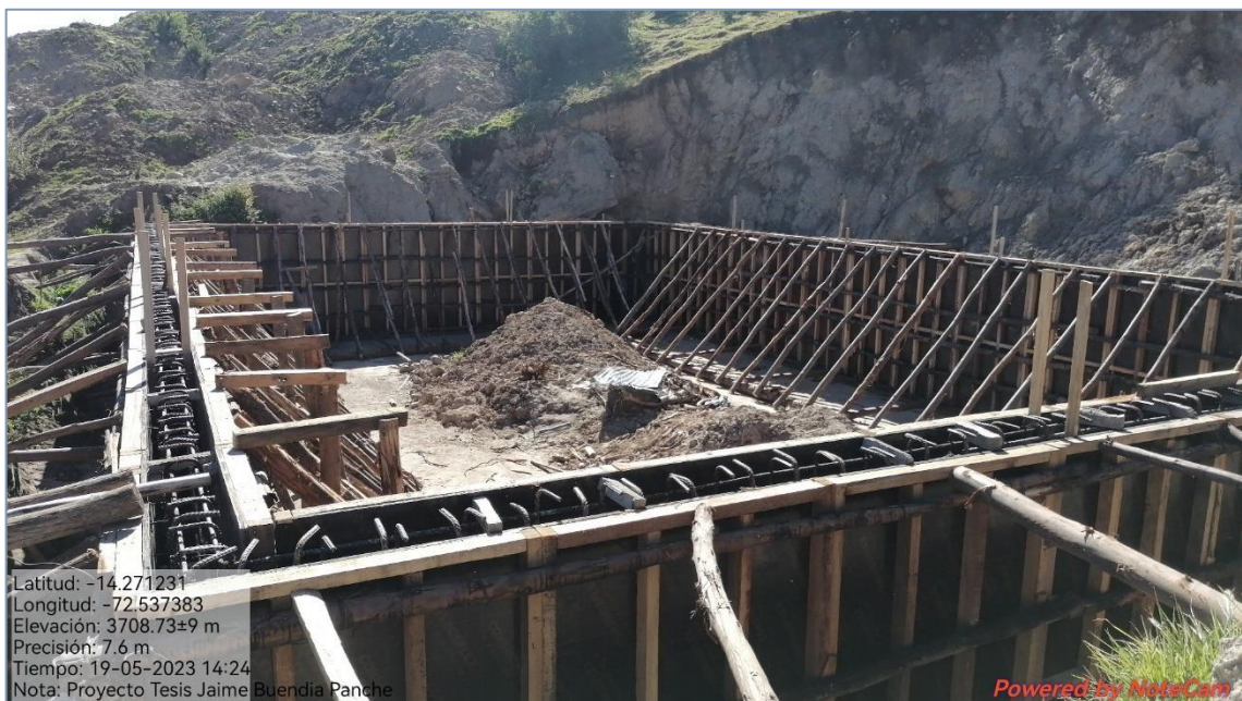
Figura 123 — Trabajos de encofrados en el reservorio Ccotoma, vista frontal
