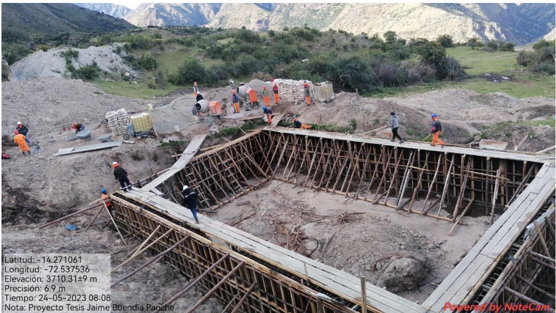
Figura 125 — Trabajos de encofrados reservorio Crusmocco vista lateral
