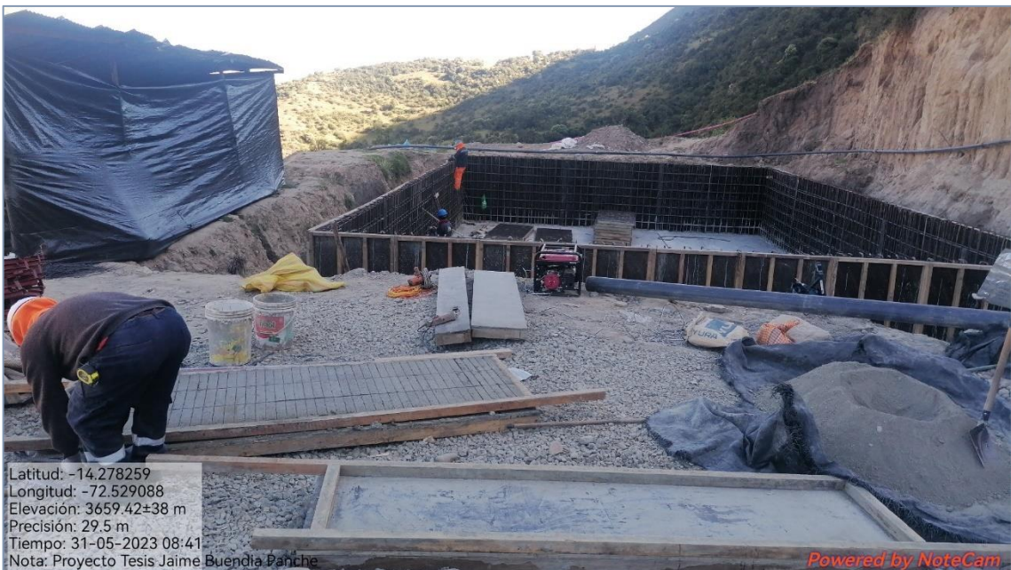
Figura 129 — Trabajos de encofrado reservorio Crusmocco vista posterior
