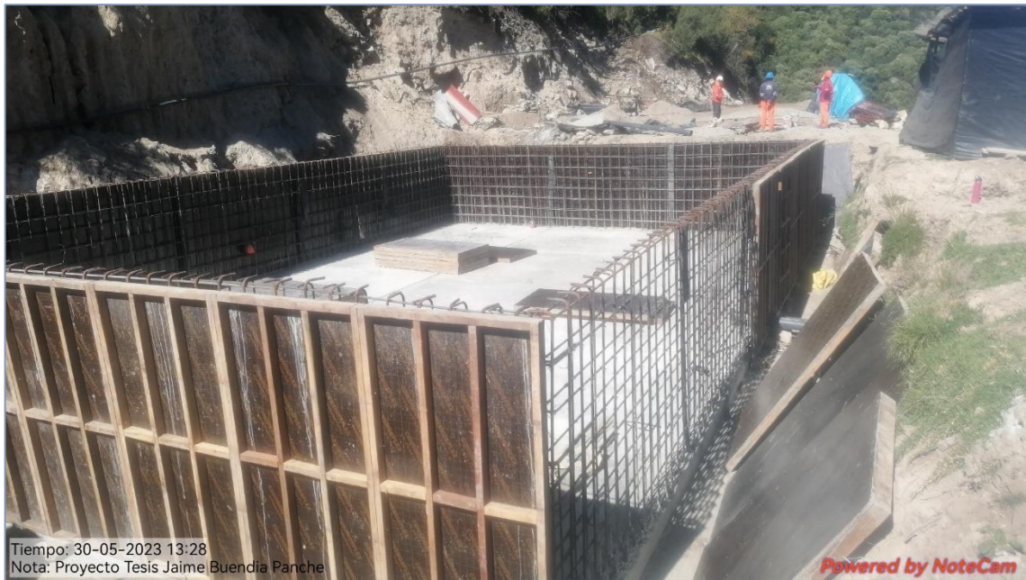
Figura 132 — Trabajos de encofrado reservorio Crusmocco vista posterior
