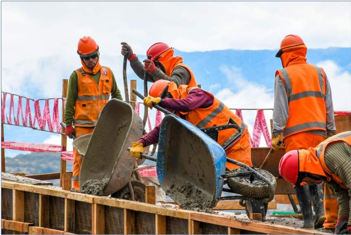
Figura 128 — Trabajos de vaciado de concreto reservorio Crusmocco
