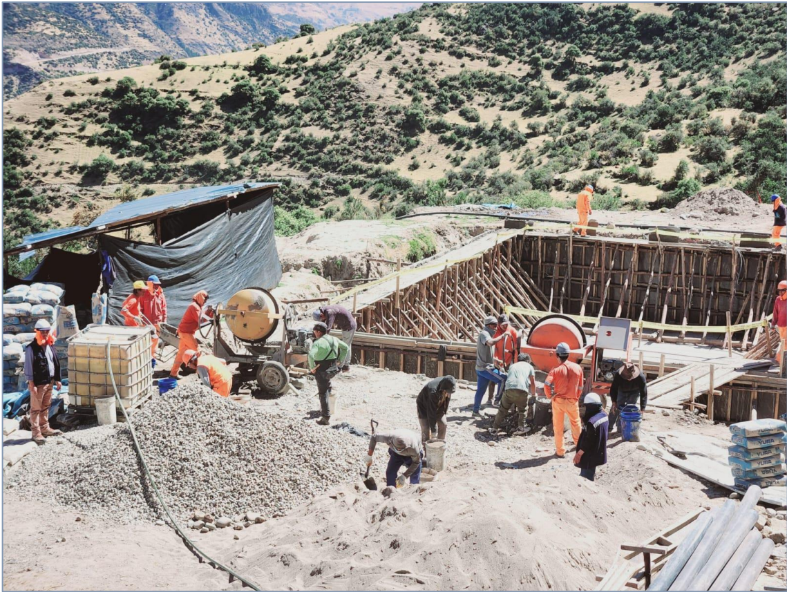
Figura 124 — Trabajos de vaciado de concreto reservorio Ccotoma
