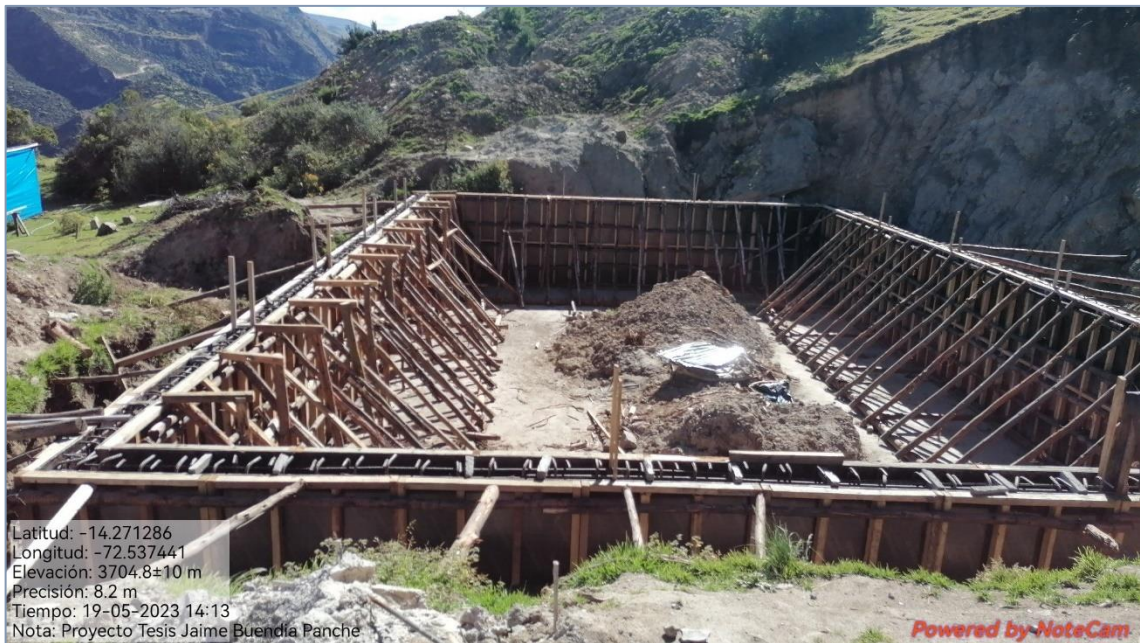
Figura 122 — Trabajos de encofrados en el reservorio Ccotoma, vista lateral
