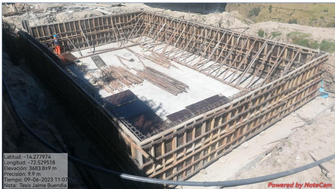
Figura 127 — Trabajos de encofrado reservorio Crusmocco vista superior
