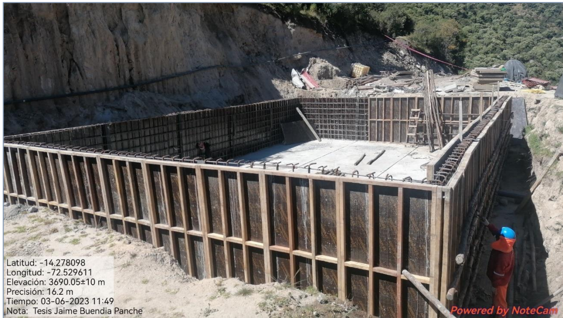
Figura 126 — Trabajos de encofrado reservorio Crusmocco vista lateral
