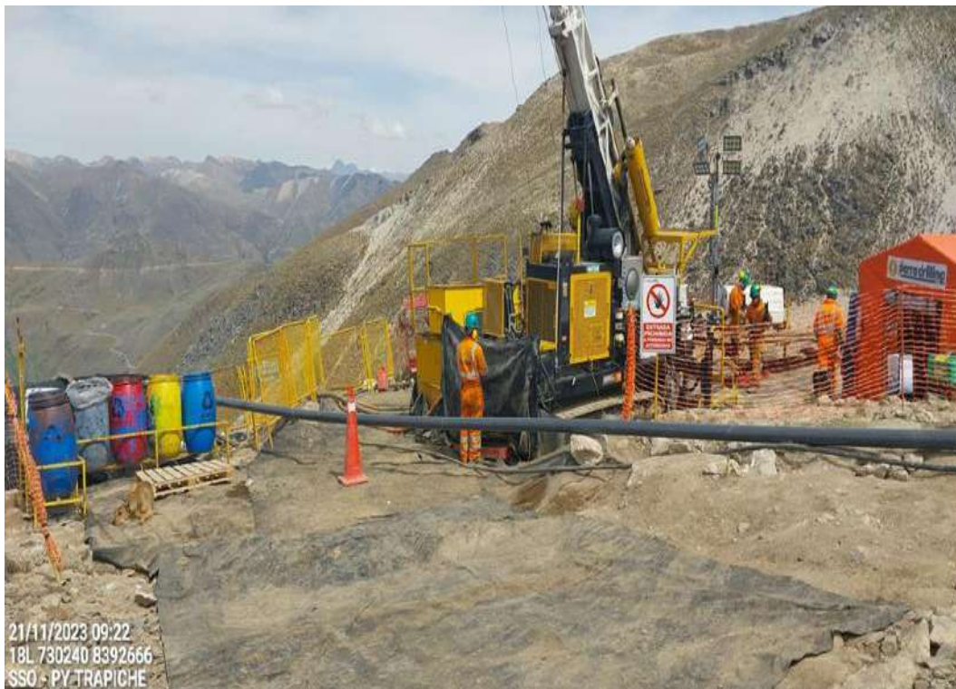
Figura 67 — Perforación diamantina realizado por Sierra Drilling
