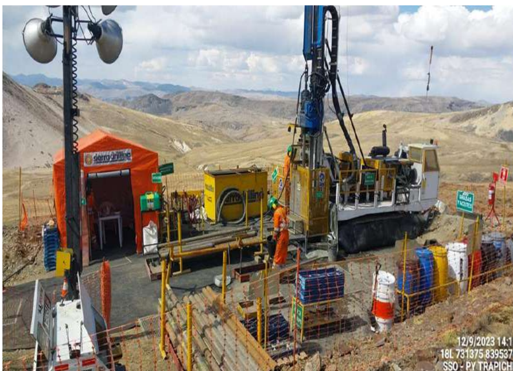
Figura 68 — Perforación diamantina realizado por Sierra Drilling
