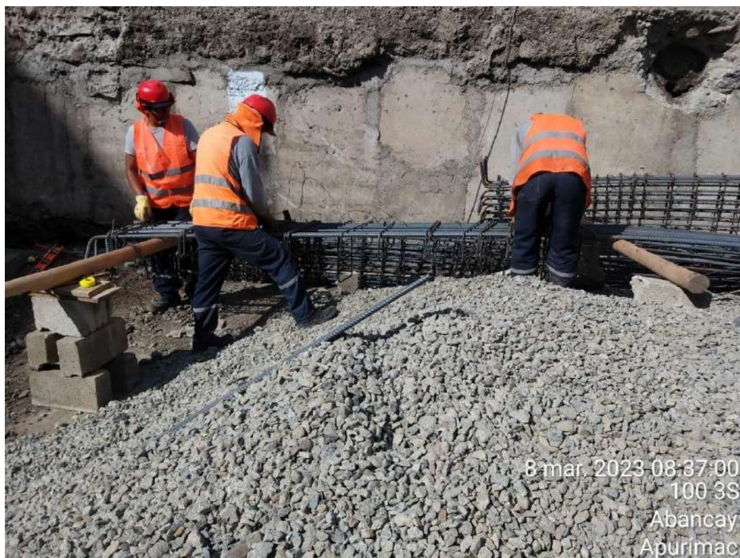
Figura 26 — Armado de acero de refuerzo en columnas de sótano
