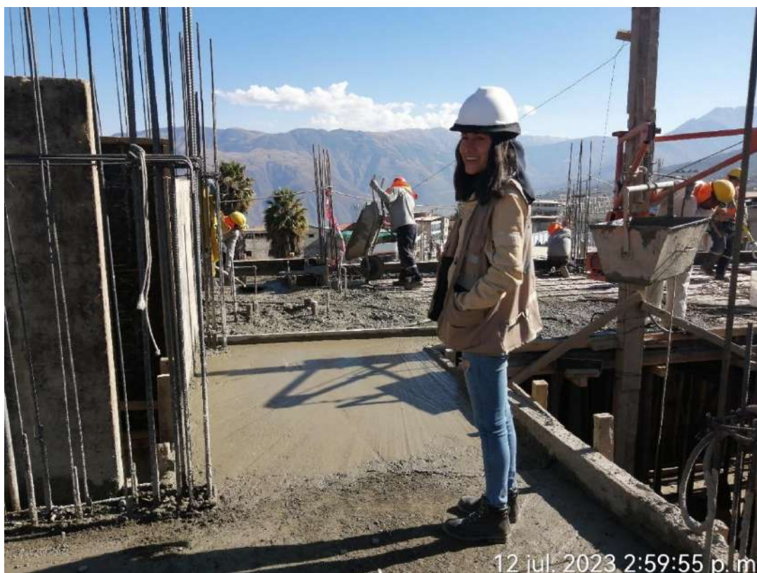
Figura 53 — Vaceado de concreto en vigas y losa del 3er nivel
