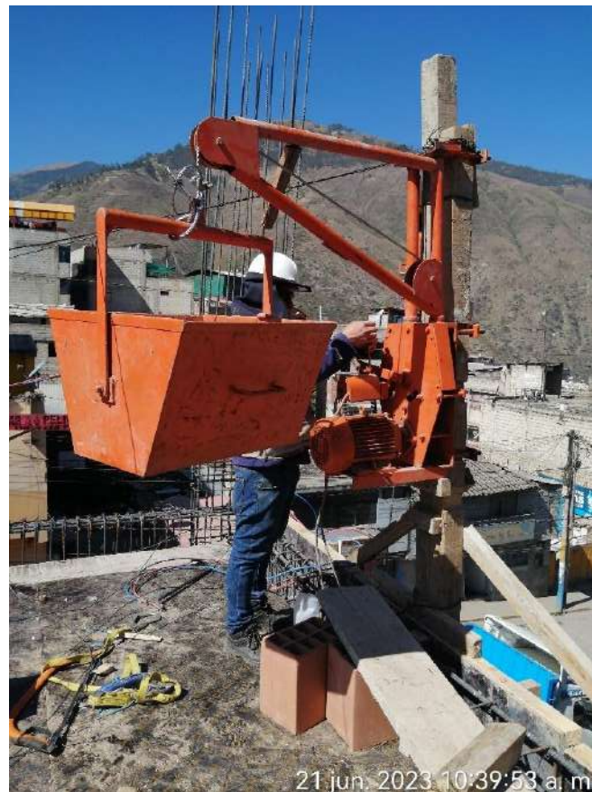
Figura 49 — Instalación de winche
