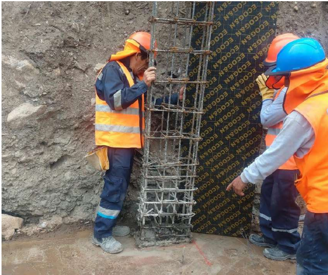
Figura 31 — Encofrado en columnas de sótano
