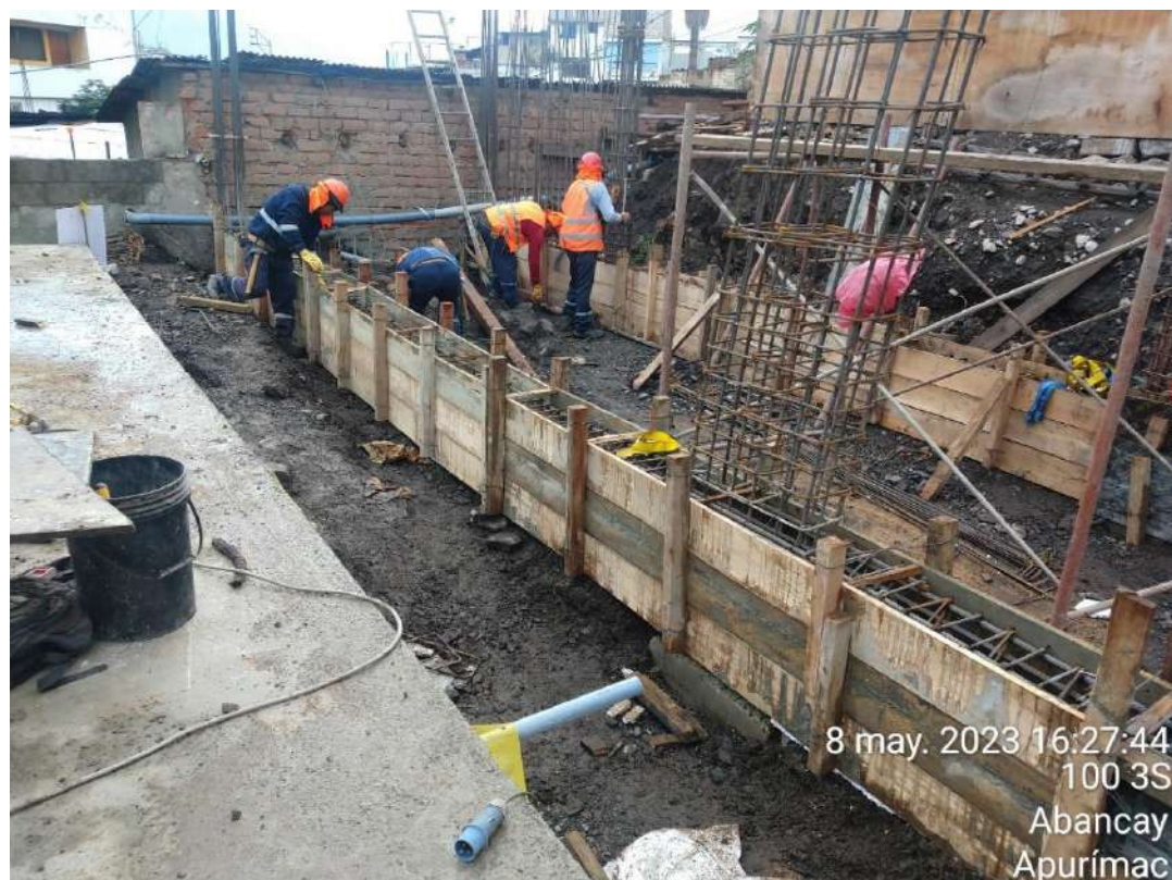
Figura 36 — Encofrado en vigas de cimentación
