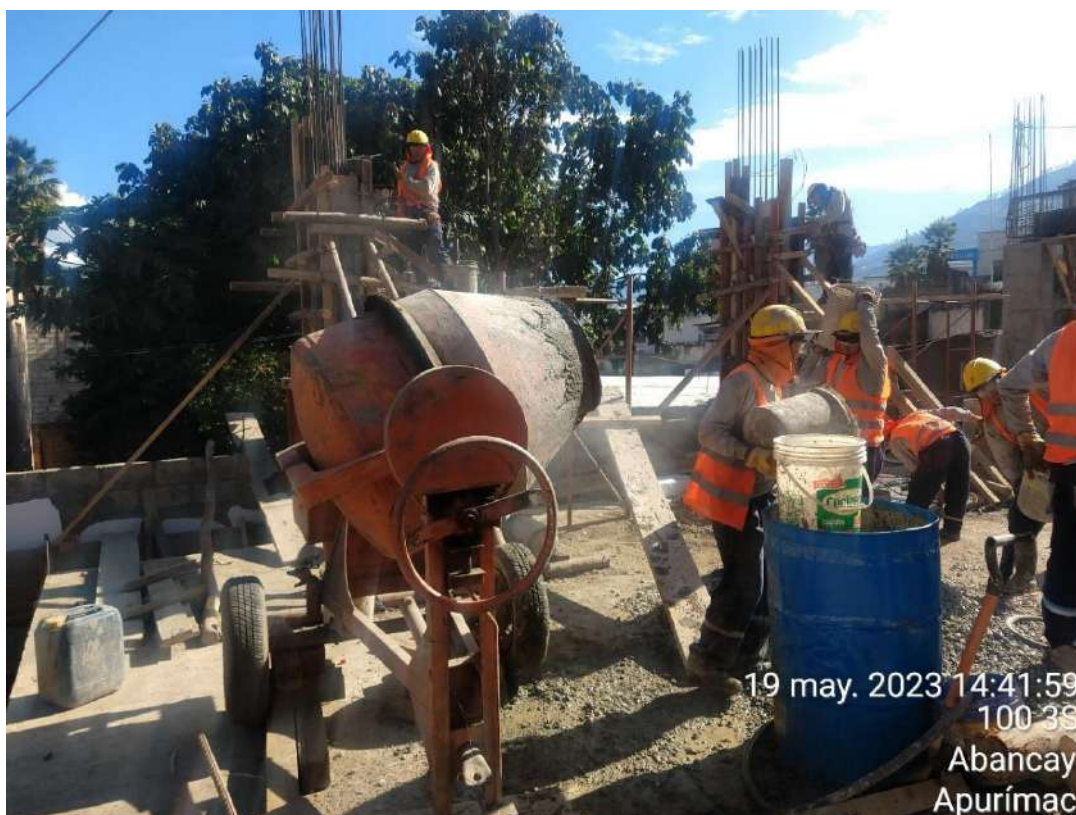
Figura 40 — Vaciado de concreto de columnas 1er nivel
