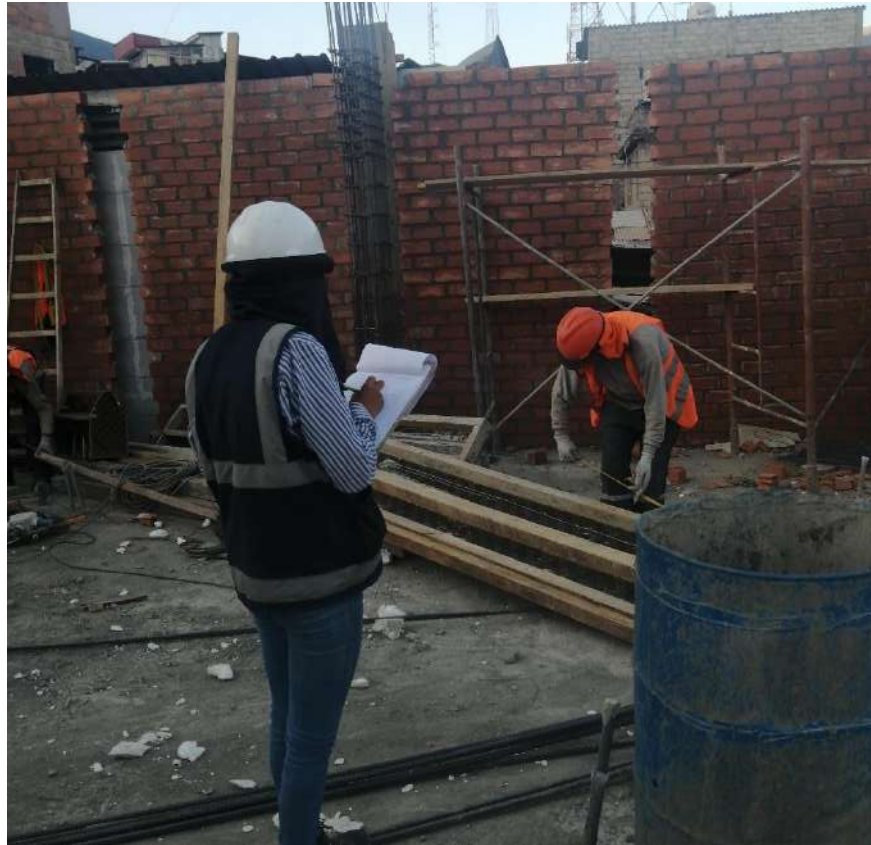
Figura 45 — Toma de datos de encofrado de columnas del 2do nivel
