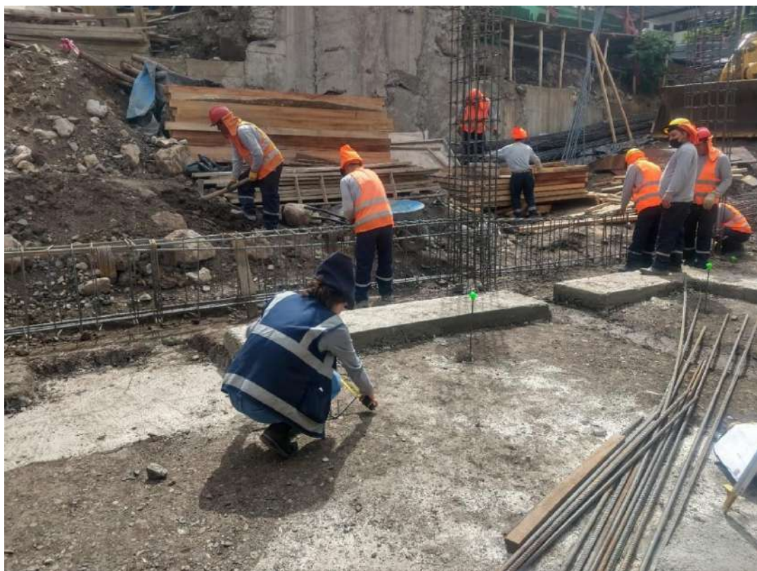
Figura 28 — Armado de acero de refuerzo en vigas de cimentación
