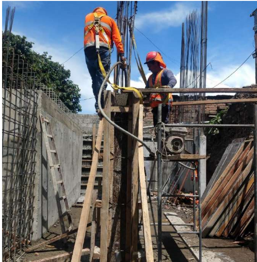
Figura 33 — Vaciado en columnas de sótano
