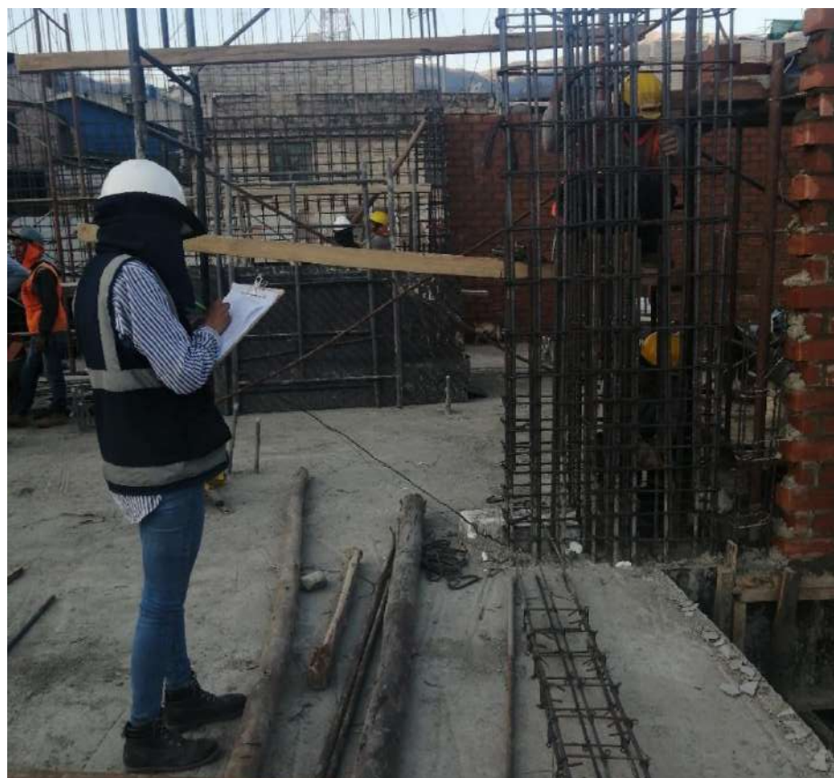
Figura 44 — Toma de datos en acero de refuerzo de columnas del 2do nivel
