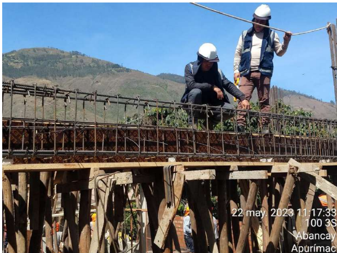
Figura 42 — Armado de acero de refuerzo en vigas del 1er nivel
