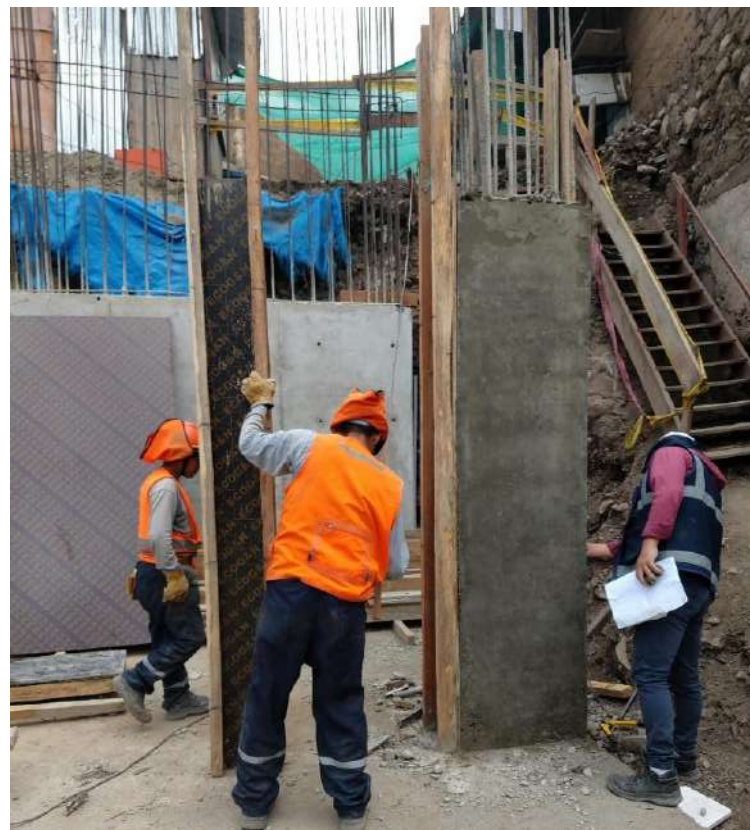
Figura 34 — Desencofrado en columnas de sótano
