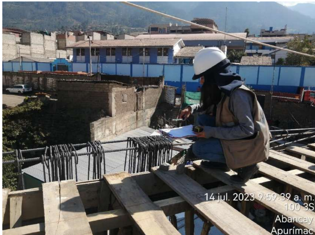
Figura 51 — Verificación del acero de refuerzo en vigas del 3er nivel
