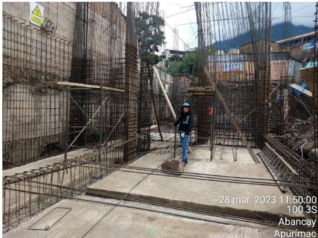
Figura 29 — Verificación de acero de refuerzo en vigas de cimentación
