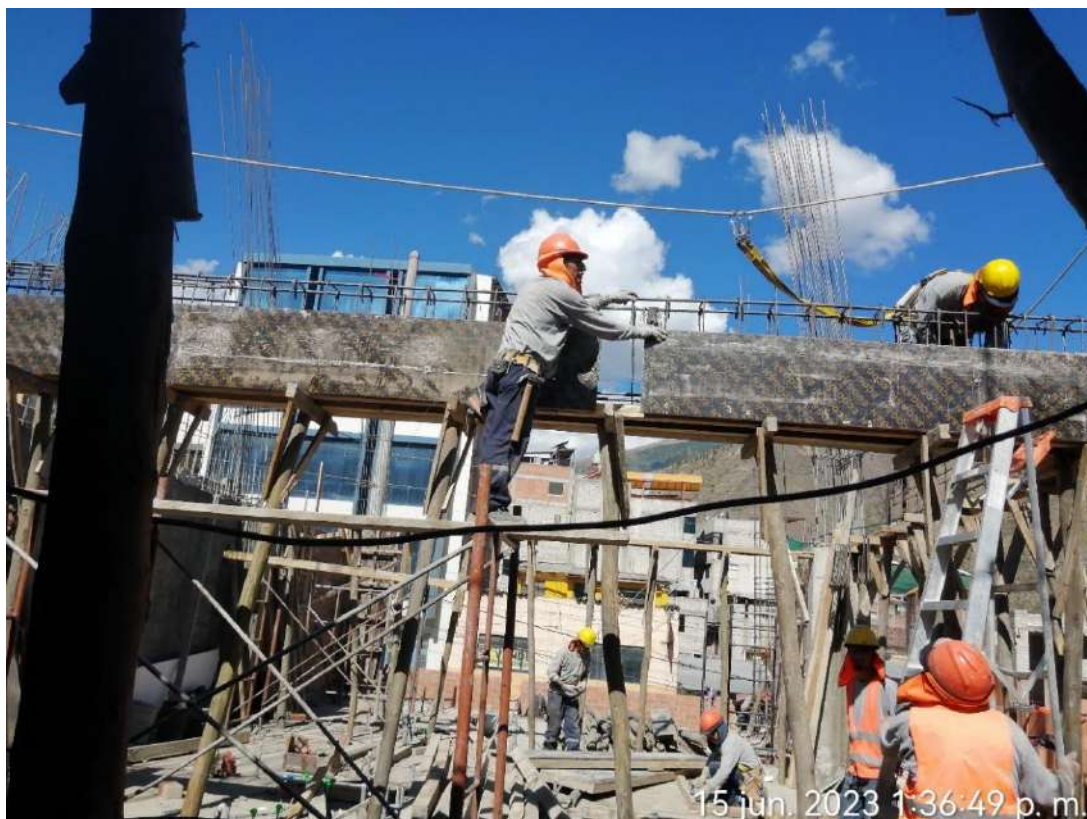
Figura 52 — Encofrado de vigas del 3er nivel
