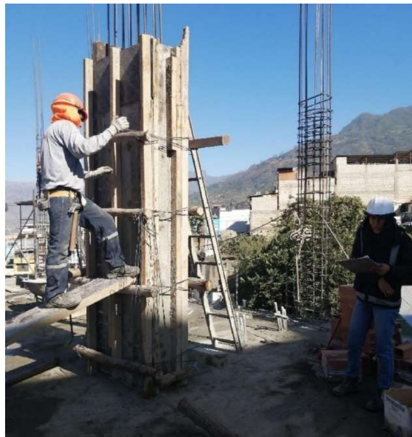
Figura 56 — Encofrado de columnas del 4to nivel
