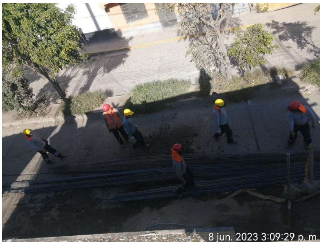
Figura 46 — Acarreo de acero de refuerzo
