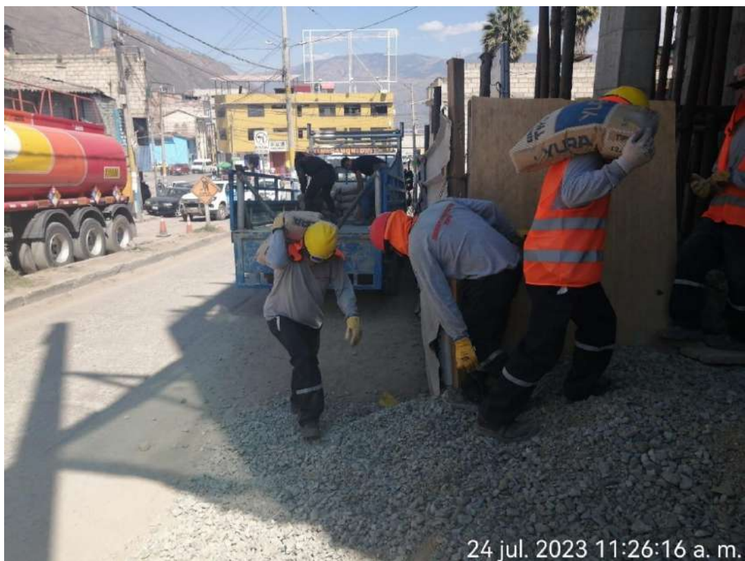
Figura 32 — Acarreo de cemento d=10m
