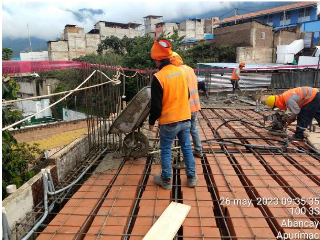
Figura 43 — Vaciado de concreto en vigas del 1er nivel
