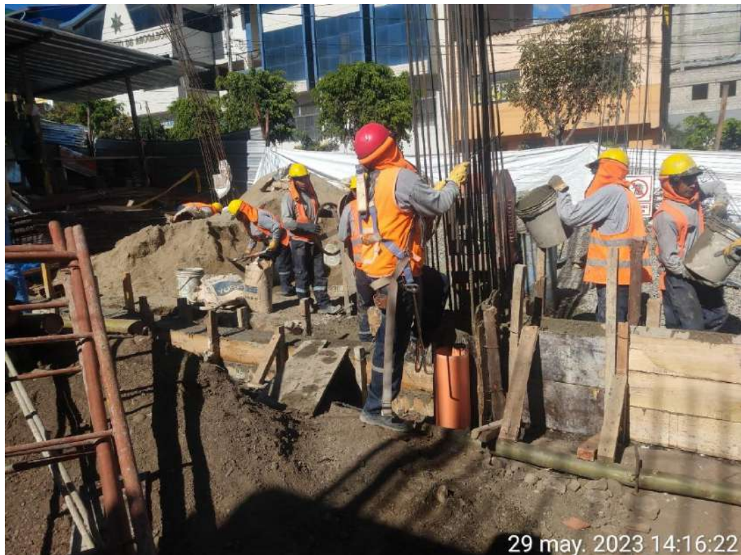
Figura 37 — Vaceado de concreto en vigas de cimentación
