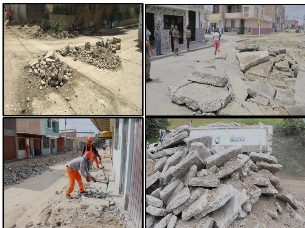
Figura 5 — Concreto reciclado de la av. Abancay
