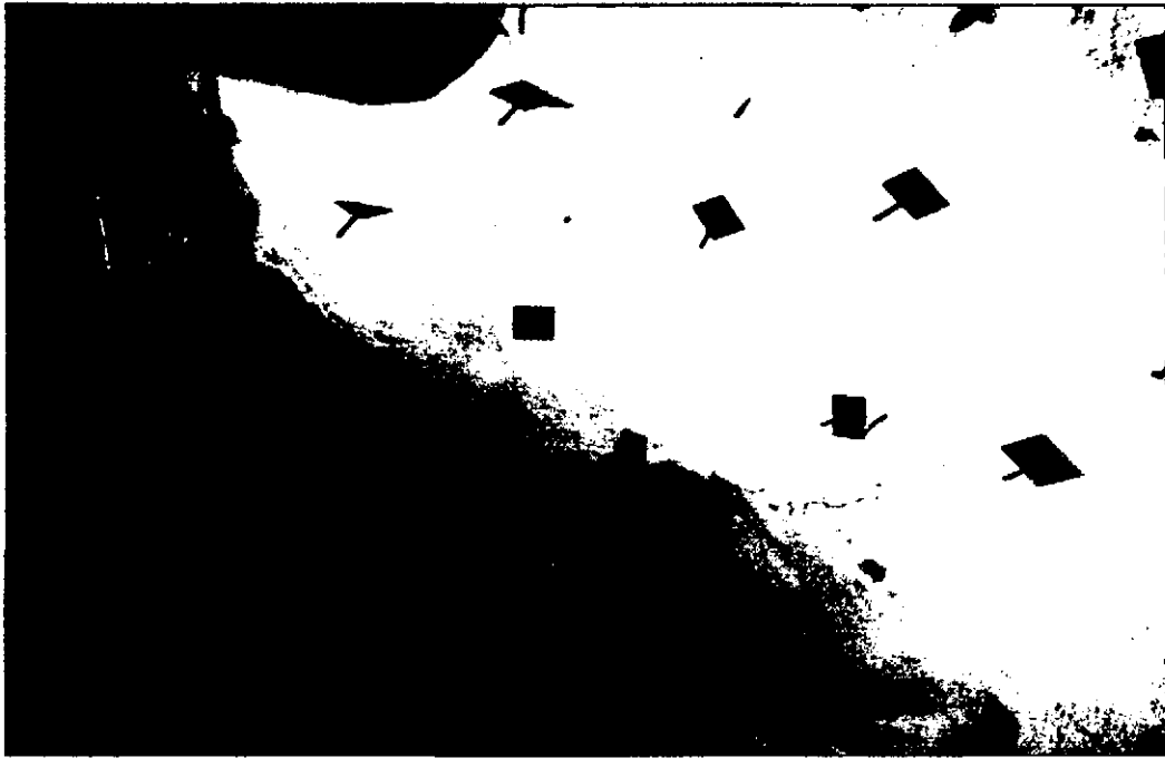
Foto 14. Sostenimiento con pernos helicoidales en la RP690S
