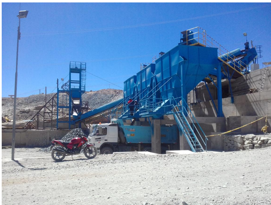
Fotografía 09: Pique B-5, Sistema de izaje – Superficie
