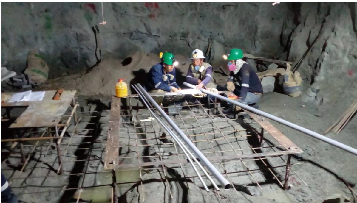
Fotografía 15: Pique B-5, estructura metálica en la Construcción base de Winche nv 7.
