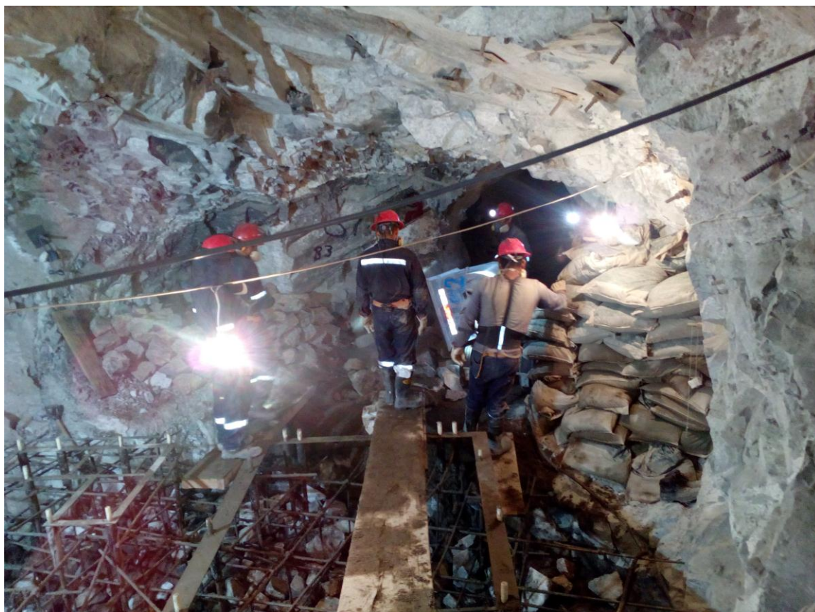
Fotografía 07: Estructura metálica construcción de base de winche nivel 7 de B-4
