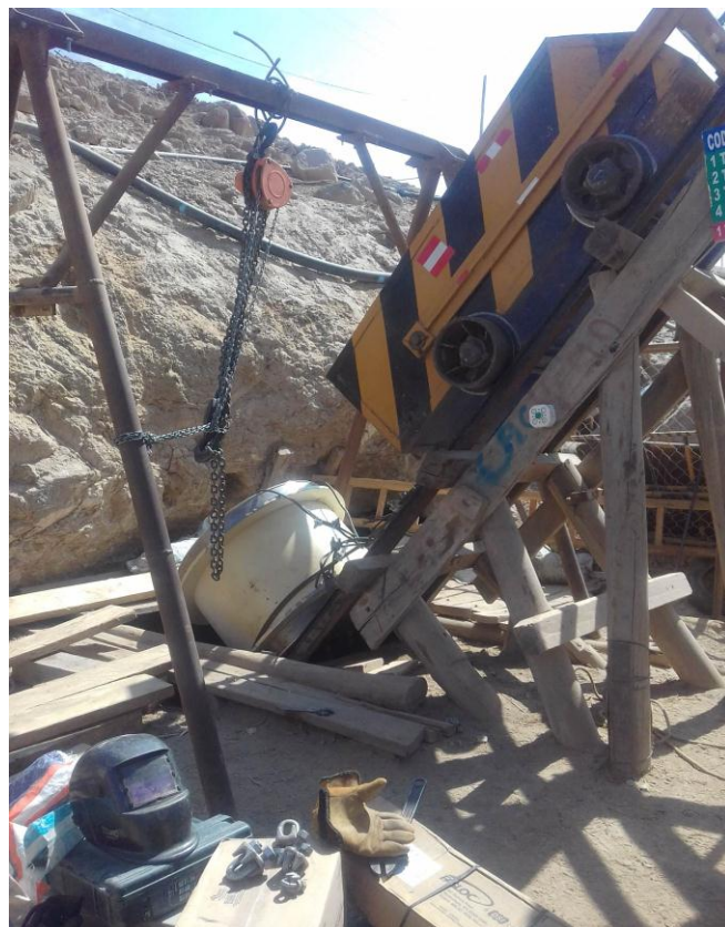
Fotografía 02: Pique B-4, Izaje de ingreso de tambora.
