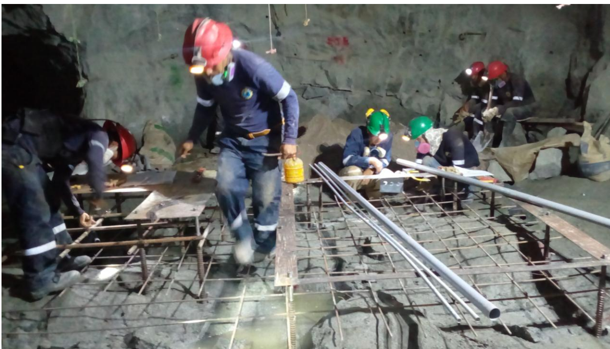
Fotografía 13: Pique B-5, Construcción base de Winche nv 7.
