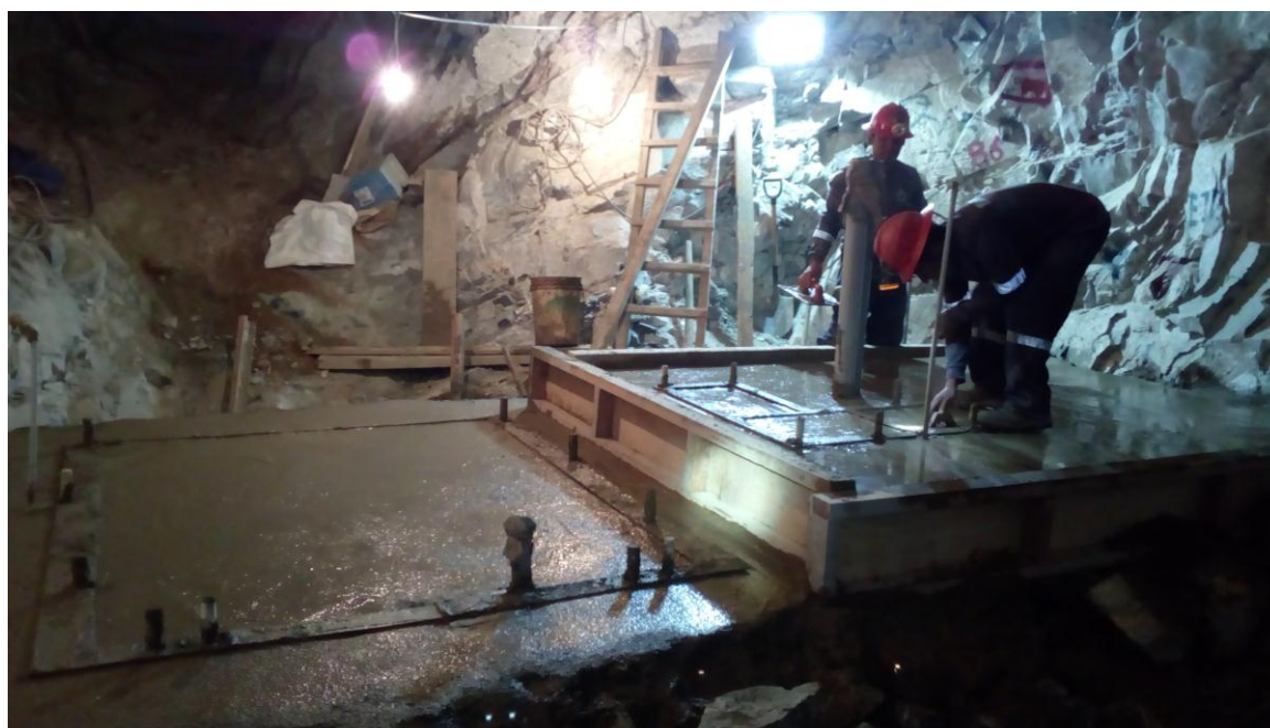
Fotografía 08: Construcción de base de winche nivel 7 de B-4
