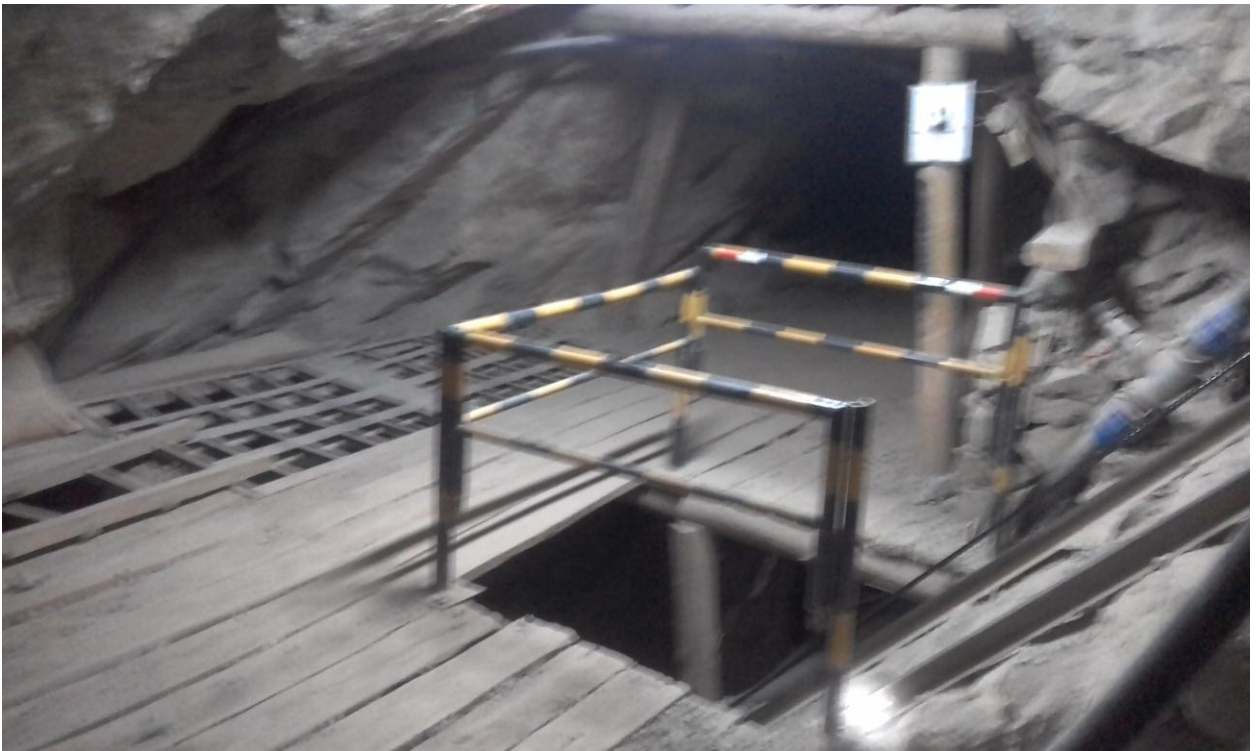
Fotografía 05: Pique B-4, Estación de pique nivel 6.
