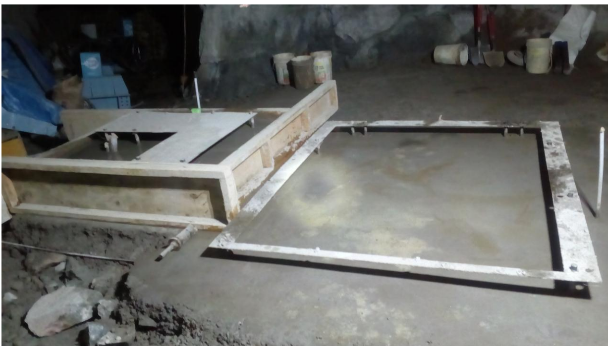
Fotografía 14: Pique B-5, Construcción base de Winche nv 7.
