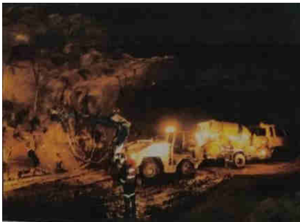
Figura N° 23.- Proceso de lanzado de “shotcrete” vía húmeda, Mina Animon.
