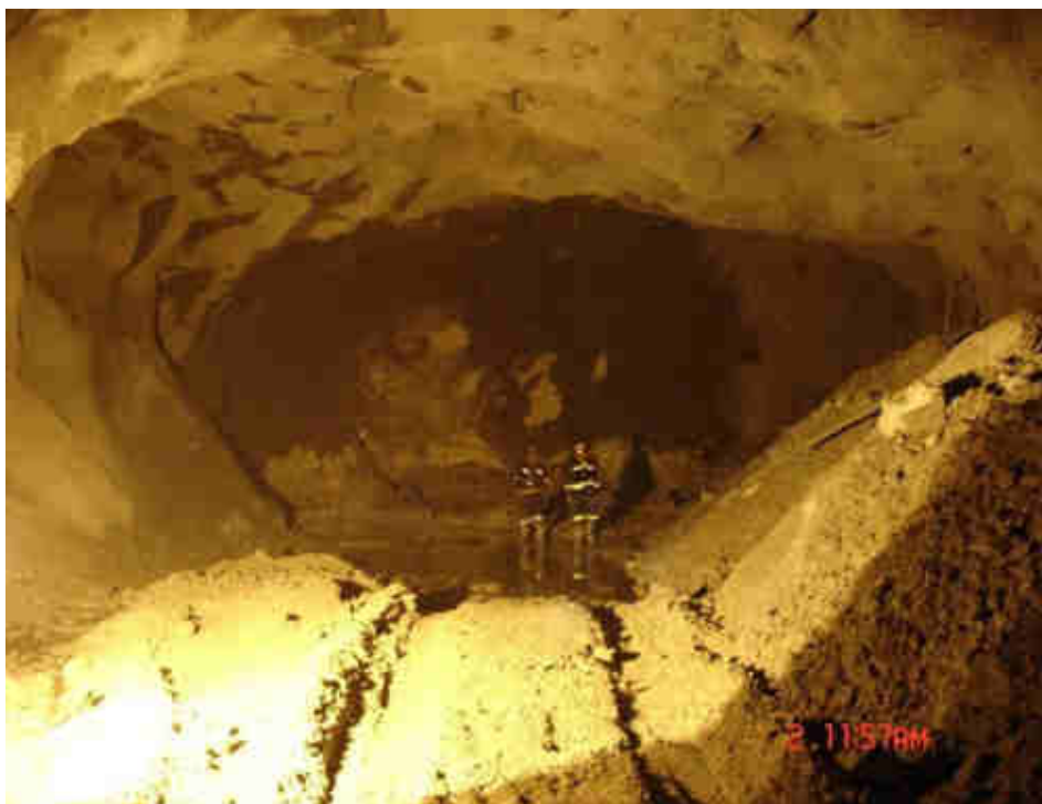
Figura N° 15.- Labor amplia de 12 metros de ancho, 6 metros de altura y buzamiento 45°, controlados con “shotcrete” Mina Animon.
