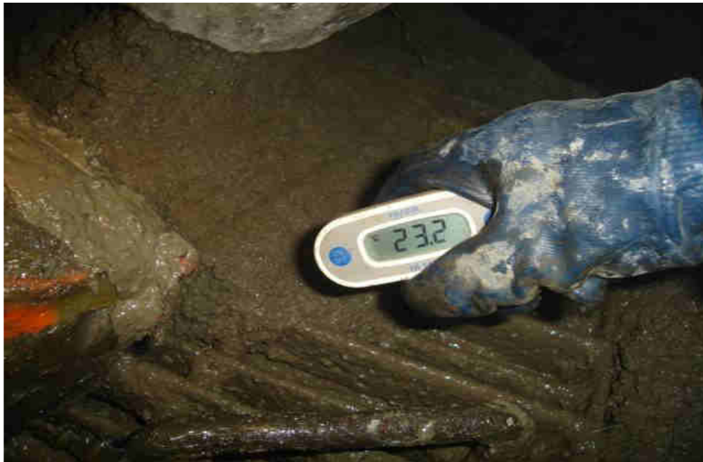
Figura N° 33.- Medición de Temperatura de la mezcla para shotcrete, Mina Animon.
