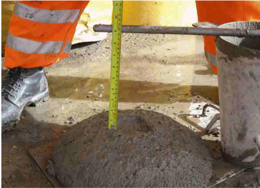
Figura N° 31.- Medición de Slump de mezcla vía húmeda, Mina Animon.
