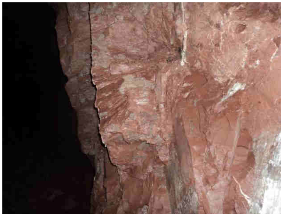
Figura N° 18.- Macizo rocoso de marga roja, Mina Animon. Fuente: (Estudio Geomecánico detallado de Mina Animon).
