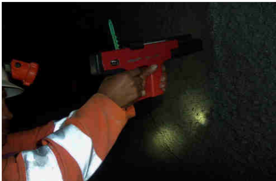
Figura N° 35.- Accionamiento del clavo de impacto, Mina Animon. Fuente: (Elaboración Propia).
