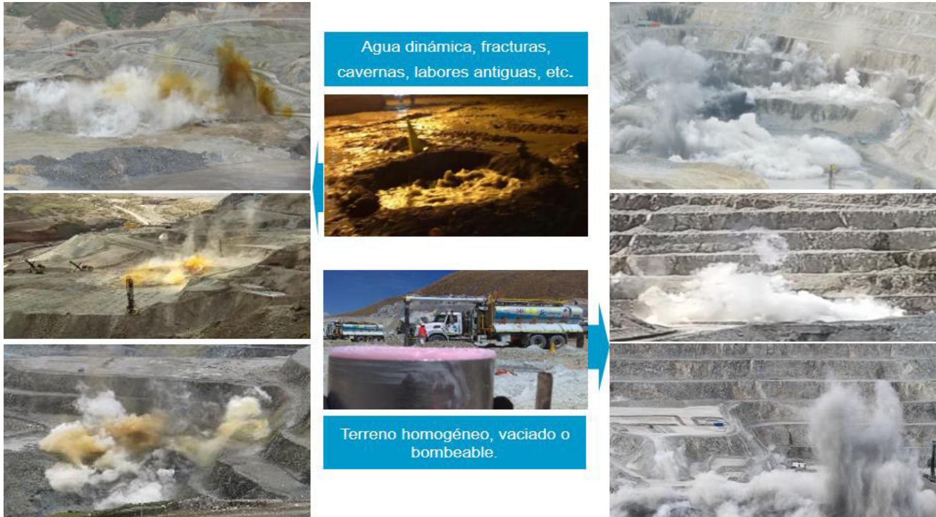
Fotografía 4-29: Emisión de gases producidos post voladuras “Tajo Ferrobamba”. Fuente: Asistencia Técnica (ORICA) “Las Bambas”.
