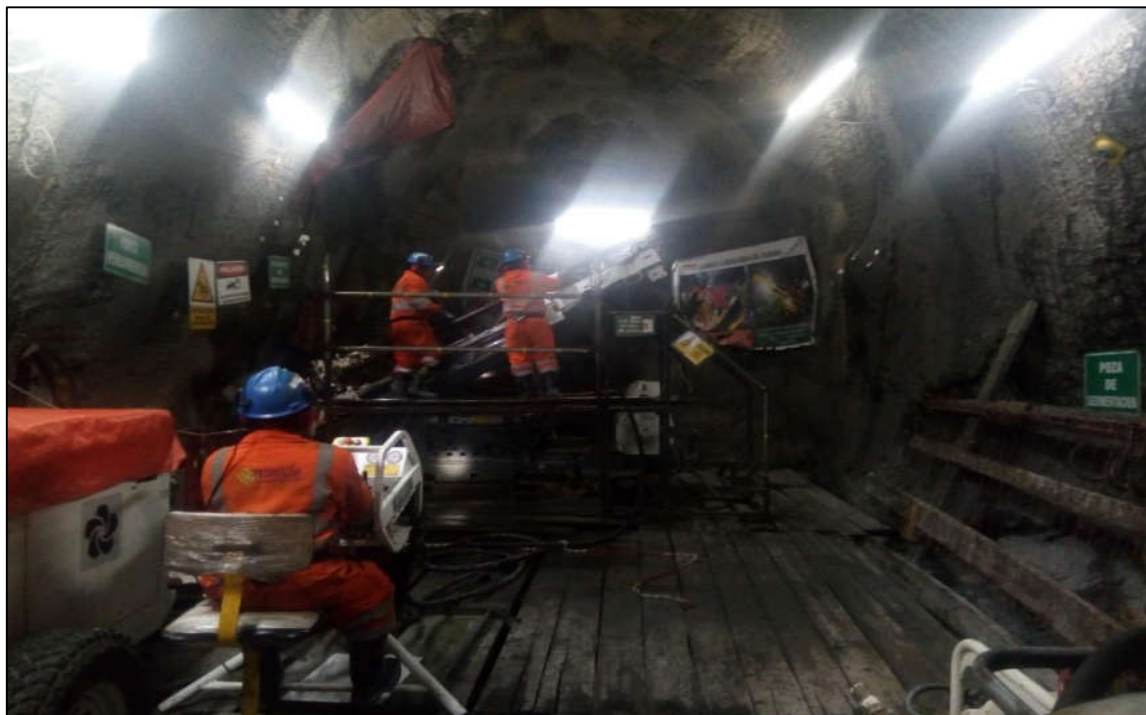
Figura 22. Operadores y ayudantes en la perforación
