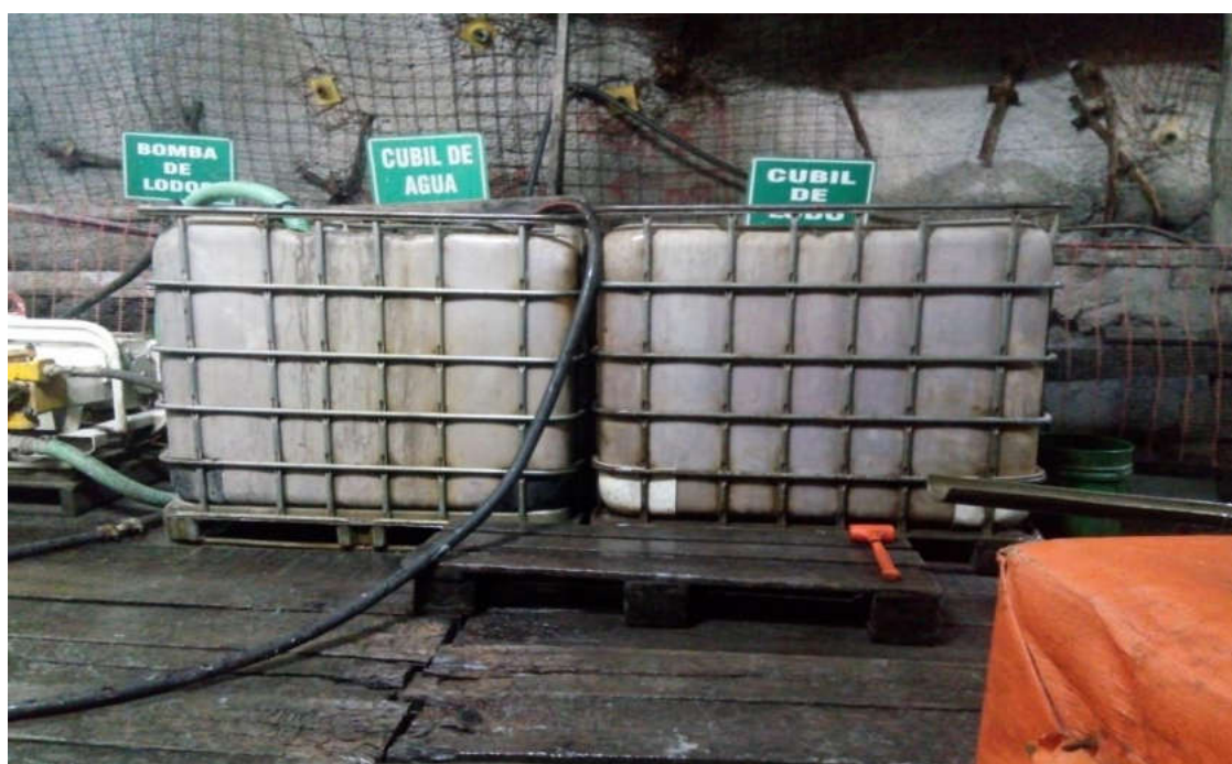
Fotografía 5: Cubil de lodos
