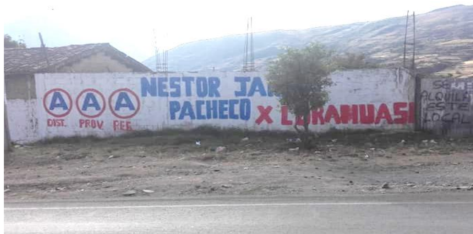
Figura 8: Fachada pintada con yeso y esmalte en avenida principal
