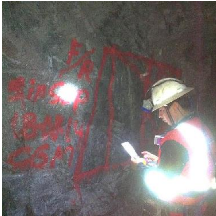
Figura N°. 92: Mapeo geomecánico en la Gal. 2140 E
