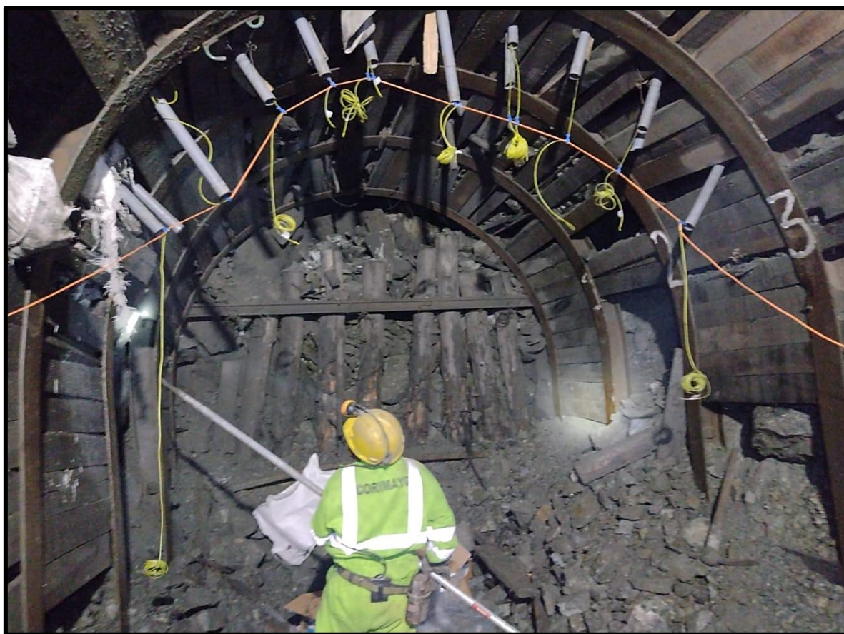
Figura 60 — Taladros cargados con explosivos amarrados al cordón detonante.
