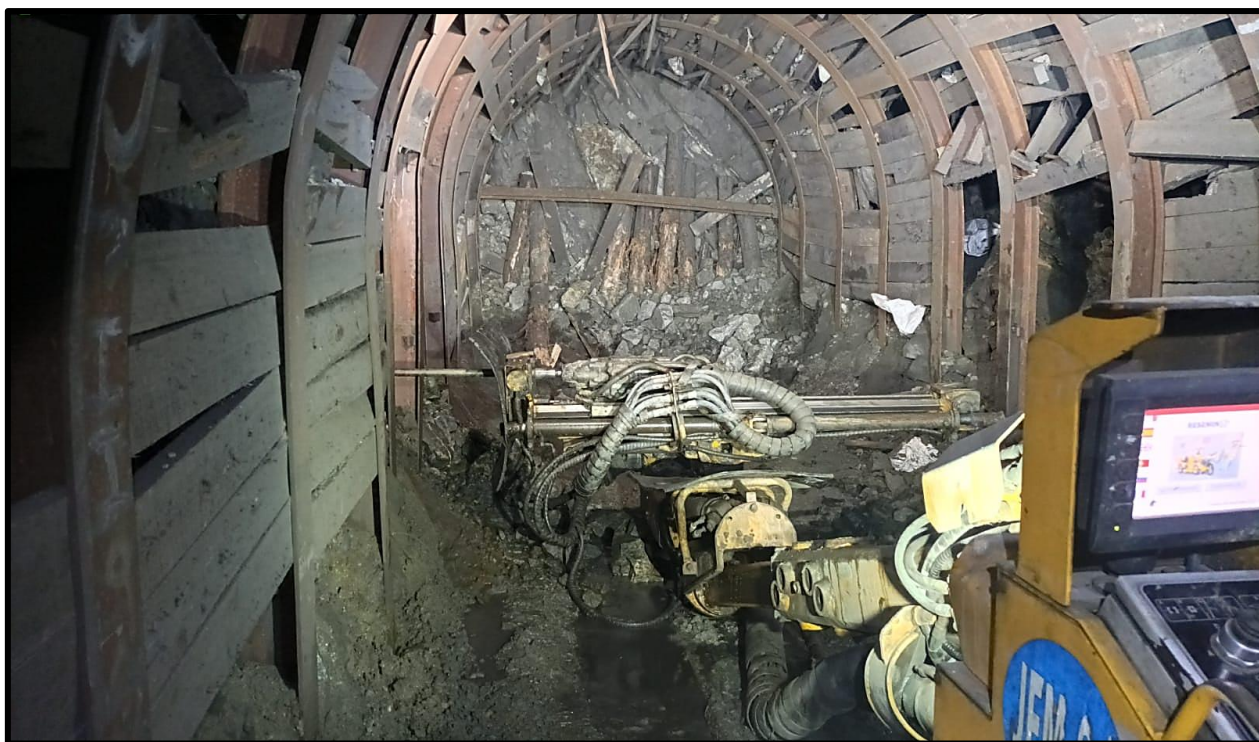
Figura 56 — Bolsillo Izquierdo en inicio de perforación para generar cara libre.
