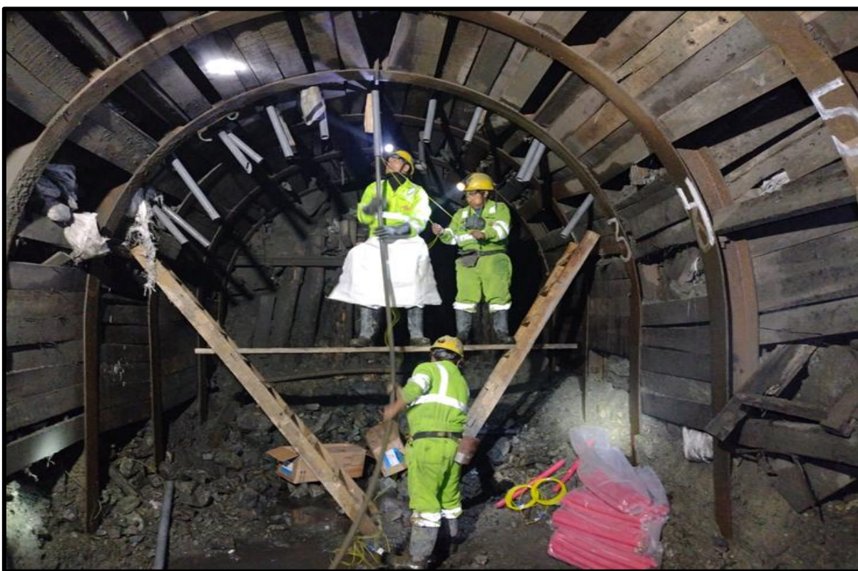
Figura 59 — Cuerpo en proceso de carguío de taladros con explosivos.
