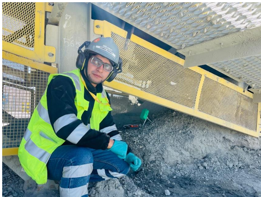
Figura 21 — Instalación del sistema en la faja transportadora sin protección de polvo por el estudiante Queen Dennis Vargas Ovalle (miembro)
