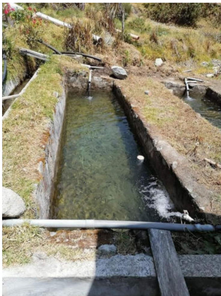
Figura 12. Poza de cultivo rectangular de piedra y cemento
