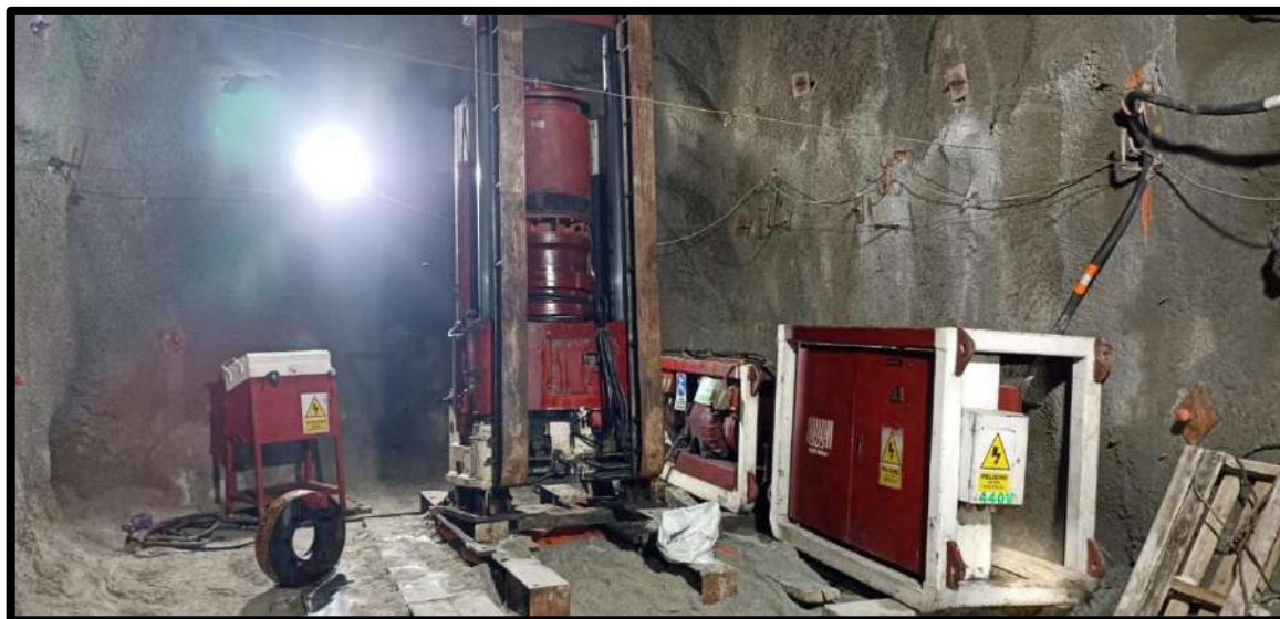
Figura 34 — Inicio de la implementación del RB 060.
