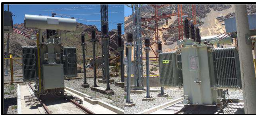
Figura 17 —Transformadores de 6/7.5 MVA de sub-estación N°1.
