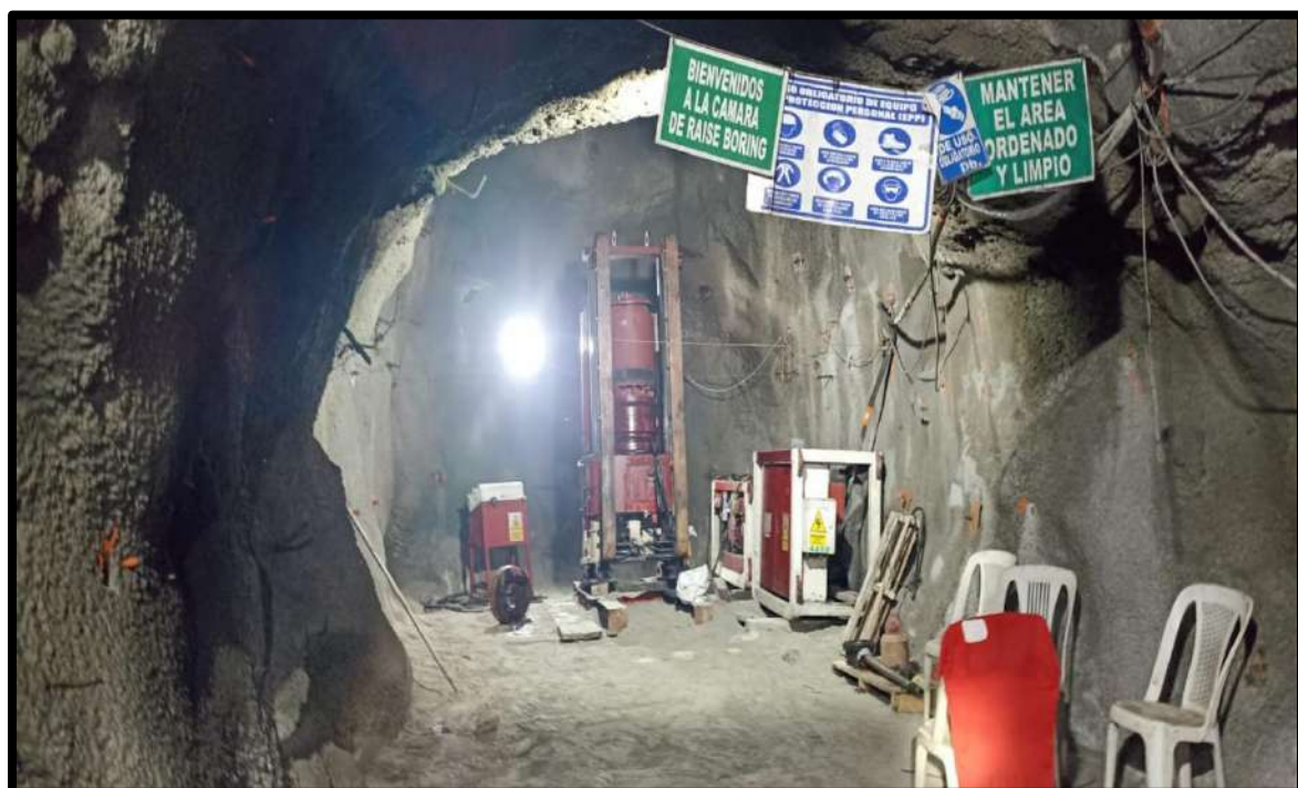
Figura 60 — Equipo Raise Boring Apayana.
