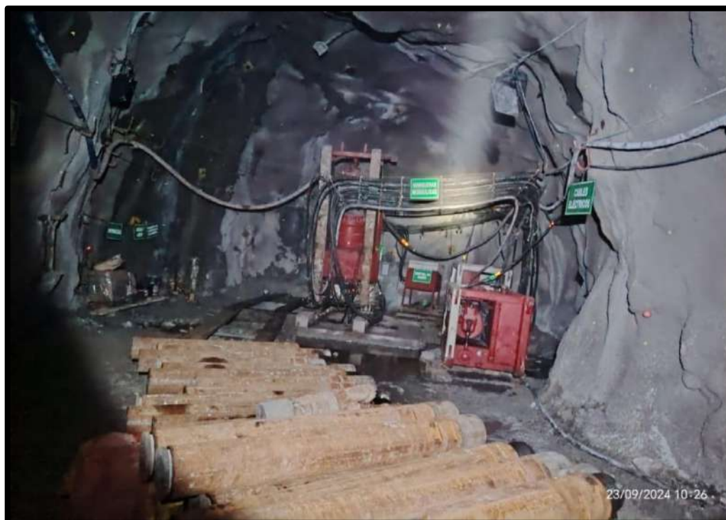
Figura 36 — Equipo Raise Boring para la ejecución proyecto RB 060.
