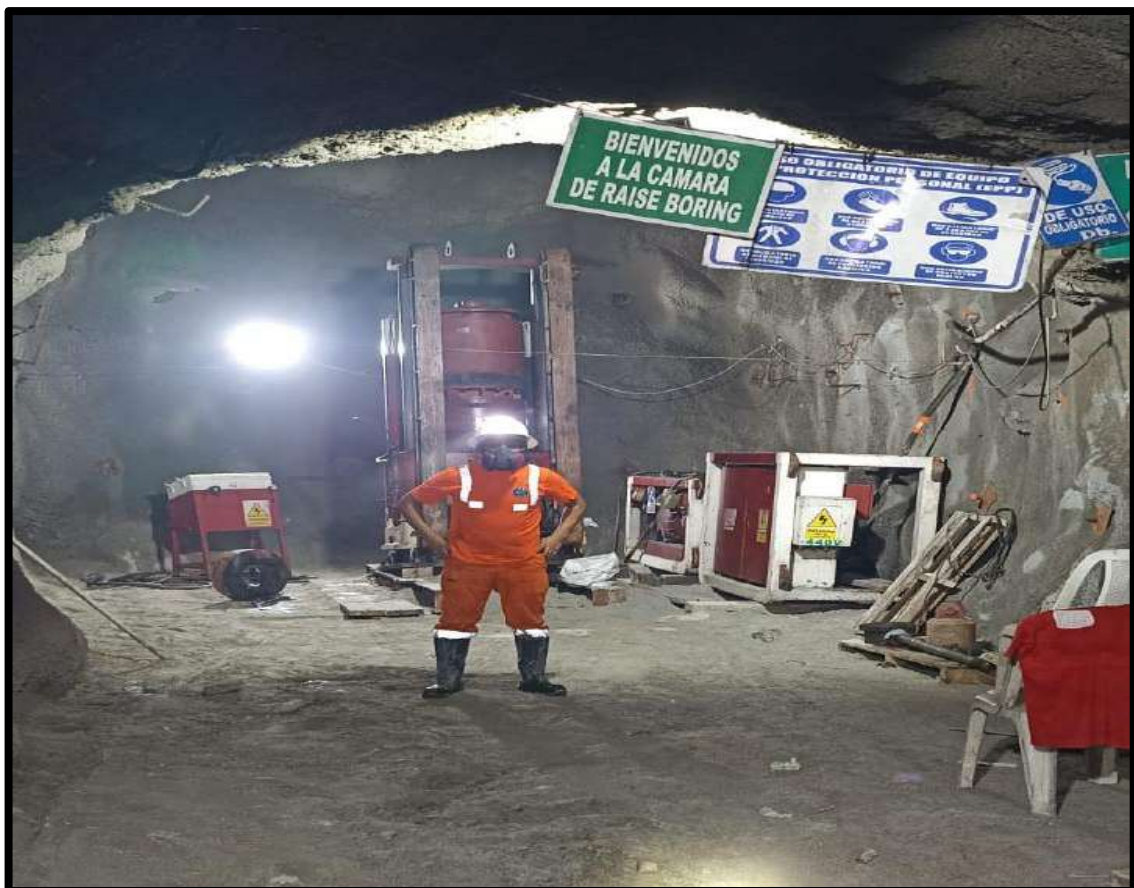
Figura 62 — Instalación del equipo RB nivel 21A.
