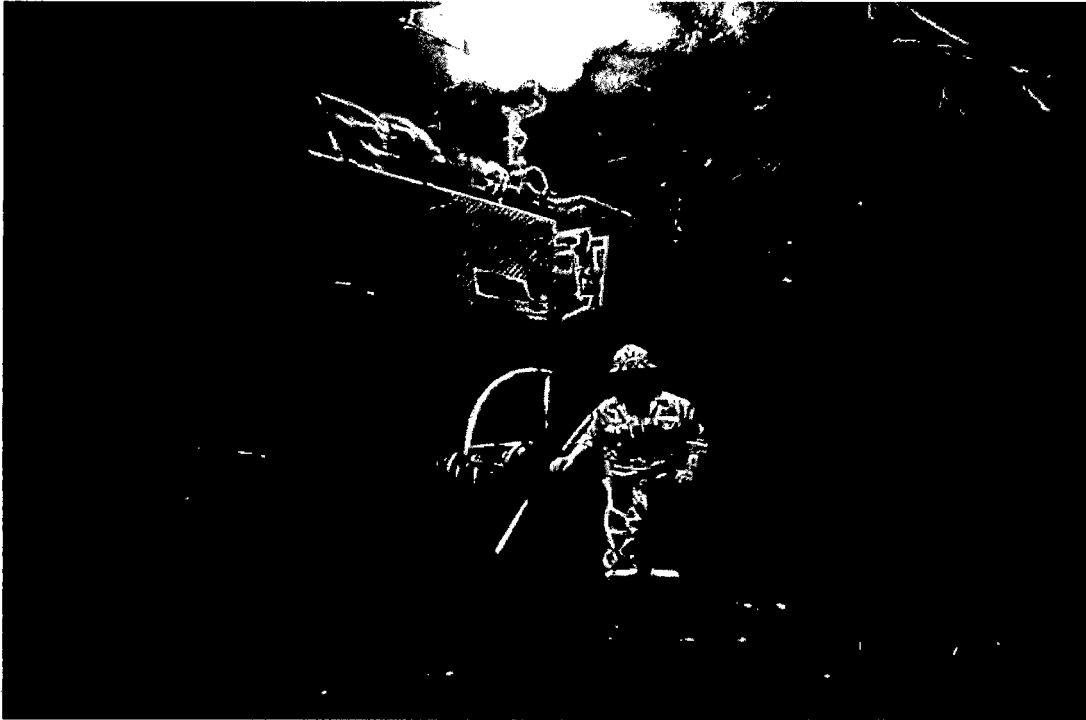
Fotografía N°01. Preparación de la cámara e instalación del equipo Alimak.
