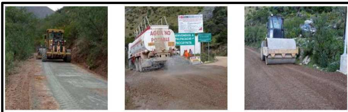
Figura 9 — Aplicación del aceite sulfonado IONICSOIL
