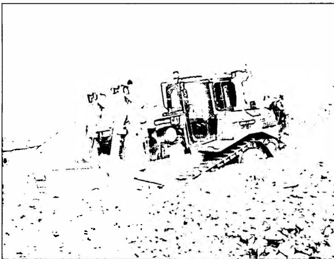
Figura 24: Construcción de rampa-tractor D8R
