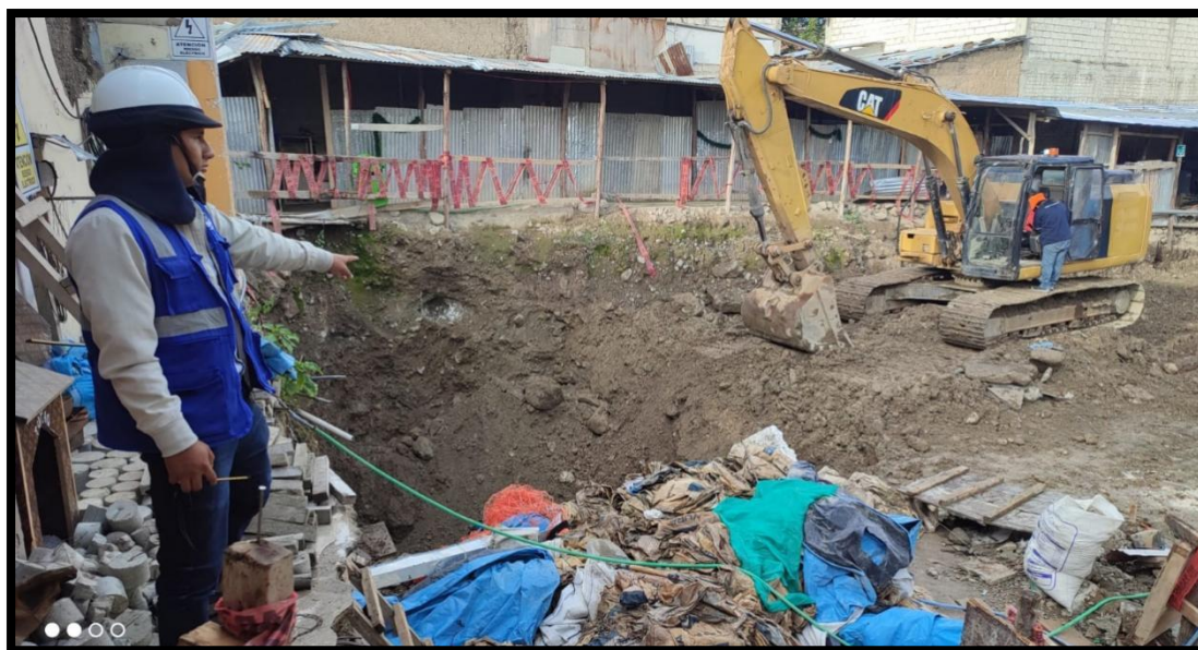
Figura 32 — Seguimiento de la programación de excavación de zapatas.
