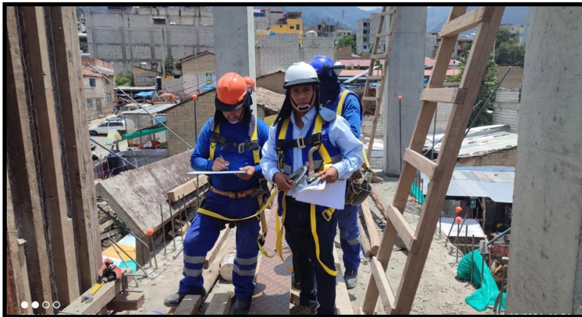
Figura 31 — Retroalimentación del uso correcto de los EPP's.
