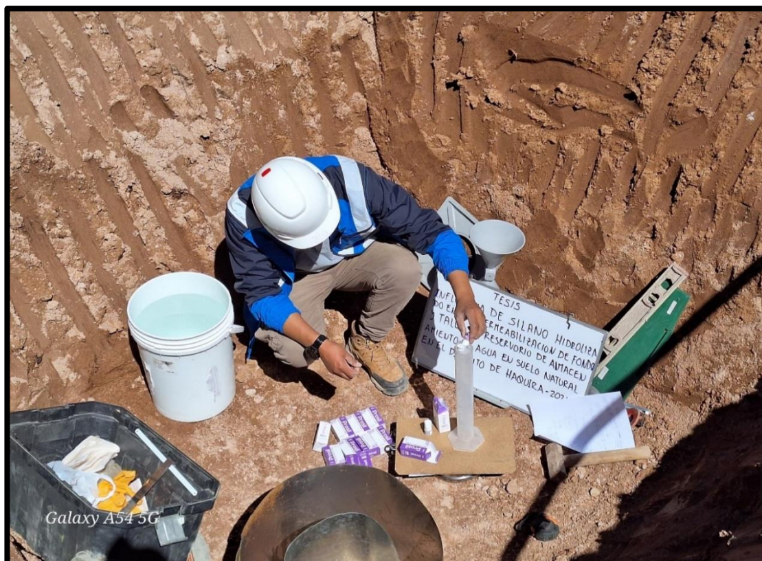
Figura 26 — Preparación de silano hidrolizado para el fondo de reservorio
