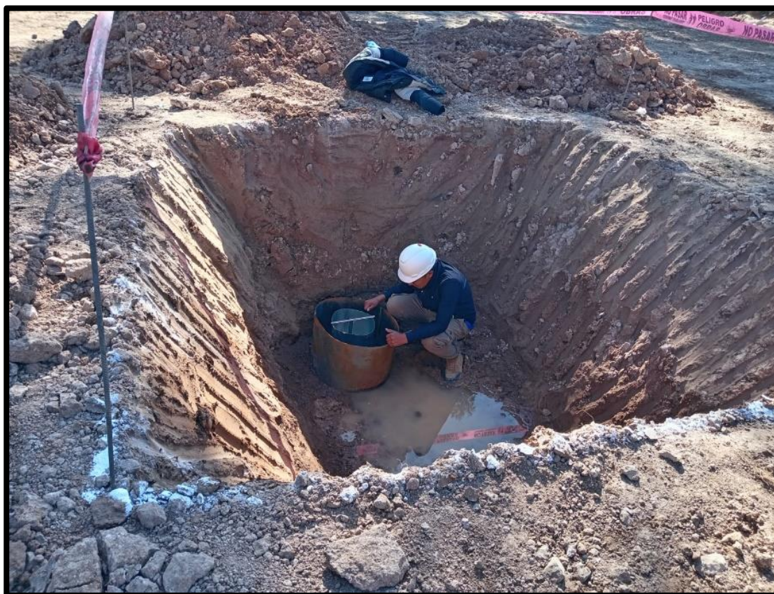
Figura 32 — Medición de permeabilidad en el fondo del reservorio
