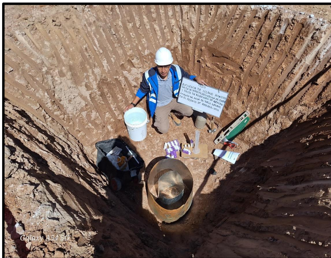
Figura 28 — Suelo tratado con silano hidrolizado del fondo reservorio
