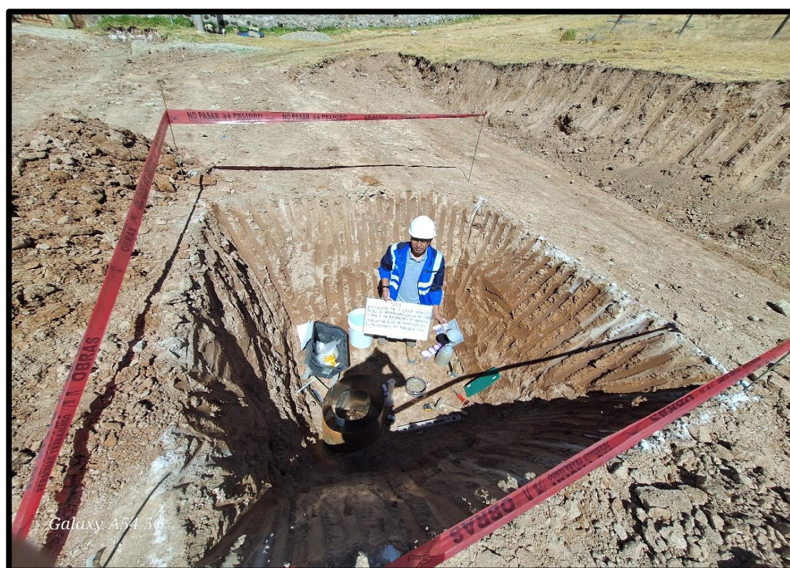
Figura 37 — Se observa el reservorio señalado con cinta para sus respectivos ensayos
