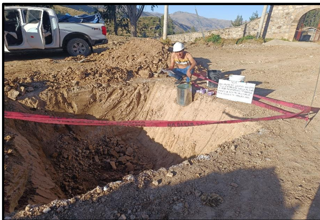
Figura 25 — Medición de infiltración en talud reservorio sin tratamiento
