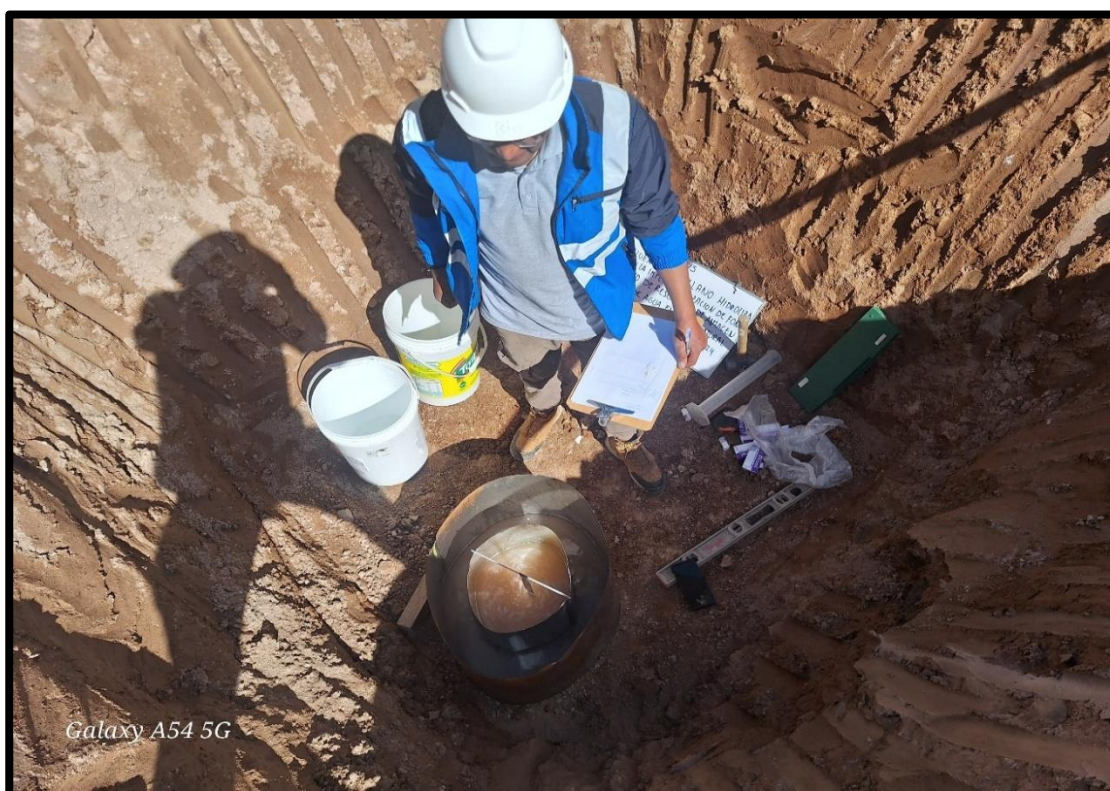
Figura 29 — Ensayo con tratamiento en el fondo de reservorio
