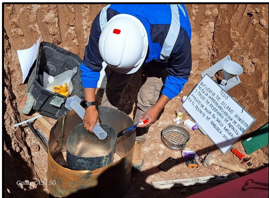
Figura 27 — Tratamiento del fondo de reservorio con silano hidrolizado
