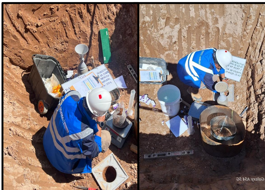
Figura 21 — Prueba de densidad de campo en el fondo de reservorio
