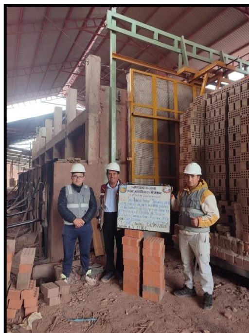
Figura 53 — Cocción de ladrillo de arcilla King Kong 18 huecos 9x24x12.5 cm a temperatura T=1100\text{ }^{\circ}\text{C} en la ladrillera LATER. distrito de San Jerónimo, provincia Cusco - Cusco
