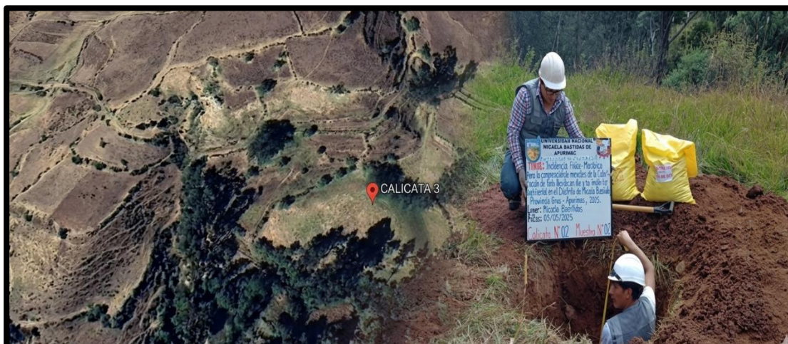
Figura 8 — Geolocalización de la Calicata N° 3
