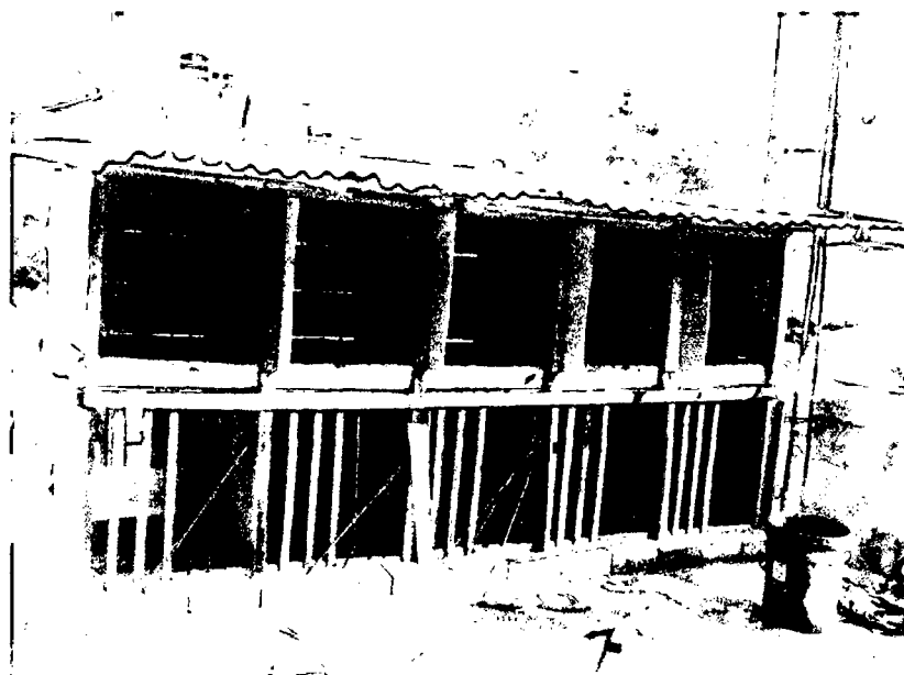
Figura 4. Construcción de jaulas de madera con rejas de fierro corrugado en la ciudad de Abancay, 2013
