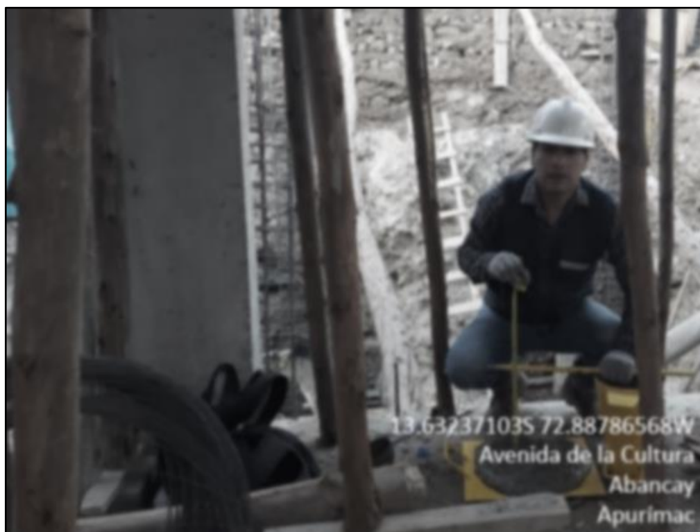
Figura 50 — Ensayo del asentamiento del concreto
