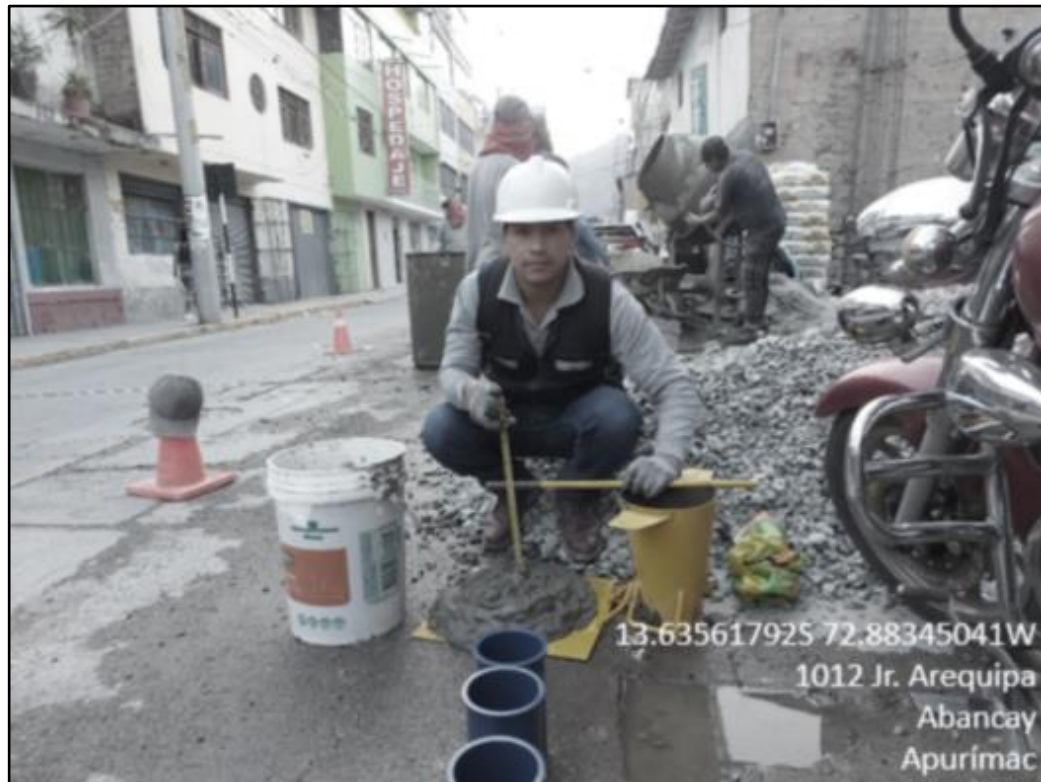
Figura 53 — Elaboración de probetas de concreto
