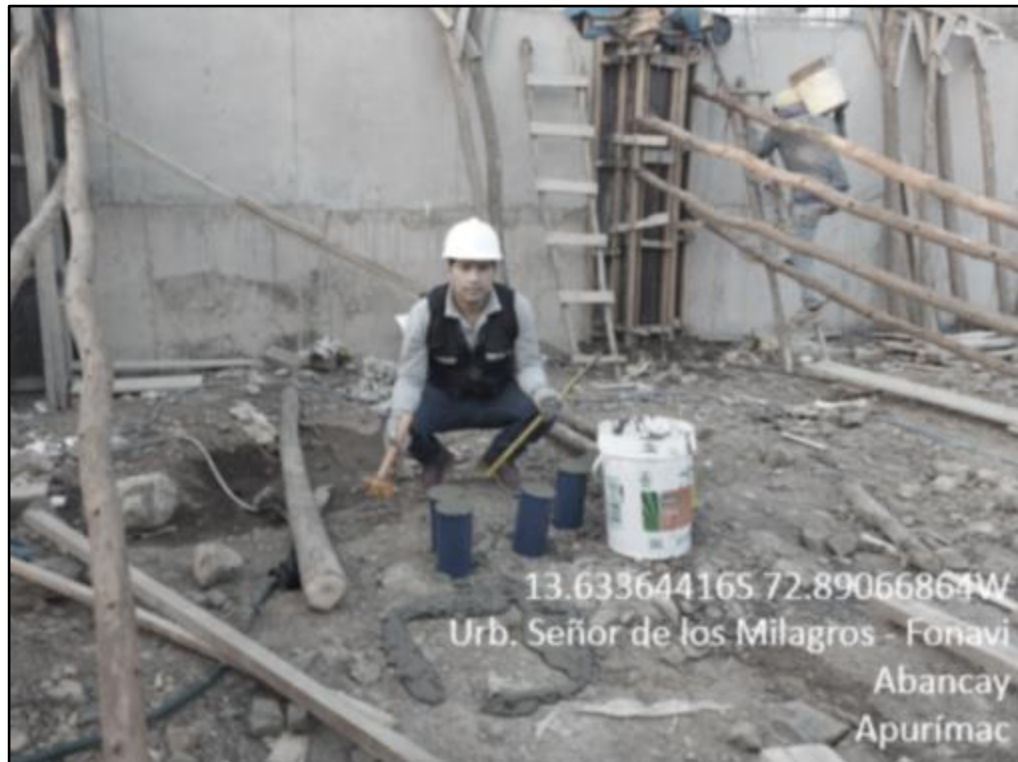
Figura 51 — Elaboración de probetas de concreto
