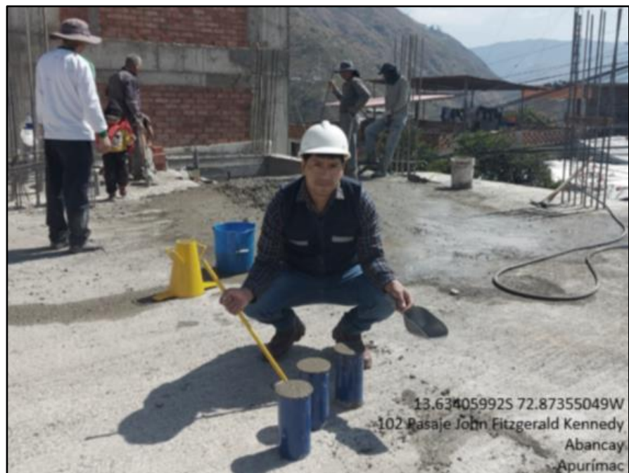
Figura 12 — Elaboración de probetas de concreto.
