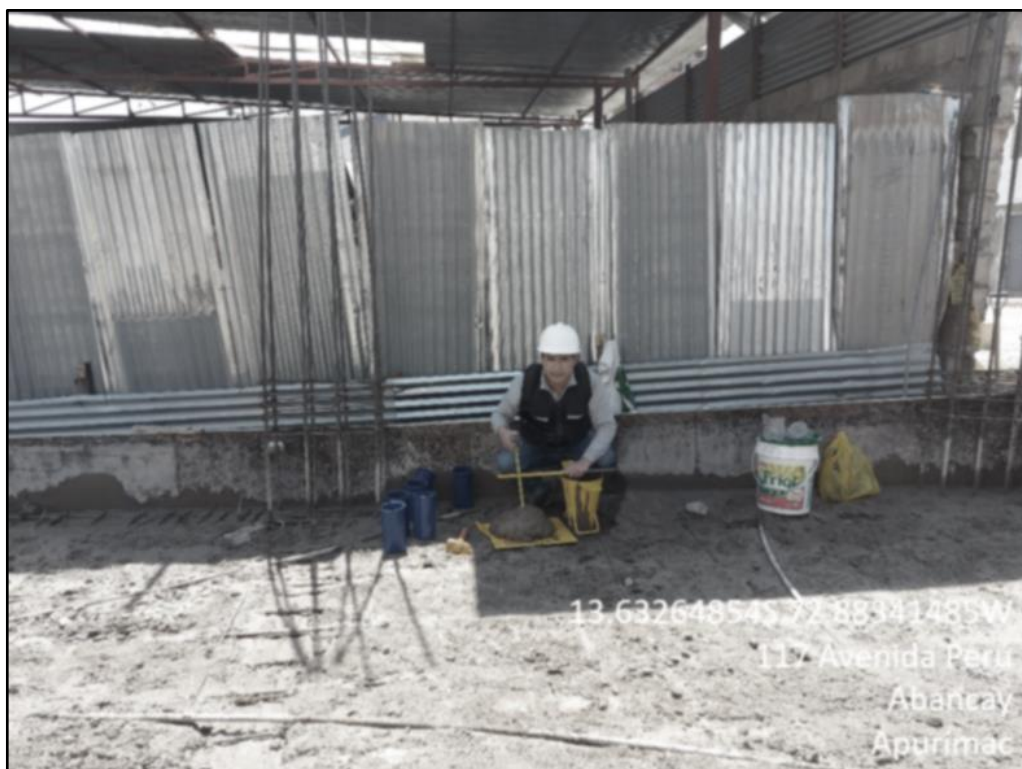
Figura 48 — Ensayo de asentamiento del concreto
