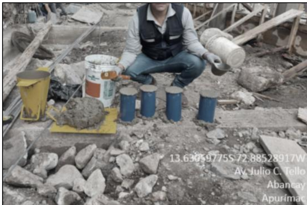
Figura 46 — Elaboración de briquetas de concreto
