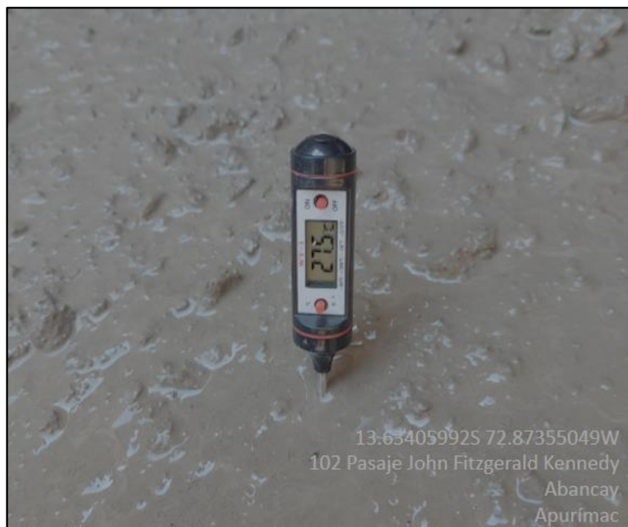
Figura 9 — Vivienda 01. Ensayo de temperatura del concreto
