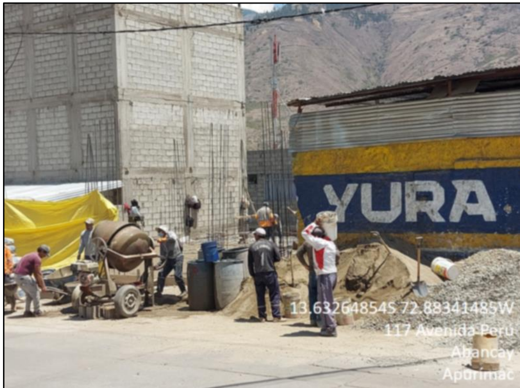
Figura 47 — Elaboración del concreto y vaciado de losa aligerada
