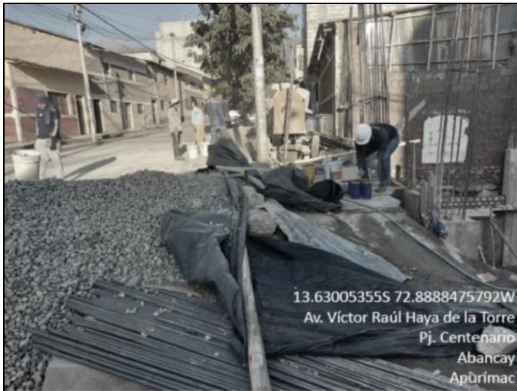
Figura 49 — Elaboración de probetas de concreto
