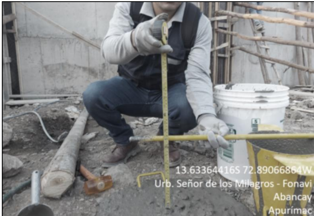
Figura 52 — Ensayo del asentamiento del concreto
