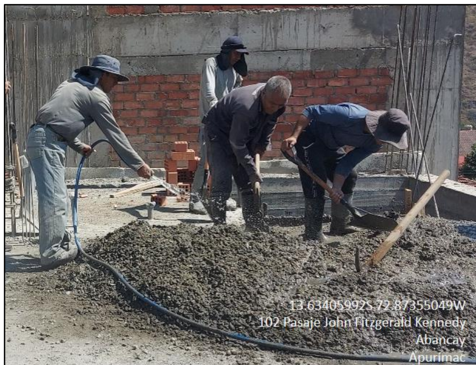
Figura 4 — Elaboración del concreto con herramientas manuales
